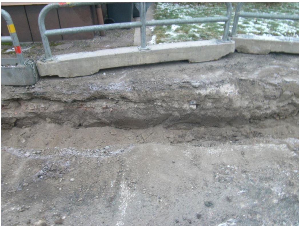
Figur 7. I kvarteret Färgaren (punkt M) fanns ett lager med mylla med grusinslag. Foto mot nordöst.
