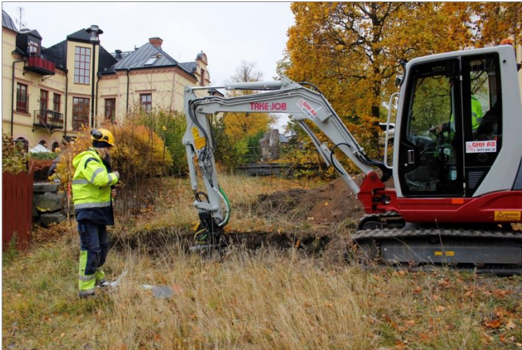
Figur 24. Pågående schaktning av schakt 1. Anna Ölund övervakar arbetet. Foto mot NV. Emelie Sunding,
