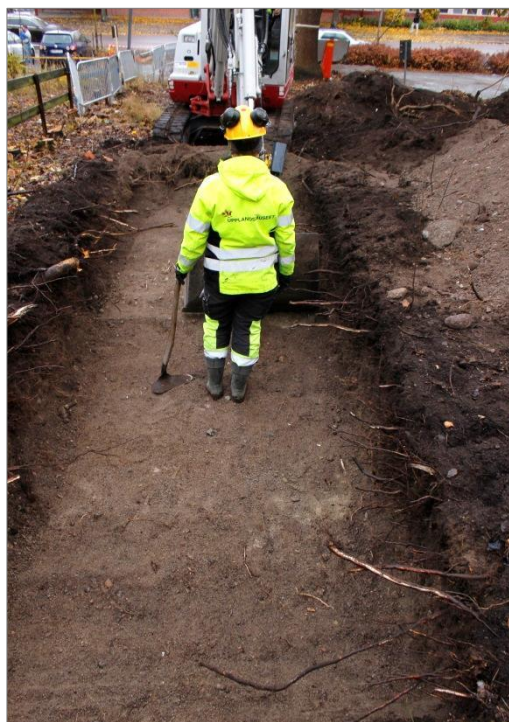
Figur 63. Pågående schaktning av schakt 8. Foto mot SÖ. Anna Ölund, Upplandsmuseet.
