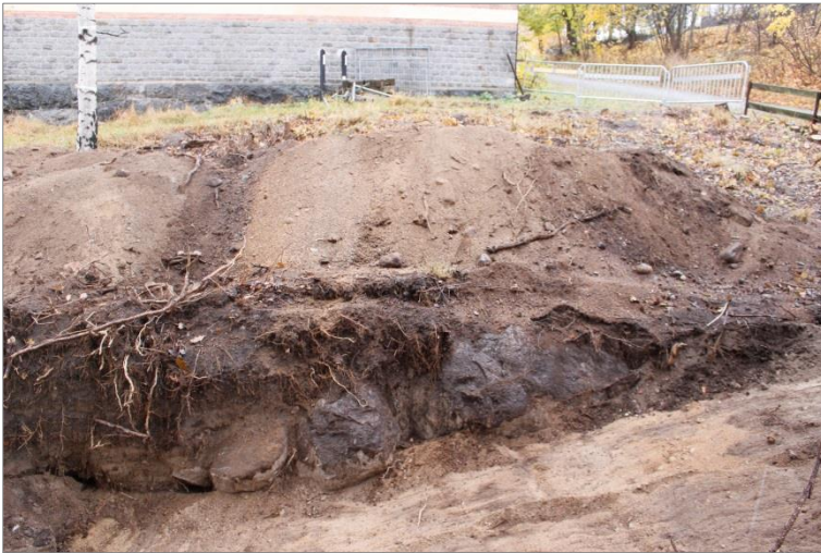
Figur 60. I den nordvästra schaktkanten fanns ett fåtal större stenar som lagts ut i slutningen för att stabilisera upp och förhindra ras. Foto mot NV. Emelie Sunding, Upplandsmuseet.
