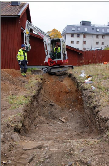
Figur 31. Schakt 2 färdigrävt. I schaktet fanns ett ledningsschakt med ett saltglaserat keramikrör från Skromberga bruk. Foto mot SV. Emelie Sunding, Upplandsmuseet.
