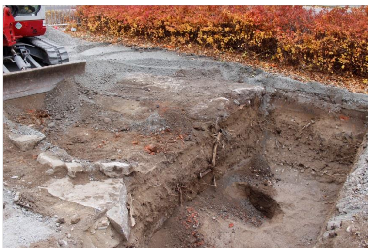
Figur 42. Pågående schaktning av schakt 5. Under parkeringsytans gruslager och raseringslager 520 fanns delar av en kraftig stensyll, 600. Foto mot SÖ. Emelie Sunding. Upplandsmuseet.
