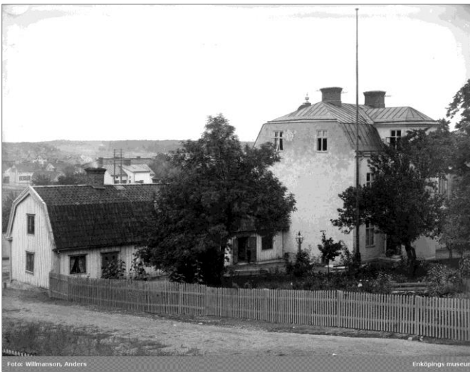
Figur 14. Bebyggelsen utmed Kungsgatan fotograferad från Skolgatan (Norra Ringgatan) september 1908. Foto Anders Willmanson, Enköpings museum.
