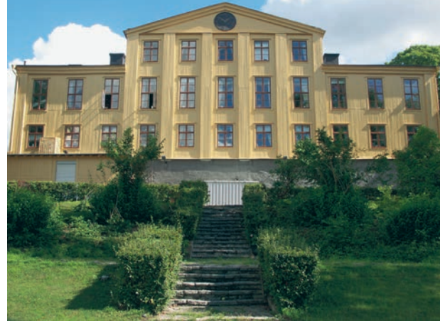
Antikvariskt medverkan i samband med målning av fasad och fönsterbågar på huvudbyggnaden på Krusenbergs herrgård. Foto Agnetha Pettersson.
