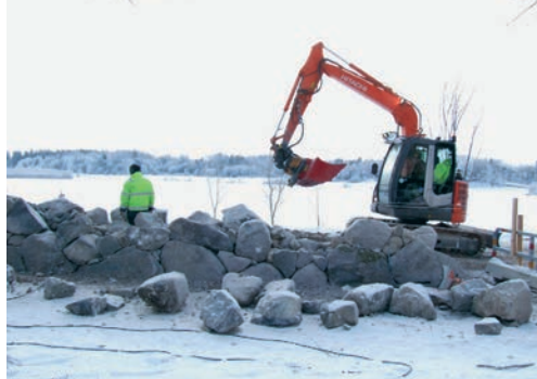
Arkeologisk övervakning i bitande kyla, i samband med omläggning av kyrkogårdsmuren vid Svinnegarns kyrka, Enköpings kommun. Foto Anna Ölund.
