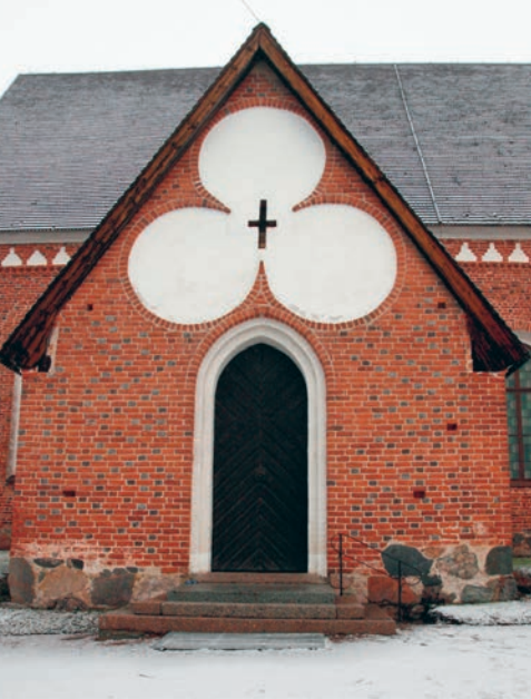
Upplandsmuseet var antikvariskt medverkande när underhållsåtgärder vidtogs vid Vendels kyrka, bl.a. nytt räcke till vapenhuset. Foto Ulrika Sahlsten.
