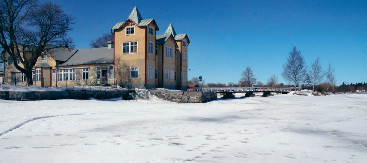
Östhammars badanstalt grundades 1882 och hade sin glansperiod från 1880-talet och en bit in på 1930-talet. Societets-huset uppfördes 1885 men har tillbyggt i omgångar. Foto Sverker Larsson.
