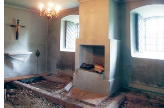
Vid renoveringsarbete i Ärentuna kyrkas sakristia påträffades vid den arkeologiska undersökningen tidigare okända källarmurar. Foto Anna Ölund.
