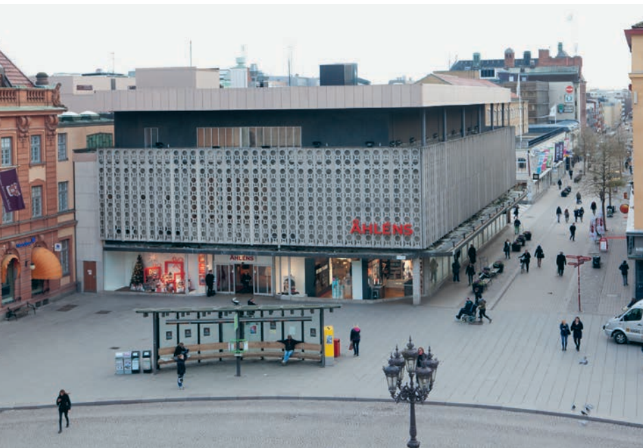
Åhlénshuset Uppsala. Foto Olle Norling.
