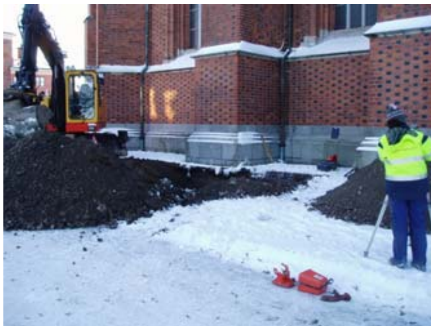
Figur 7. Schaktning för radonbrunn på norra sidan om kyrkan. Foto Bent Syse, Upplandsmuseet.
