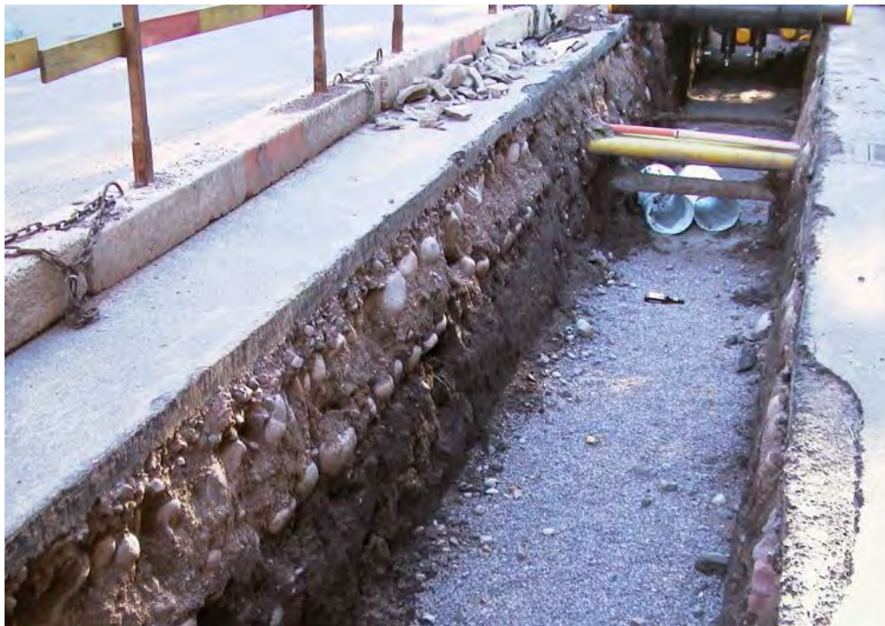
Figur 15. Sydvästra schaktkanten i schakt IV. Här syns de äldre gatubeläggningarna tydligt.
