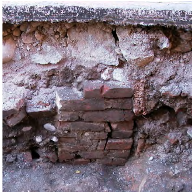
Figur 11 (th). En källarglugg i Åsgränd. Den ena sidan av den dörröppning som syntes i schakt III. I mitten av det murade partiet skymtar stapeln till ett gångjärn. Foto från nordväst.
