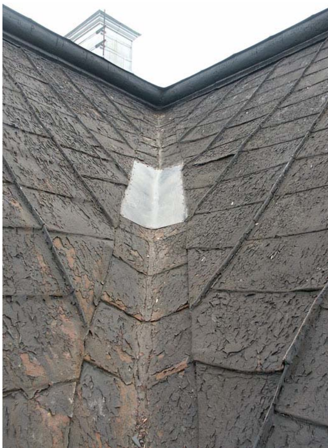
Den gamla plåttäckningen med den spruckna och flagnande färgen. I rännaldalen syns en tidigare ilagning i plåten.
