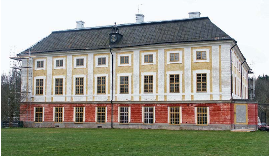
Slottets norra sida före renoveringen när ställningarna rests på östra gaveln.
