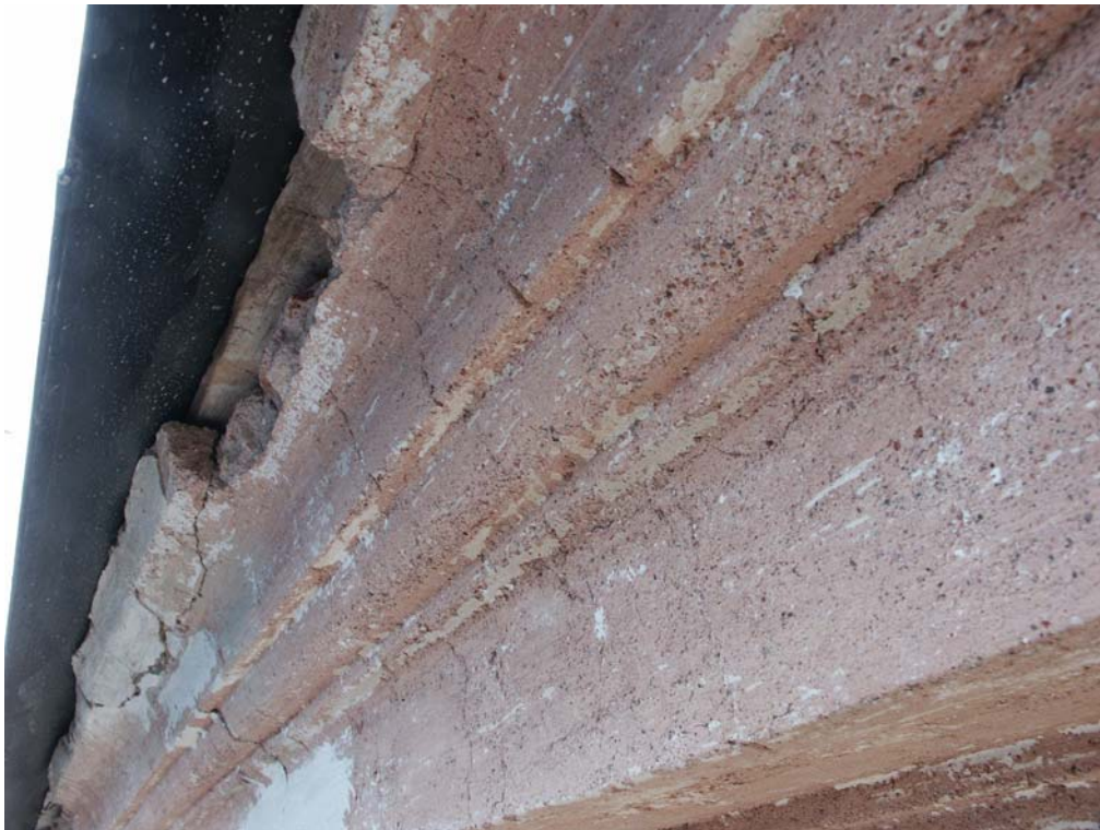
Takfoten är putsad på 1700-talet med ett rödaktigt kalkbruk som innehåller krossat tegel.
