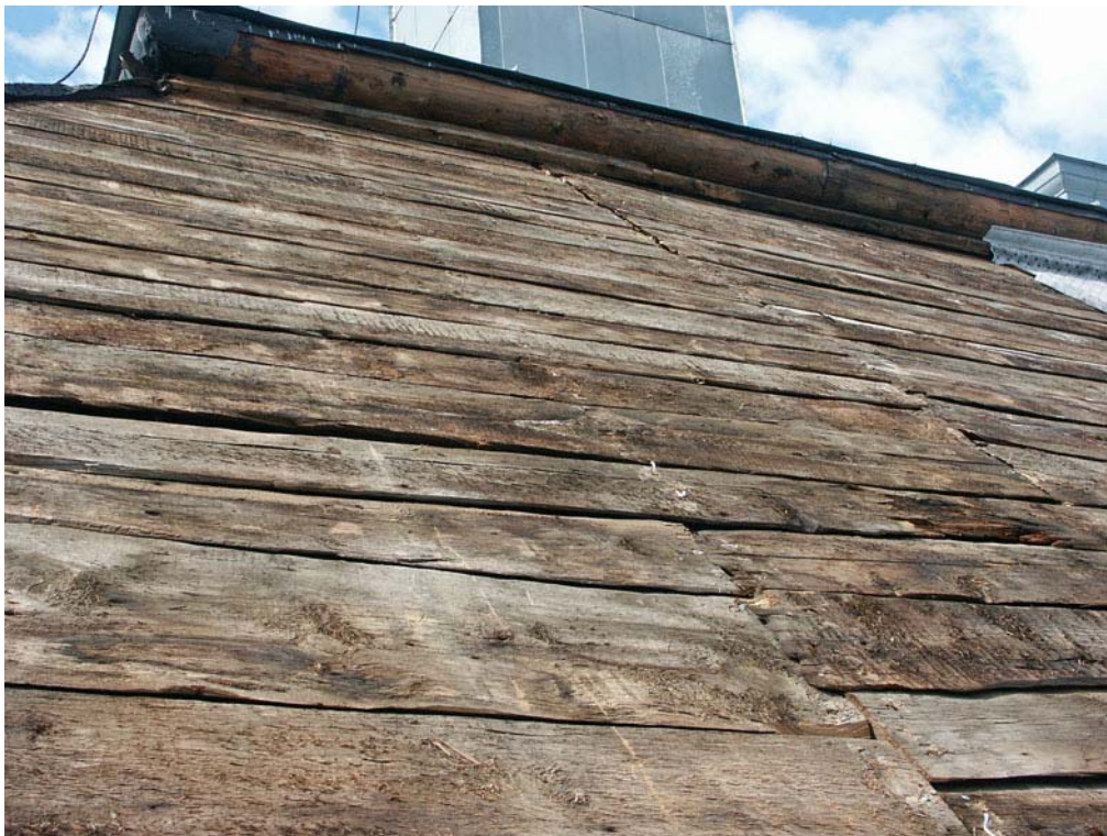
Det gamla brädunderlaget var till största delen i gott skick och bevarades.
