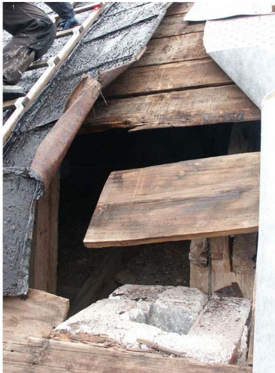
Avhuggen skorsten innanför takfoten på södra sidan av östra halvan av slottet.
