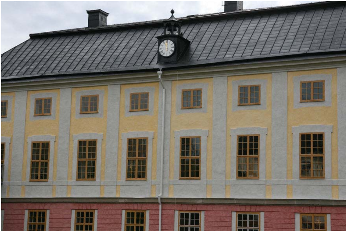
Fasad mot norr efter avslutad renovering, oktober 2007. Urtavlan är åter målad vit i ursprunglig stil. Stuprören har försetts med nya skarpa knän, vattkuper och utkastare samt målats i samma färg som de putsade lisenerna. På översta våningen har de putsade omfattningarna från 1970-talet ersatts av målade omfattningar på slätputs. Plättaket är målat med svart linoljefärg.
