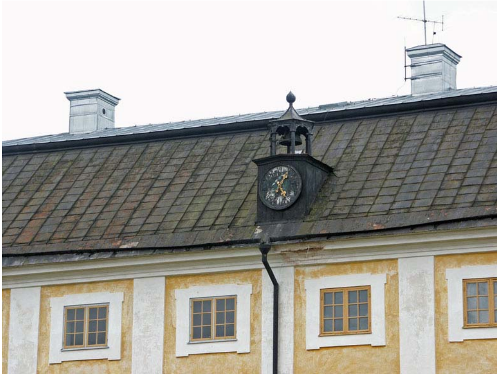
Plåttäckningen från omkring 1750, ett av mycket få bevarade plåttak från denna tid. Norra takfallet med urtavlan och klockuppgnaden.
