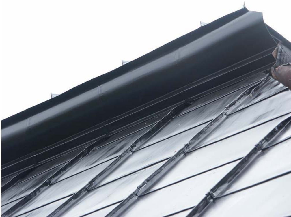
Nylagd plåt. Omtäckning av den plåttäckta vulsten mellan övre och nedre takfall pågår.
