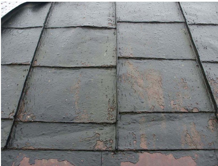
Detalj av den gamla takplåten på norra takfallet. Hakfalsarna är lagda med viss förskjutning.
