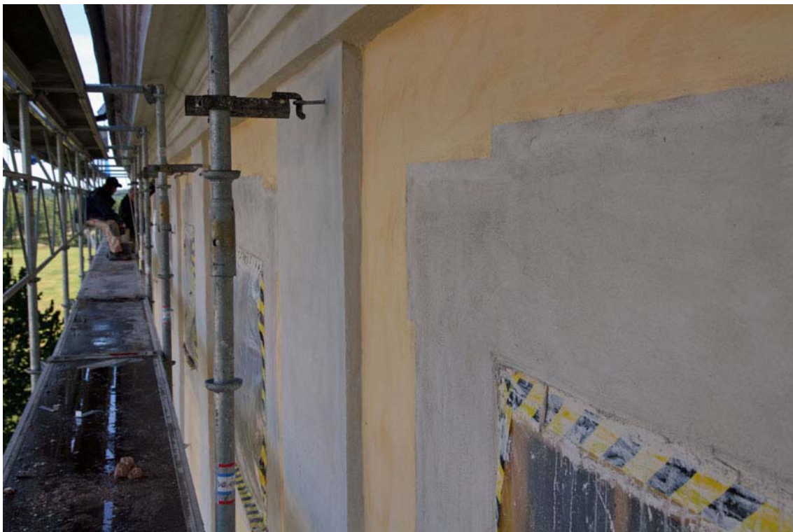
Kalkmålningen är nästan klar. Översta våningens fönster har fått målade ljusgrå omfattningar lika ursprungligt utförande.
