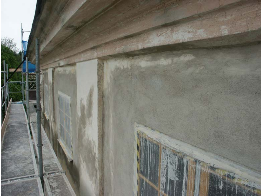
Putslagning av takfoten och efter de tidigare utkragande fönsteromfattningarna.
