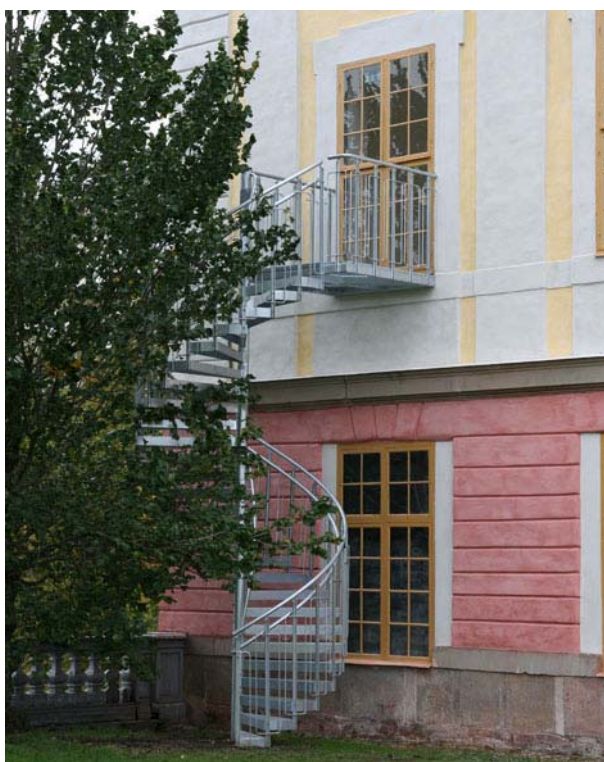
På norra fasaden monterades en utrymningstrappa från riddarsalen en trappa upp. Detta var ett krav från kommunens räddningstjänst. Trappan är reversibel och har inte medfört några ingrepp i byggnadsstommen.
