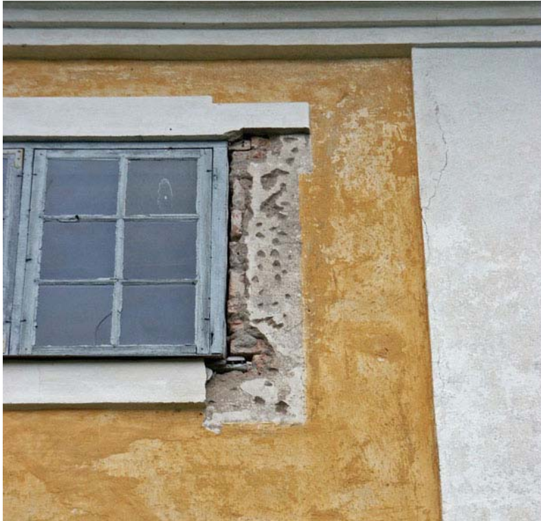
De utskjutande putsomfattningarna under takfot tillkom på 1970-talet. När de knackas bort kommer delar av den tidigare ytputsen fram. Här ses rester av tidigare ljusgrå släta omfattningar.
