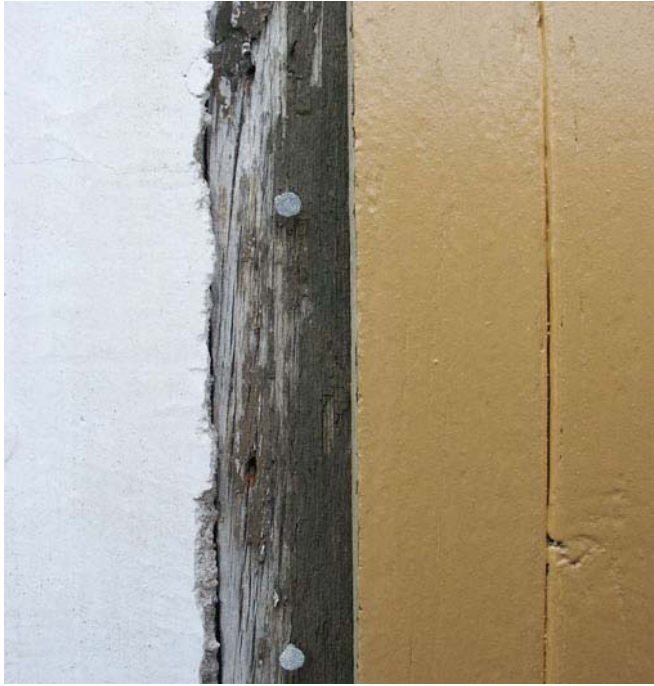
Fönsterkarm från 1600-talet som varit överputsad. Spår av ursprunglig brun färg kan skönjas.
