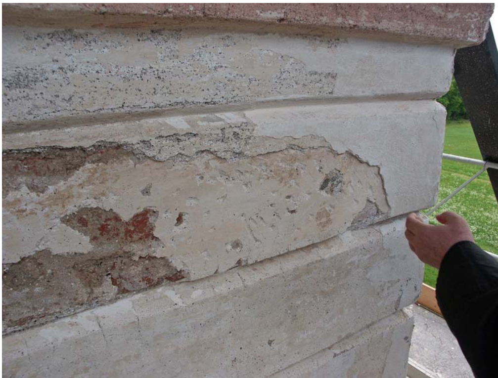
Hörnlisen på östra fasaden under takfot med bevarad puts från 1600-talet. Putsen är glättad och mycket slät och har en gulbrun färg. Den varmvita färgen mitt i bilden är kalkfärg från 1600-talet.
