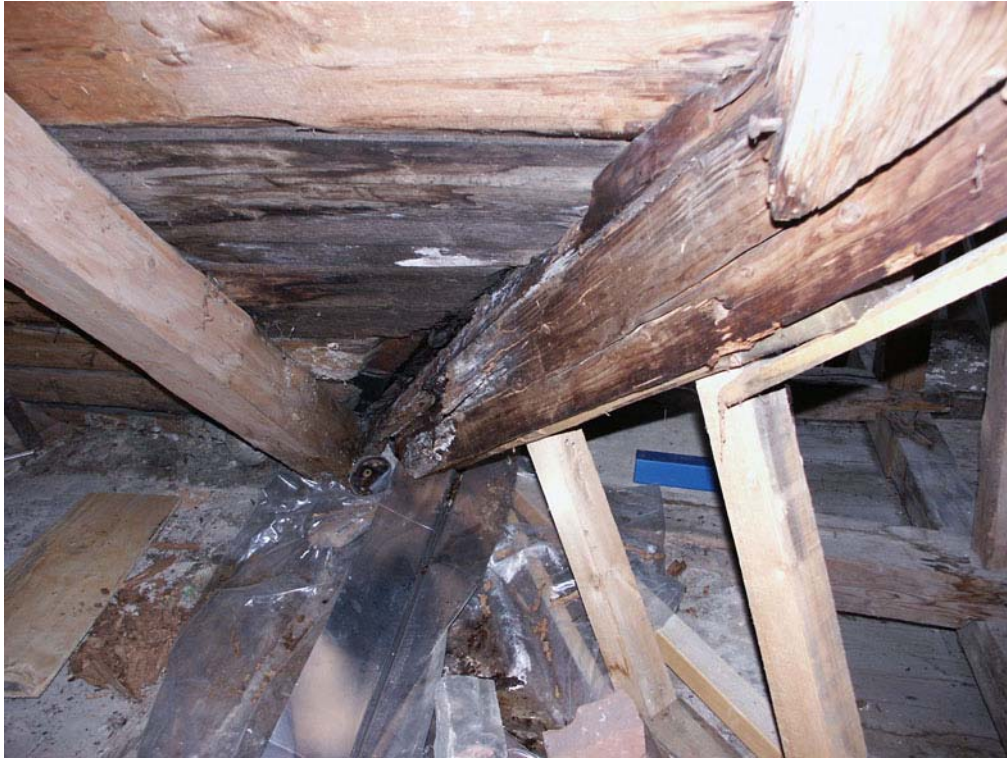
Rötskador i takstommen i anslutning till det inre hörnet.
