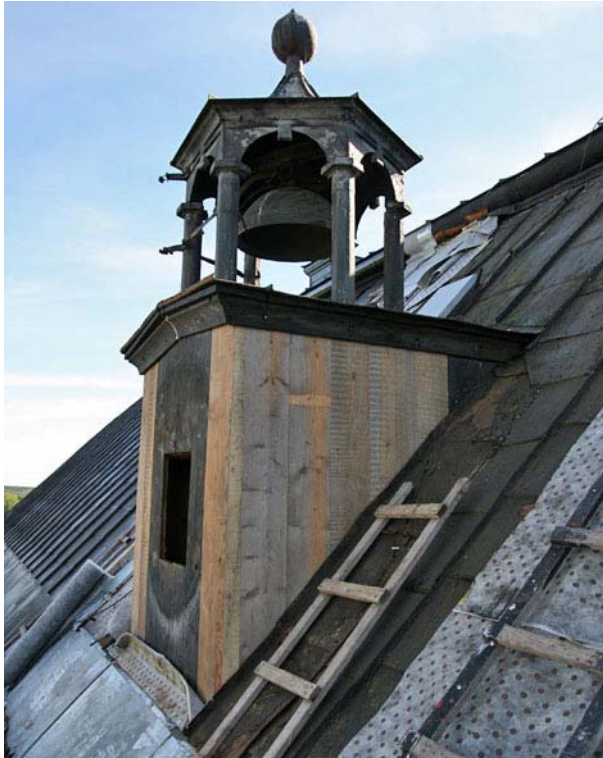
Takkupan på norra takfallet under reparation.
