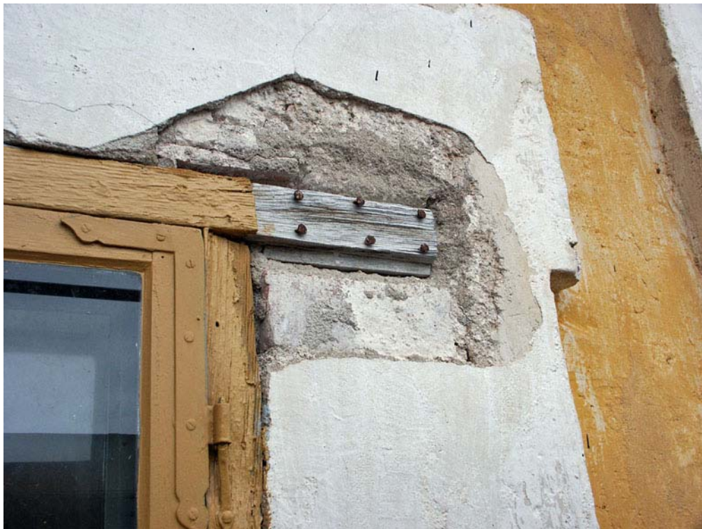
Här ses ett fönster med sentida bågar insatta i en ursprunglig karm från 1600-talet som är inmurad i väggen.
