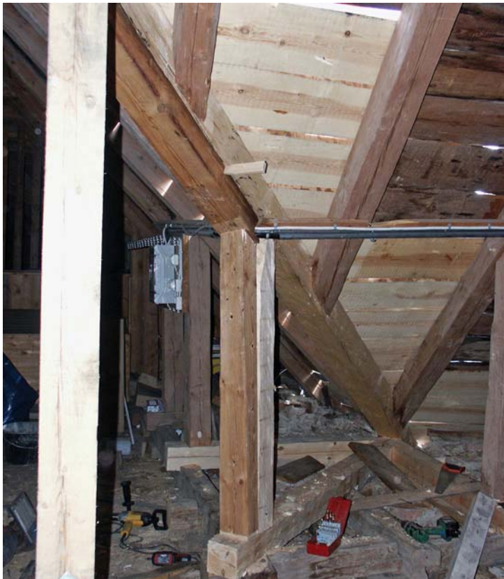
Här har rötskadorna i takkonstruktionen lagats. Skadad underlagspanel är också åtgärdad.
