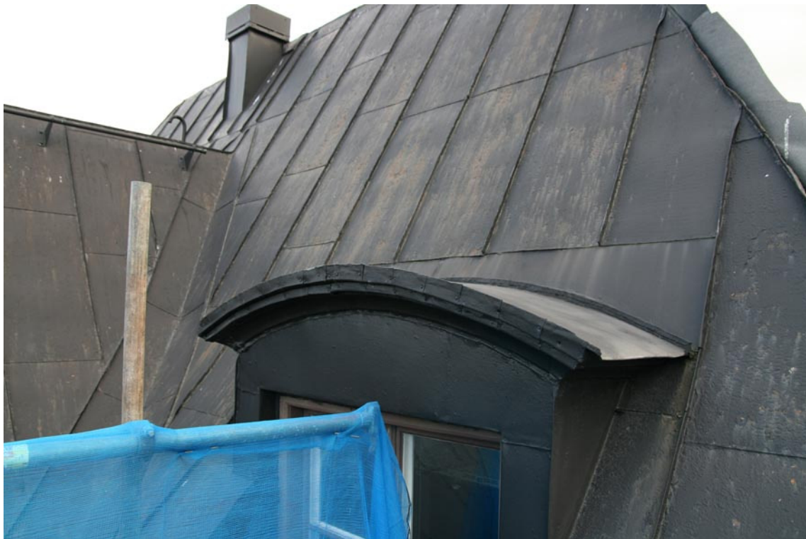
Detalj av takkupa innan den gamla plåten revs av.
