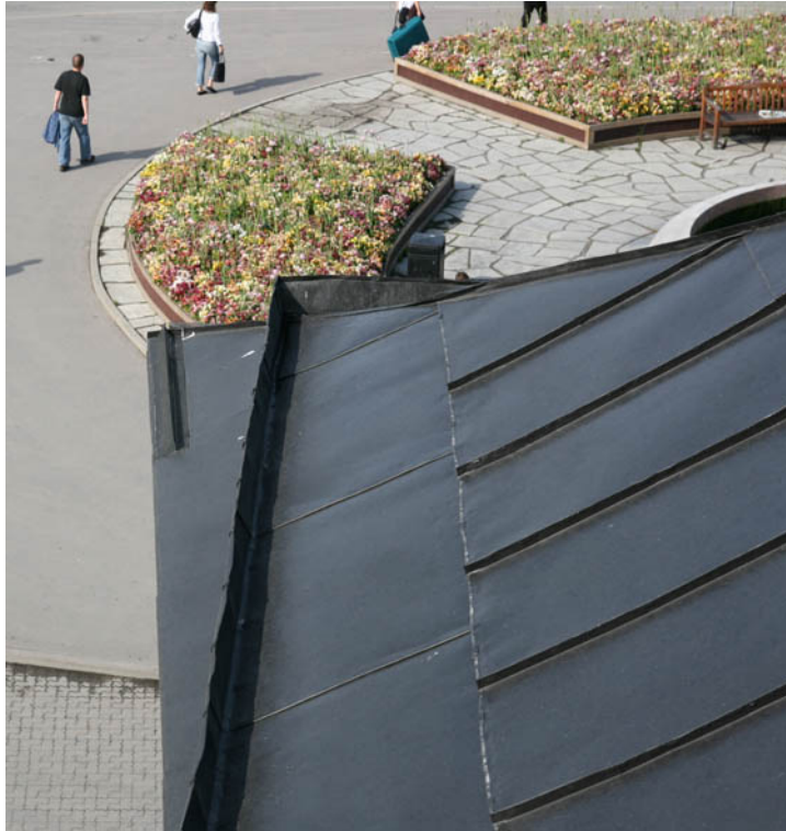
Vid takhörnet ovan, till vänster om fotrännan, ses hur det nya snörasskyddet monterats längst ner på fotplåten.
