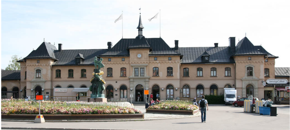
Samma vy i juni 2008. Den nya plåttäckningen har gjorts lika den gamla såväl avseende detaljer som helheten i och med att storleken på plåtarna och skivtäckningens mönster är detsamma.
