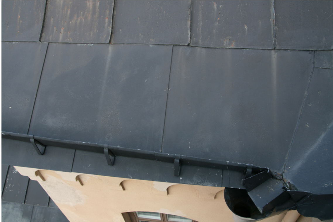
Delar av fotrännan för omläggning. Här var den sedan tidigare utbytt mot ny ränna med konsolkrokar av modernt slag. De nya fotrännorna försågs med traditionella rännkrokar.
