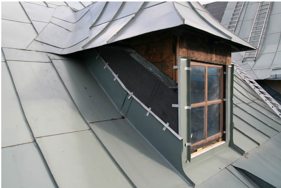
Omklädnad av takkupa pågår.
