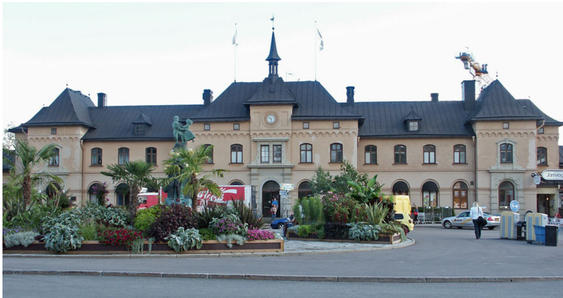
Fasad mot väster i augusti 2007 då den gamla takplåten fortfarande låg kvar.
