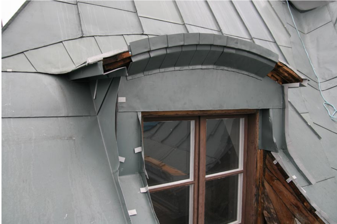
Takkupa lika bild ovan, kläs med ny plåt.
