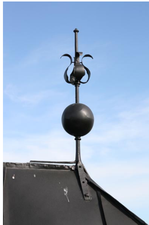
Efter renovering. Skadade blad av zinkplåt och hål i klotet har lagats.
