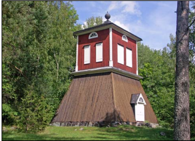
Klockstapeln från sydväst efter avslutade arbeten.
