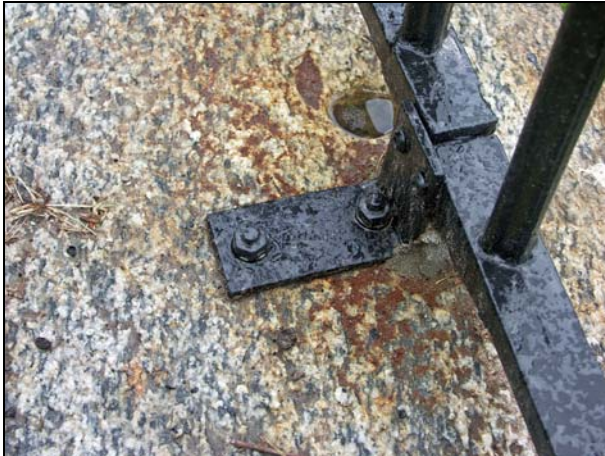
Lagning med vinkeljärn som skruvats i stensockel respektive staketet.
