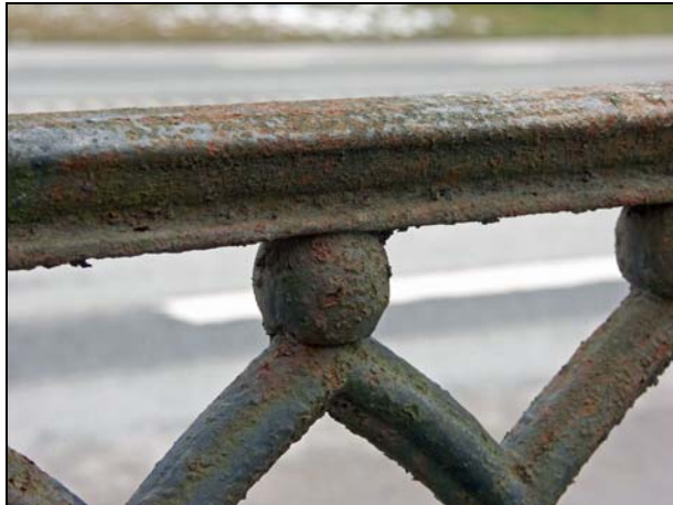
Staketet innan restaurering, med omfattande rostgenomslag och färgflagning
