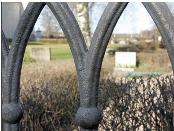
Staketet efter blästring men innan målning.
