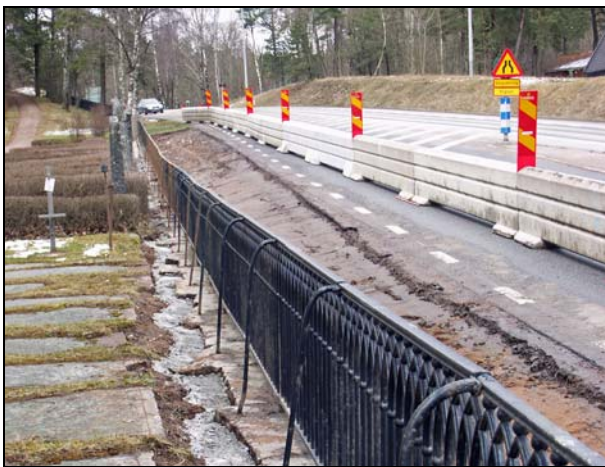
Staketet efter avtorvning, bortschaktning av jord och grus och riktning.
