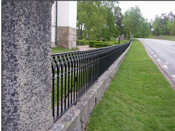
Staketets utsida efter restaurering.
