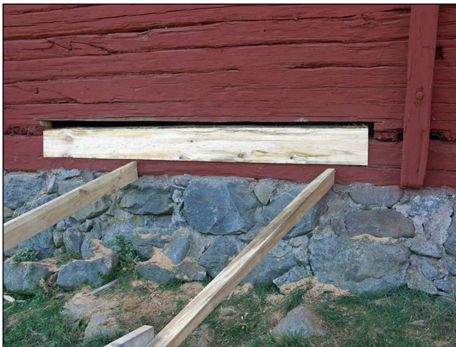
På bodens norra långvägg har rötskadade delar av syllens sågats bort och en bilad timmerstock har provisoriskt lagts på plats för att täcka hålet.
