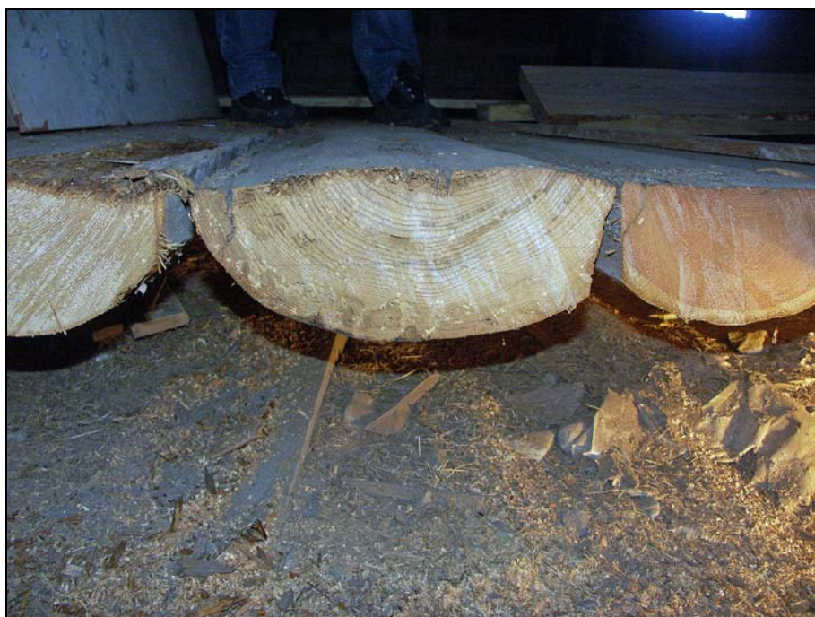
Golvklovor som sågats upp för iskarvning av friskt virke. Klovorna är kanthuggna och sammanfogade med dymlingar.
