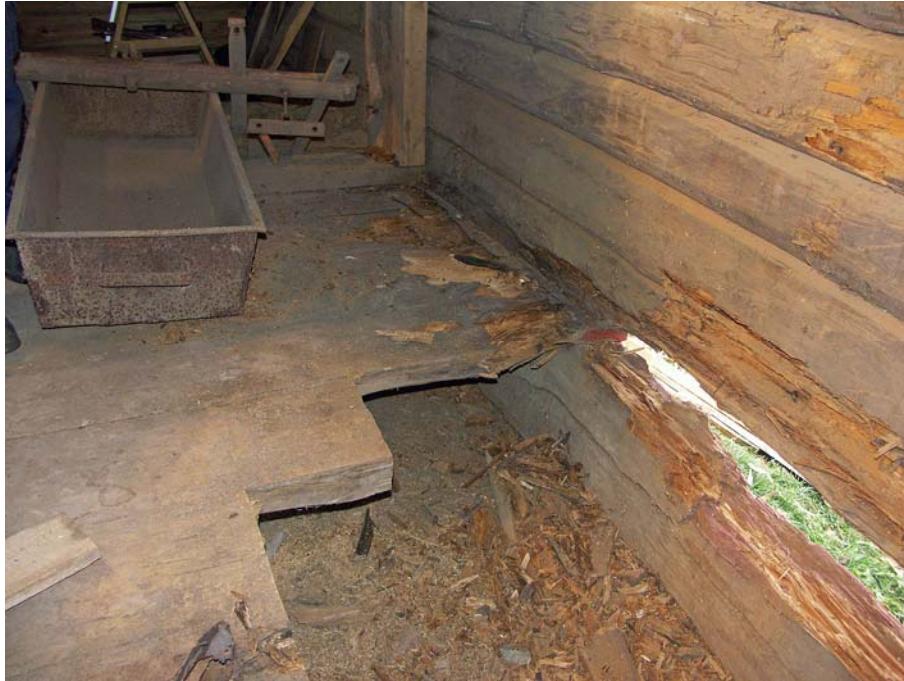
Golvklovor med de rötskadade delarna bortsågade.
