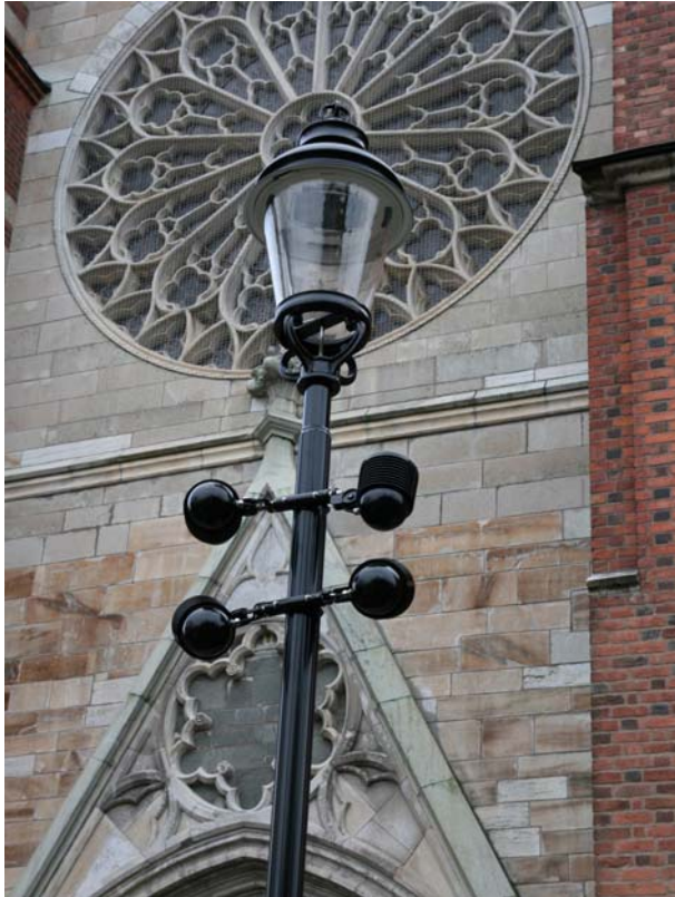
På belysningsstolparna har monterats strålkastare som lyser mot fasaderna.
