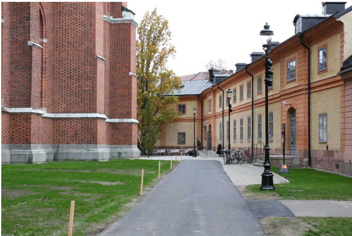
Här ses de nya belysningsstolparna med sina traditionellt utformade armaturer på domkyrkans norra sida.
