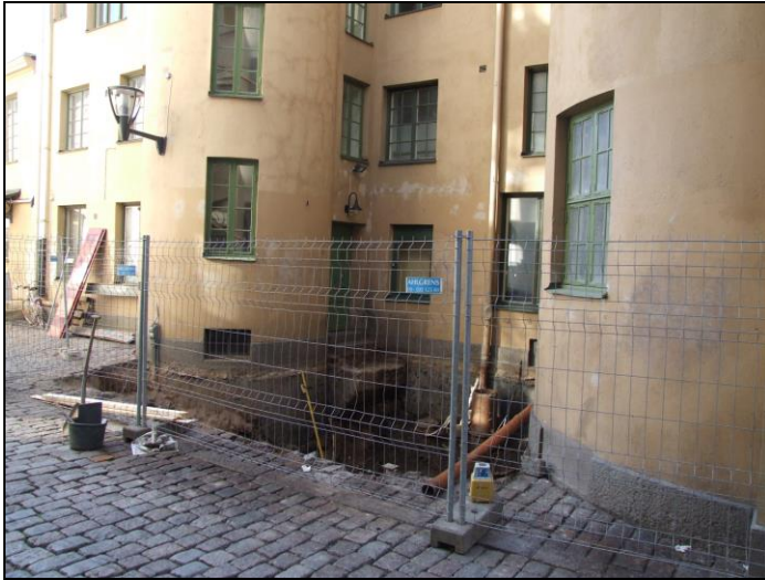
Figur 5. Mellan trapphusen i Påvel Snickares gränd ska den nya hissen placeras. Foto mot Ö av Anna Ölund, Upplandsmuseet.
