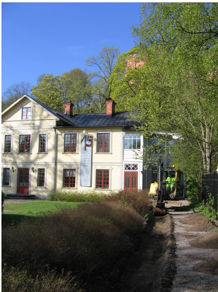
Figur 7. Schaktning in mot Slottskällan. Foto Joakim Kjellberg, Upplandsmuseet.
