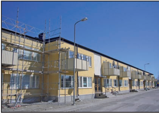
Bild 22: Våren 2009 pågår en totalrenovering av ett kvarter inne i området. Bygglov finns för ytterligare kvarter.
