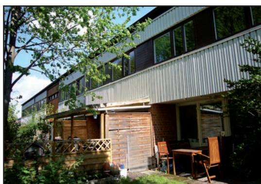
Bild 17: Radhusens eternitplattor byttes ut mot vit bredrandig plåt under 1980-talet.
