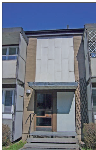
Bild 38: Eternitplattornas horisontella skarvar är viktiga för att skapa en livfull fasad. Även porten och skärmtaket är mycket väsentliga detaljer.
