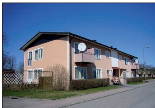
Bild 18: Plåtfasaden och det platta taket byttes ut på huset av typ 4 under 1980-talet.
