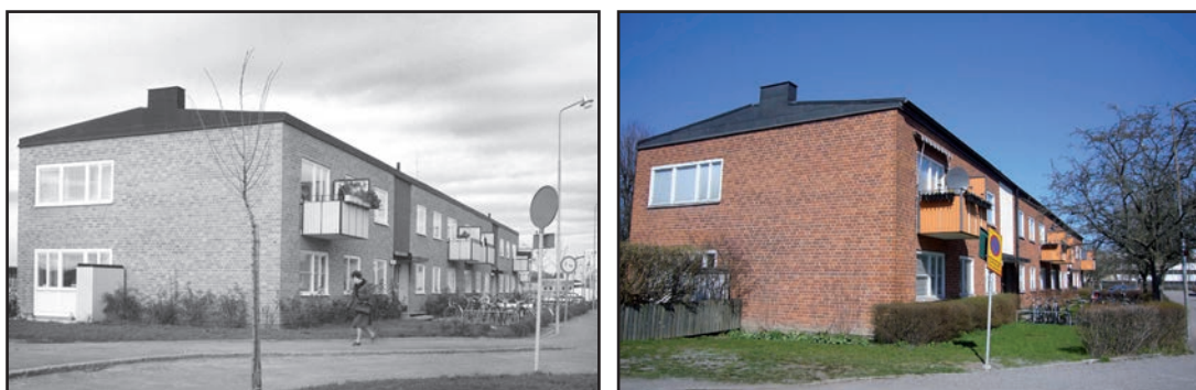
Bild 10 och 11: Hustyp 3 . Balkongfronterna och panelen ovanför portarna byttes på 1980-talet, i övrigt är inte hus av denna typ renoverade. Den vänstra bilden är tagen på 1960-talet och den högra 2009.
