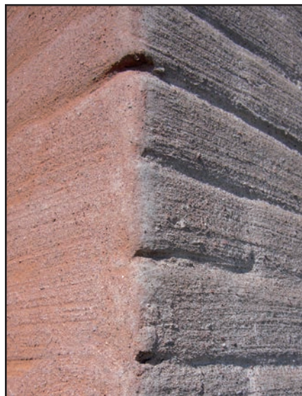
Bild 35: De slammade väggarnas livfulla karaktär framträder framför allt i släpljus. Bilden visar två väggar med olika färgsättning.
