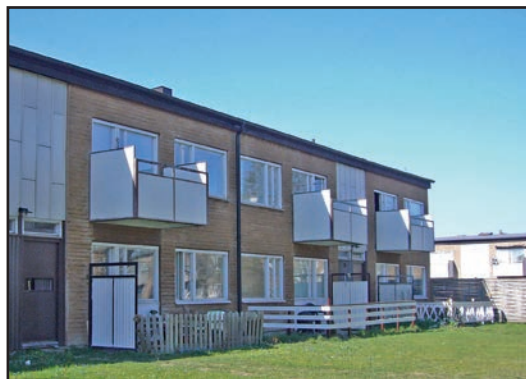
Bild 37: De vita skärmarna är den ursprungliga avskärningen mellan de olika terrasserna. Några staket fanns inte från början.
