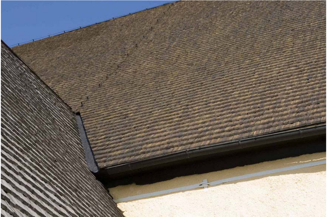
Det nylagda spåntaket på långhusets sydsida. Till vänster ses vapenhusets spåntak. DIG007222
