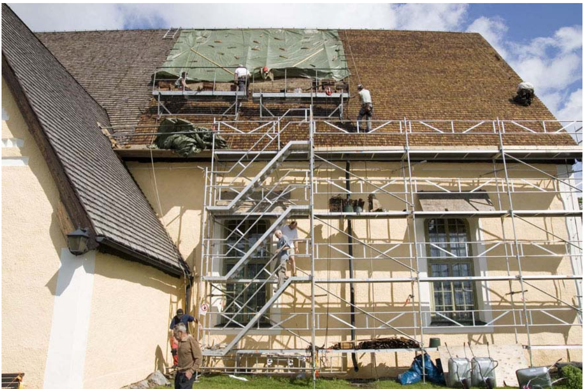
Spåntäckning pågår. DIG005986
