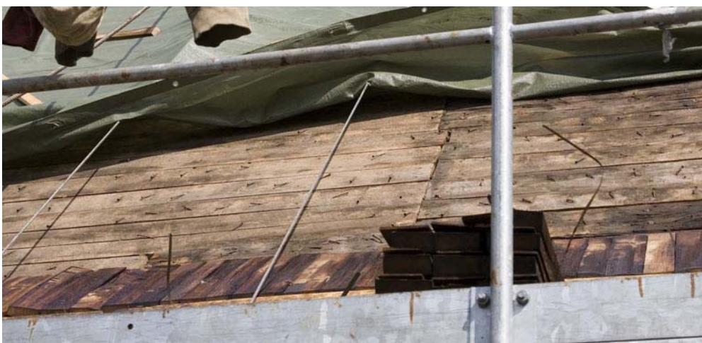
Det gamla brädundertaket har förmodligen tillkommit under 1900-talets tidiga del. DIG005985
