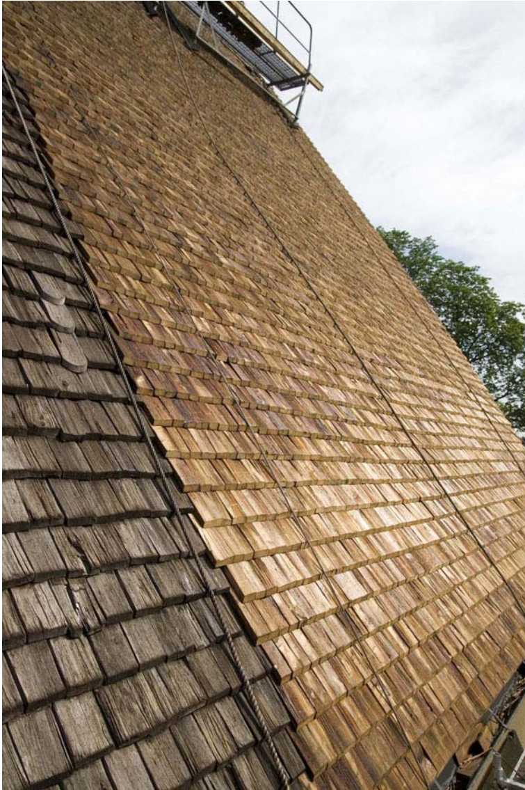
Halva taket är nylagt. Till vänster ligger de gamla spruckna, rötskadade spånen kvar. DIG005791.
