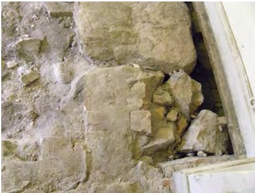
Figur 9. På några ställen fanns spår efter fastmurad tegel på murfundamentet i rum 6.
