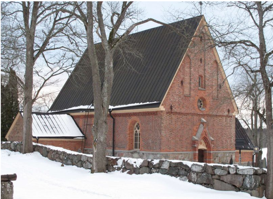
Vy från nordväst i mars 2009 medan den gamla skivtäckningen låg kvar. DIG005034.
