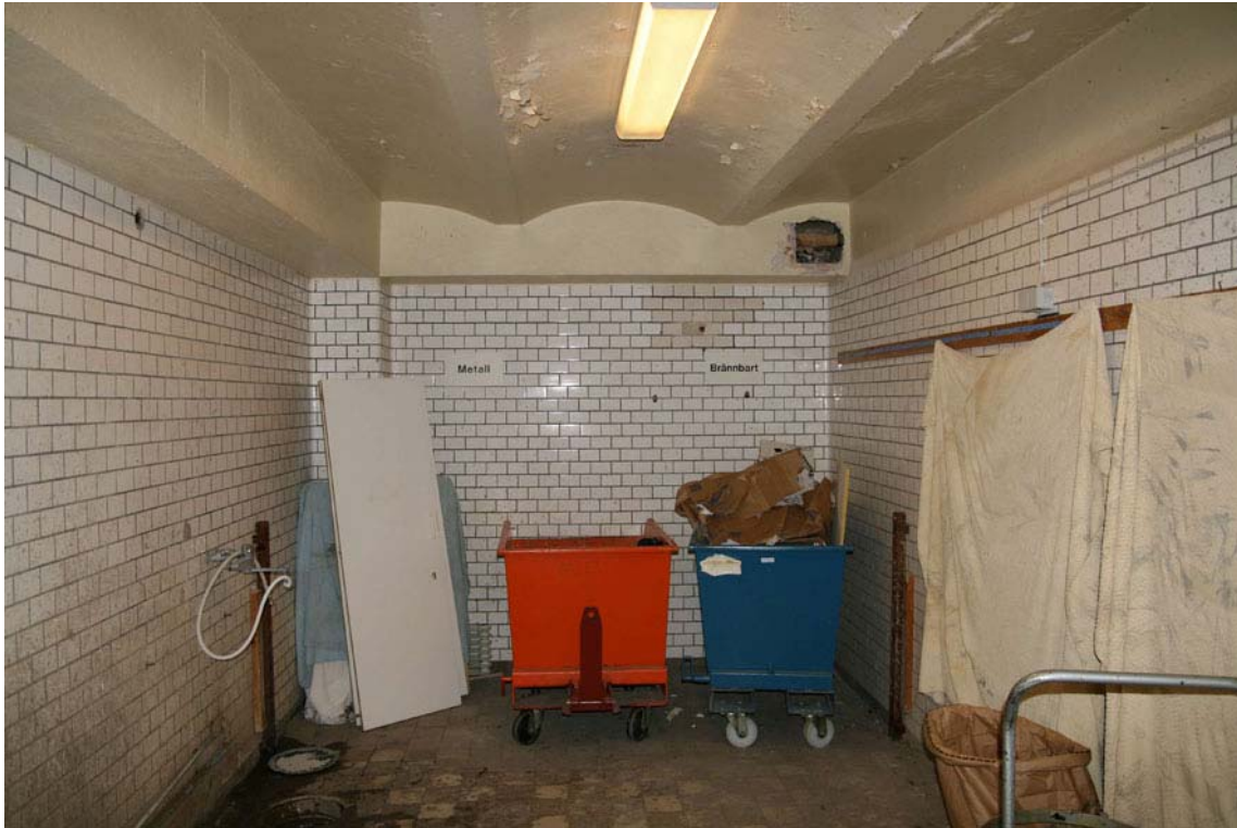
Rum i A7 med äldre kakelbeklädnad av väggarna. Bottenbjälklaget av putsade tegelvalv och stålbalkar är synligt. DIG009150.
