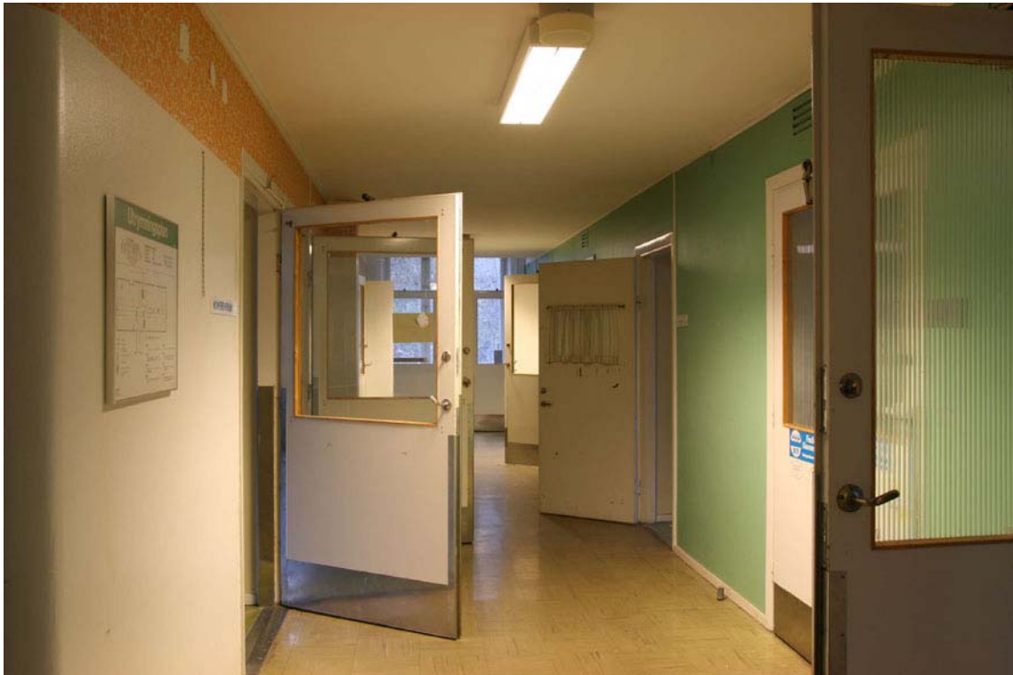
Mittkorridor i A4 med dörrar av 1950-talstyp. Golvet är täckt med linoleumplattor från 1950-talet. DIG009091.
