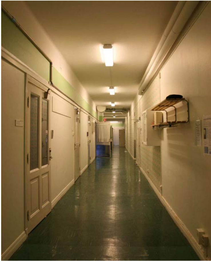
Korridor en trappa upp, plan 4, i hus A3. DIG009097.
