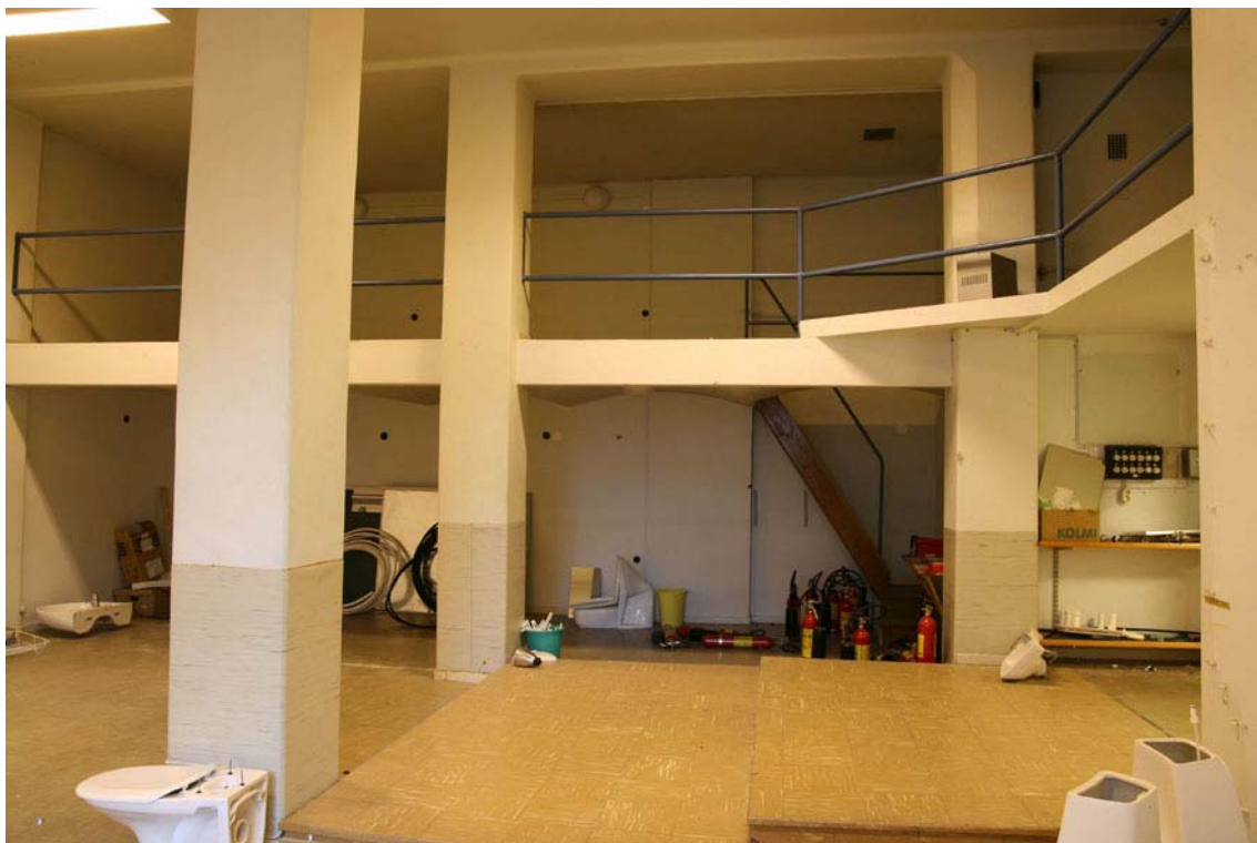
Ett stort entresolerat rum med synlig betongpelarstomme. Ursprungligen sjukhusets huvudförråd beläget i A2 DIG009101.
