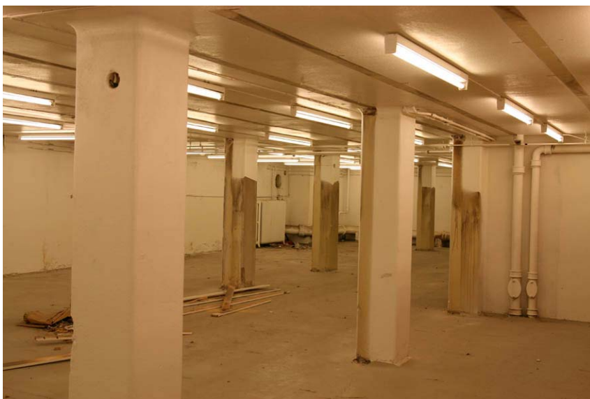
Bilden visar betongpelarstommen i källarvåningen på hus 2 som ursprungligen rymt röntgenplåtarkiv. DIG009302.
