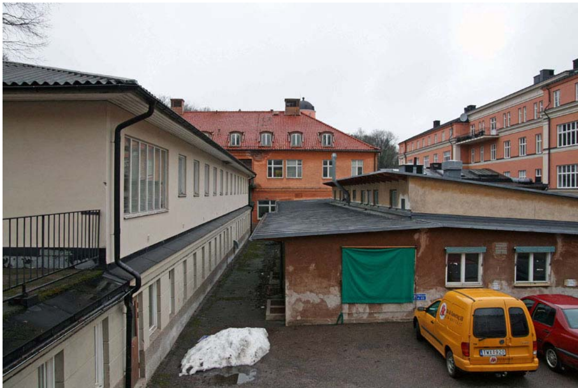
Till vänster ses den långsträckt byggnaden A6 vars bottenvåning uppfördes på 20-talet. Bottenvåningen hade slätputsade fasader på en sockel av granit. Putsen var avfärgad med ljusbeige plastfärg, s1005-Y20R. Påbyggnaden tillkom i slutet av 60-talet. Till höger ses A5. DIG009111.
