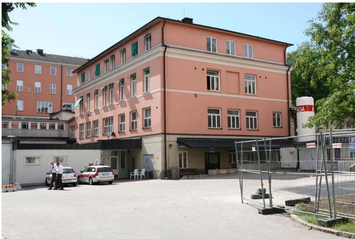
A7 sedd från öster. Sockelvåningen plus utbyggnaden mot norr från 1923 hade ljusbeige slätputs, kulör nära s1005-Y20R. Under den syntes två lager rödrosa kalkfärg, lika A2-A4. Bottenvåningen och de två övre våningarna hade slätputs avfärgad med rödrosa plastfärg. Listverken hade samma ljusa färg som sockelvåningen. Porten i öster med pardörrar var målade i en mörkblå färg. DIG008986.
