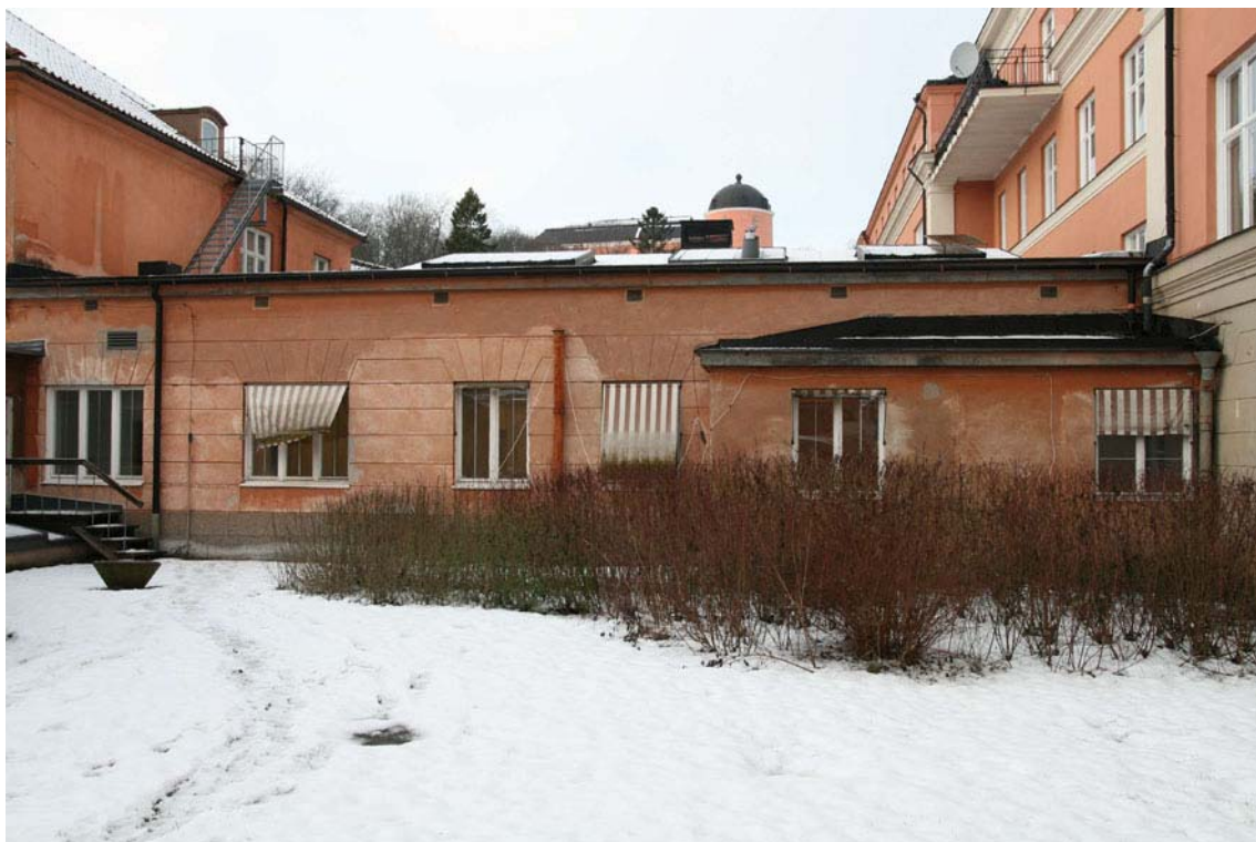
A2, fasad mot söder. Kalkputs med bevarad äldre kalkavfärgning i tegelfärgad kulör. DIG009314.
