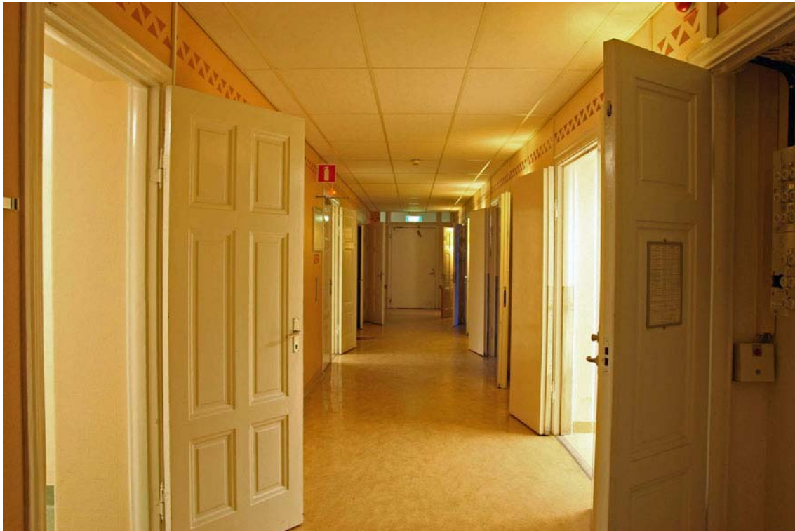
Korridor på bottenvåningen i A3. Taket är nedpendlat för att dölja ventilationskanaler. Ursprungliga dörrar finns kvar. DIG009305.
