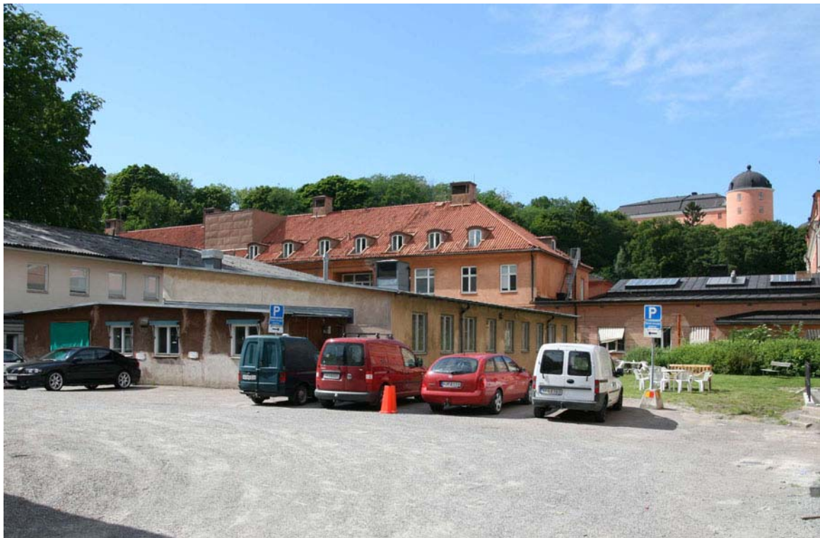
Röntgentillbyggnaden A5 närmast bakom de parkerade bilarna. I bakgrunden ses A2 till höger och A4 med tegeltak. A5 från 1950-talet hade kvar en gammal sliten slätputs med ursprunglig färgsättning bevarad. Putsen var målade i två färger. Den lägre delen mot väster var avfärgad med brun kalkfärg, s4020-Y40R. Den högre östra delen var målade i en gulbeige kalkfärg, s2020-Y20R. Utskjutande takfot med panel och takfotstassar var målade i rödbrunt. Ursprungliga dörrar med stående fernissad panel fanns bevarade liksom vita fönster med ljusgrå karmar. DIG008985.
