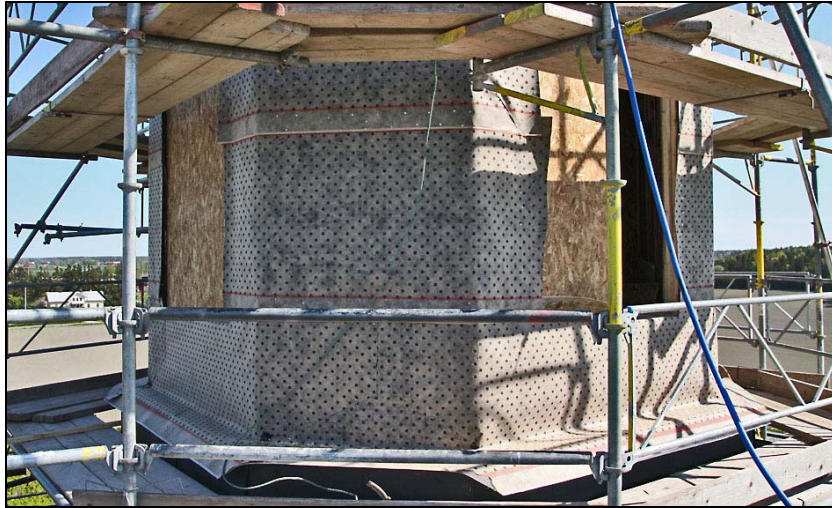
Tornlanterninen efter rivning av befintlig plåtbekädnad, lagning av underbrädning samt uppsättande av underlagspapp.
