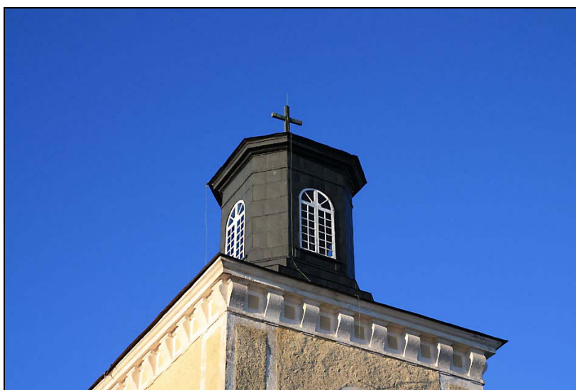
Tornlanterninen innan restaurering. Lanterninen är täckt med småplåtar i slättäckning. Fönsterna har skrapats, trälagats, kittats och målats.
