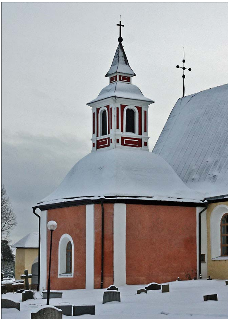
Sakristian efter slutförd restaurering.
