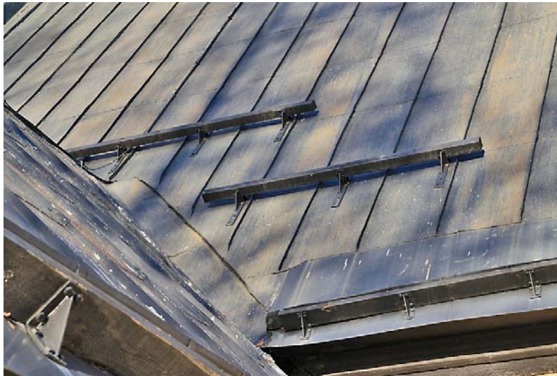
Rännnal mellan långhus och vapenhus innan restaureringen med snörasskydd.
