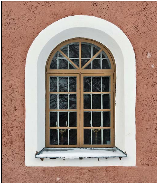
Fönster på sakristian efter restaurering. Bågen har kittats och målats och fönster- blecket har bytts ut.
