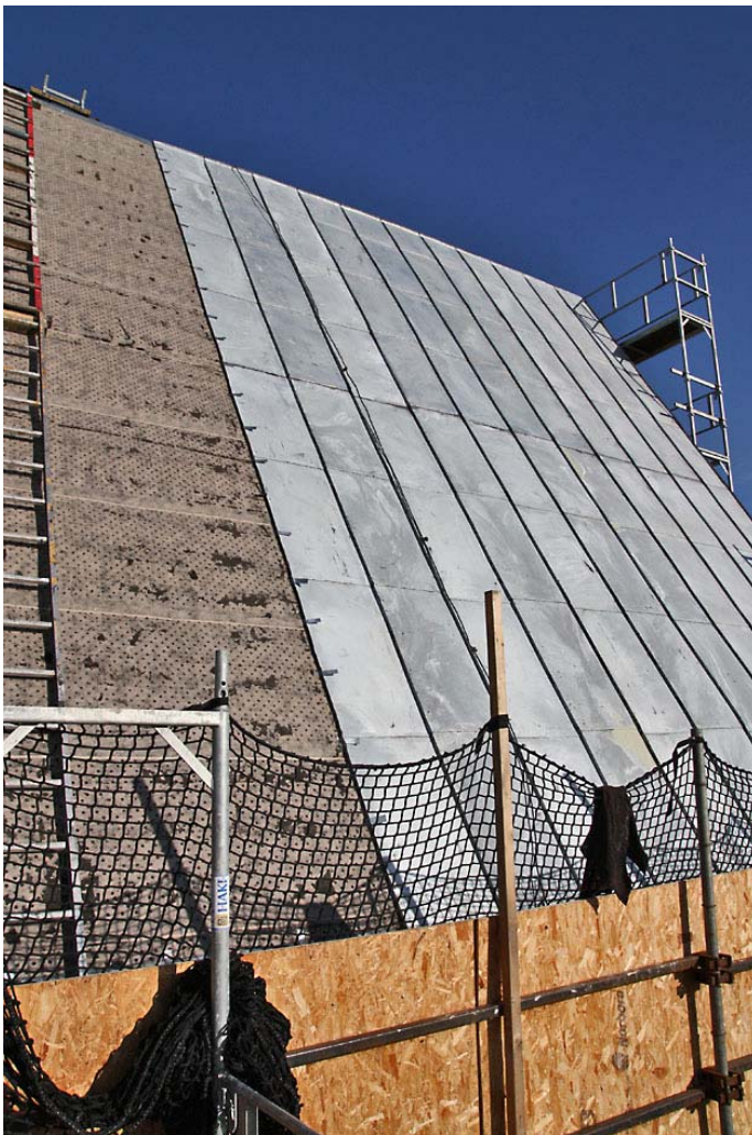
Långhusets södra takfall under pågående plåtläggning.
