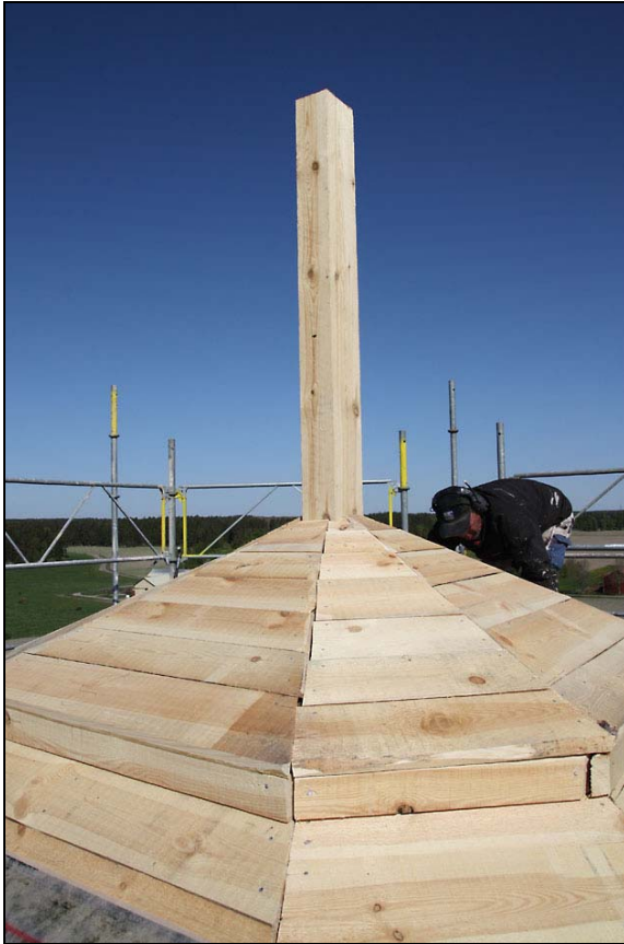
Torntaket efter omfattande trälagningar. Tornet har fått en ny stock för krönkorset.
