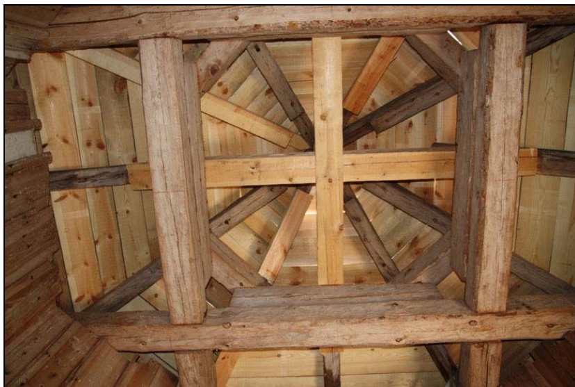
Torntaket efter trälagningar med bland annat iskarvning av nya bjälkar.
