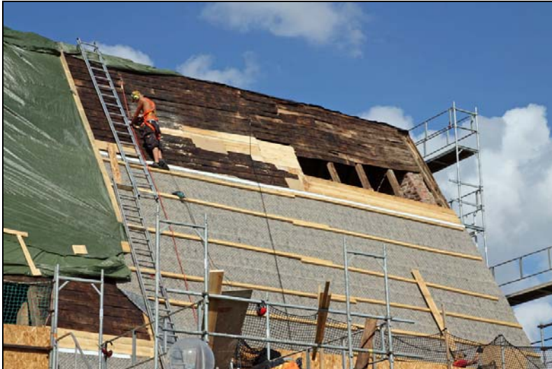
Långhusets södra takfall under pågående plåtläggning.
