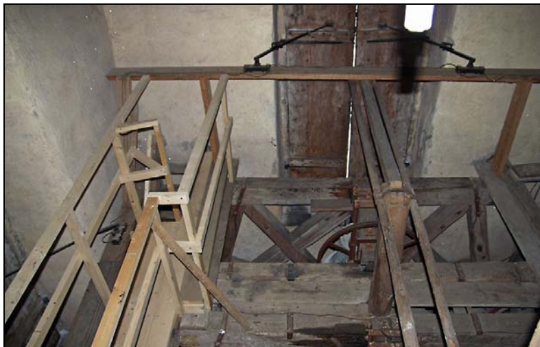
Nya landgångar och räcken sattes upp i samband med restaureringen.
