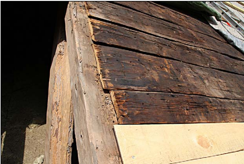
Detalj av äldre underbrädning med ny ilagning.
