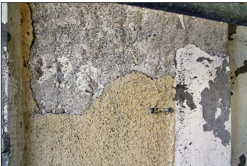
Fasadparti under rengöring. Putsytorna hade många lagningar och olika sorters bruk.
