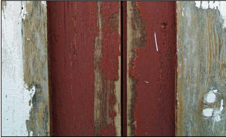
Lanterninens östra fasad innan restaurering: Spontad, stående panel spikad med smidd spik. Bräderna har glidit ur sponten och behöver justeras. På den dolda, södra fasaden finns en liggande panel med snedfasade kanter i stället för spont.
