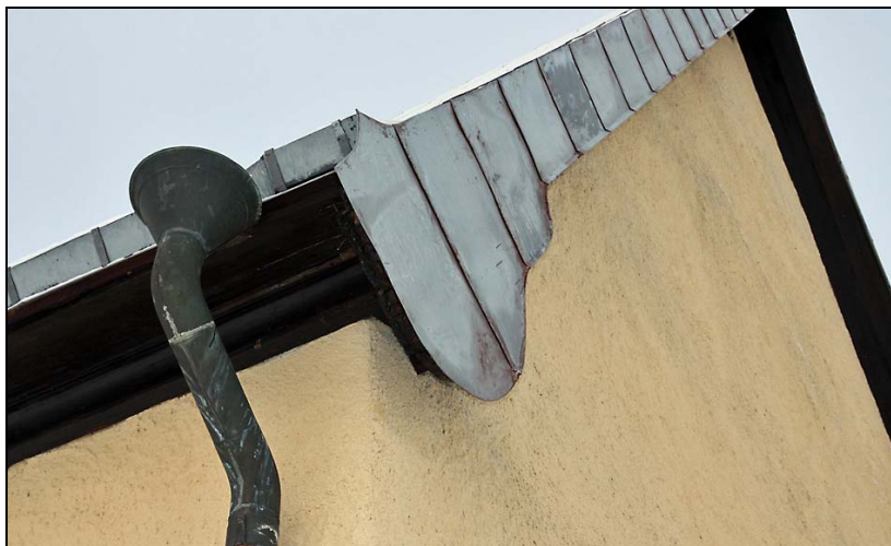
Långhusgaveln efter omläggning av tak. Detalj av gavelskiva.
