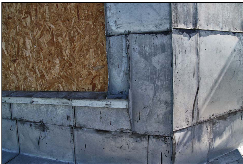
Tornlanterninen efter ny slättäckning med småplåtsformat.
