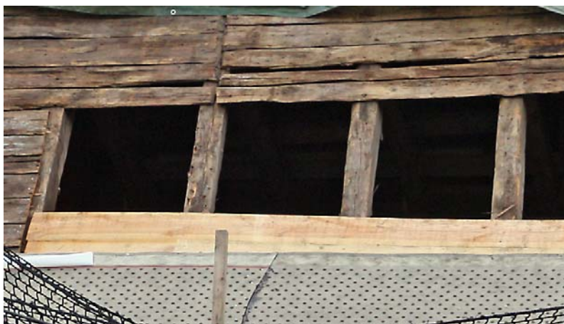
Långhusets norra takfall med bortrivna plätttäckning. Skadad underbrädning har tagits bort och lagning med nya bräder pågår.
