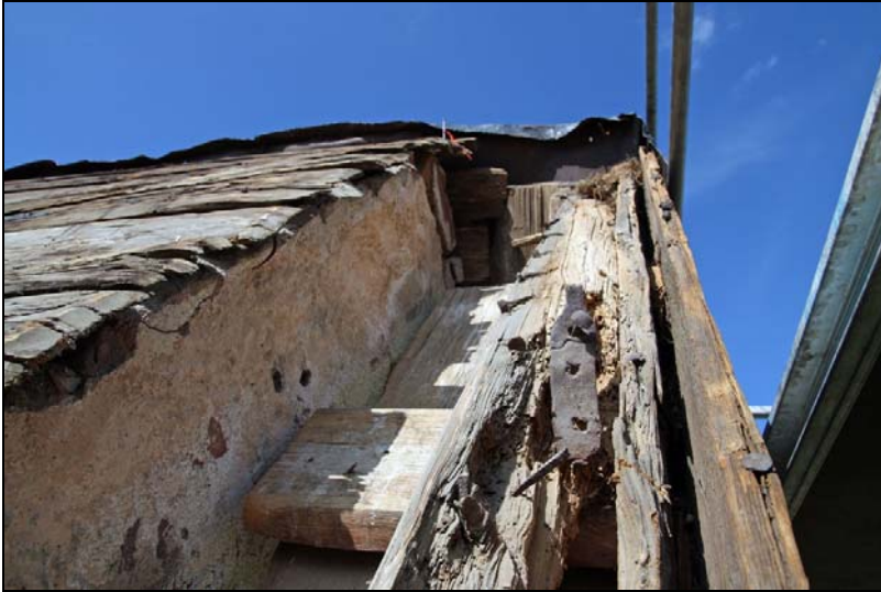
Kraftigt vittrad och rötskadad gavelstock på långhustes östra gavel
