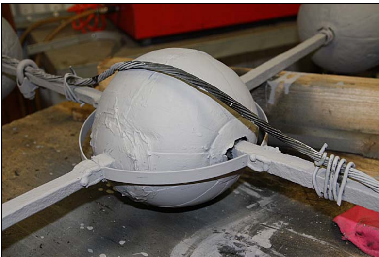
Långhuskorset är gjort med ett kors av smidesjärn med klot av ihoplödda zinkplåtsbitar. Enligt en notering från 1736 ska klotet ha varit förtent.
