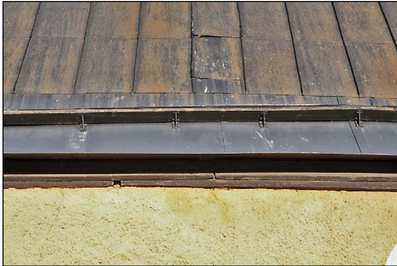
Långhusets södra takfall innan restaurering. Överst i bilden gamla skivtäckningen från 1905, vid takfoten sentida ilagning med förstärkt fotränna.
