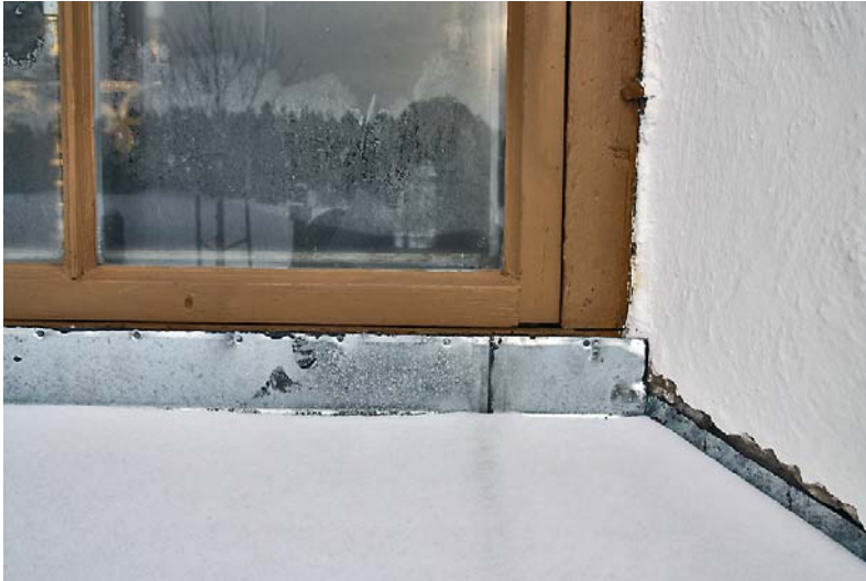
Detalj av fönsterbleck på sakristian efter restaurering.
