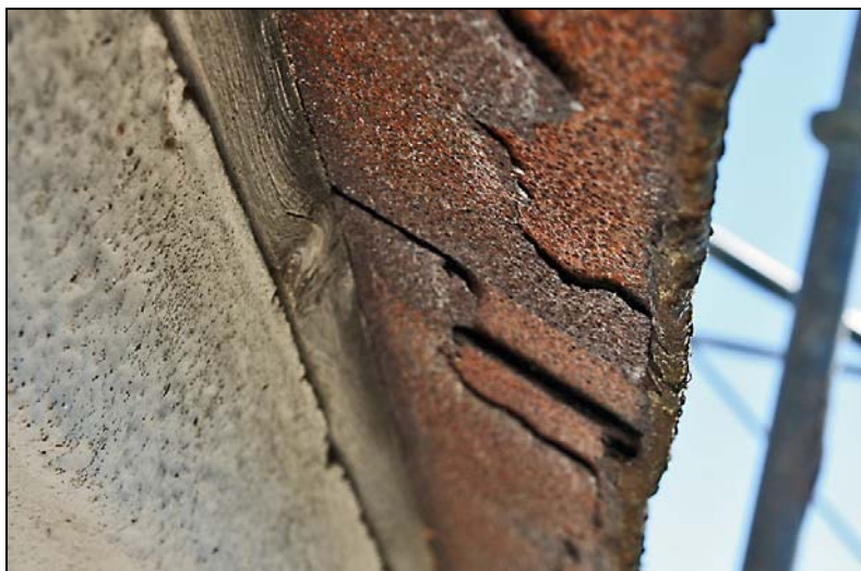
Genomrostat språngbleck på vapenhuset. Innan restaurering.
