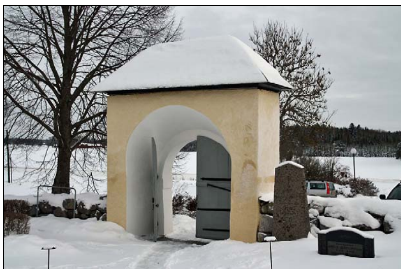
Östra stigporten efter restaurering.
