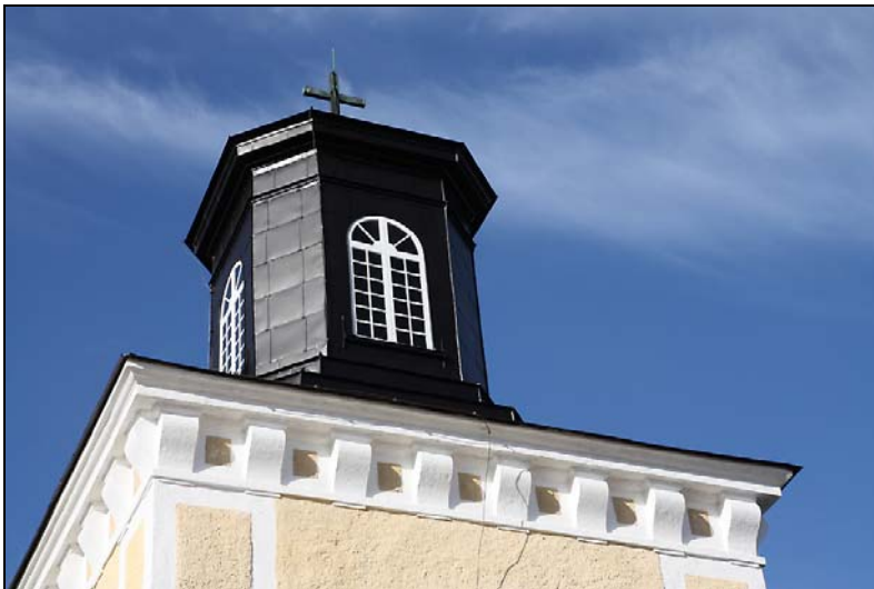
Torntaket efter slutförd restaurering. Hela lanterninen har fått ny plåt som målats svart.
