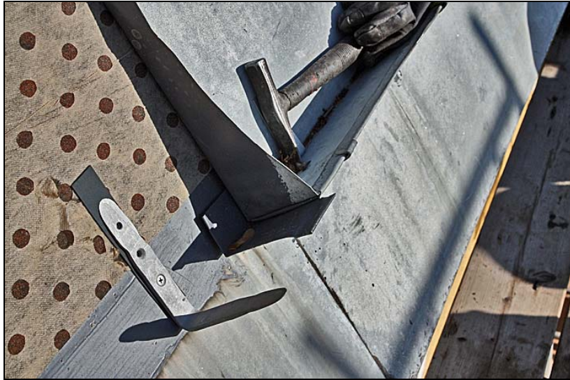
Läggning av södra långhustakets foträn- na.
