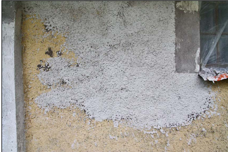
Putslagat fasadparti på tornets norra sida.
