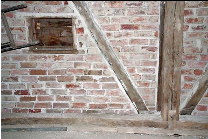
Interiör efter restaurering.
