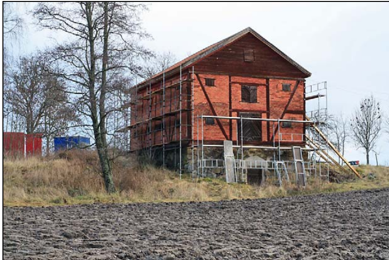
Magasinet under byggande av ställningar. På södra långsidan har kraftiga strävor sätts upp.
