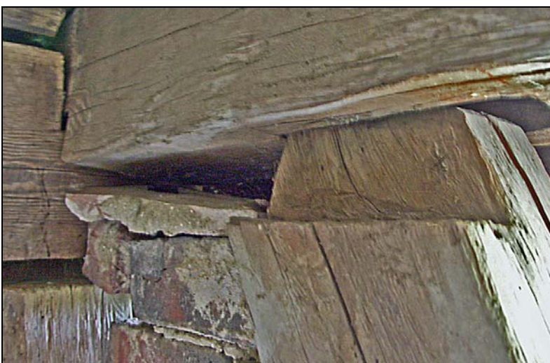
Sydöstra hörnet innan restaurering. Snedsträvans intappning i gavelns hammarband är på väg att glida ut i och med att strävan har sjunkit och böjts.
