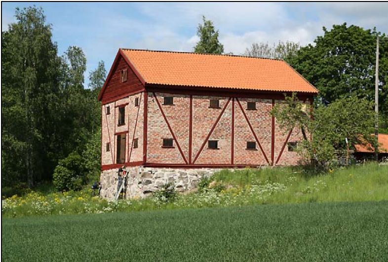
Magasinet från söder efter re- staurering.
