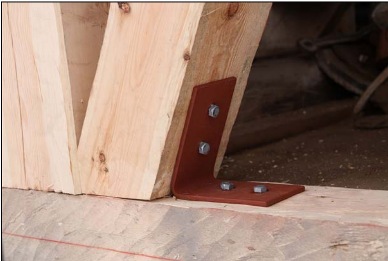
Strävornas tim- merförband för- stärktes med vinkel- järn fästa med franskskruv
