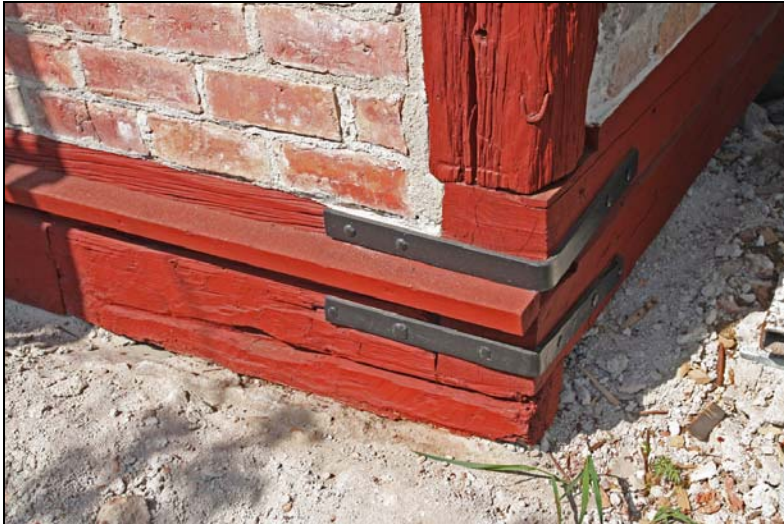
Sydvästra hörnet efter genomförd restaurering. Bandjärnen är rostskyddsmålade och slutstrykna med svart linoljefärg.
