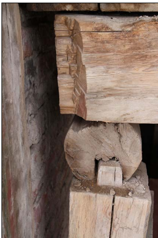
Detalj av den inre stommen. Den bärande vertikala stolpen har en tapp för fixering av bärlinan av rundtimmer. Ovanpå bärlinan ligger den kraftiga bjälken för mellanbjälklaget.
