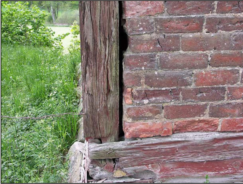
Sydvästra hörnet innan restaurering. Hörnstolpens intappning är på väg att ge med sig och stolpen har fått ett centimeterstort glapp mot väggfältet. Glappet innebär att väggfältet kan tippa ut.
