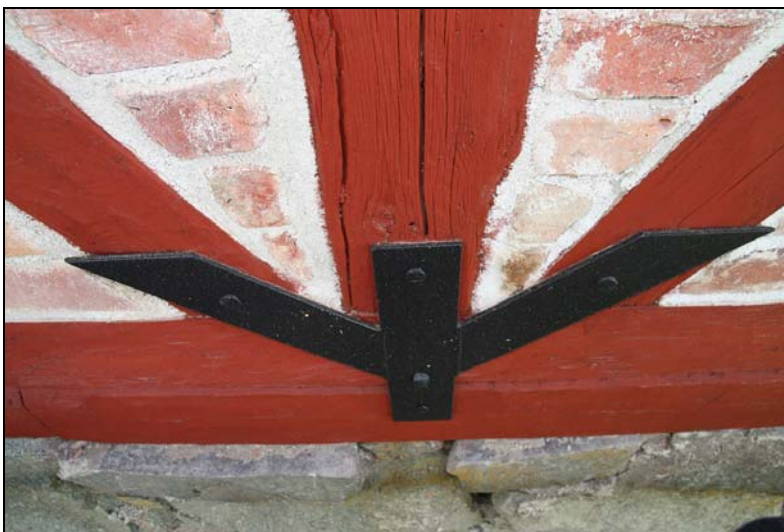
Förstärkning av knutpunkt med bandjärn.
