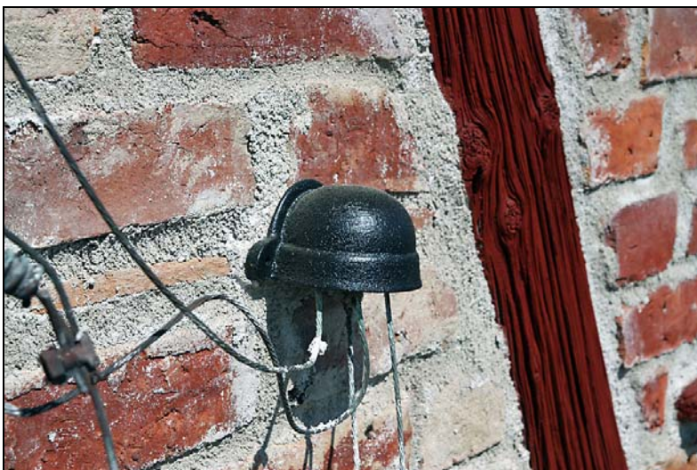
Äldre elutrustning återmonterades på fasaden efter avslutad restaurering.
