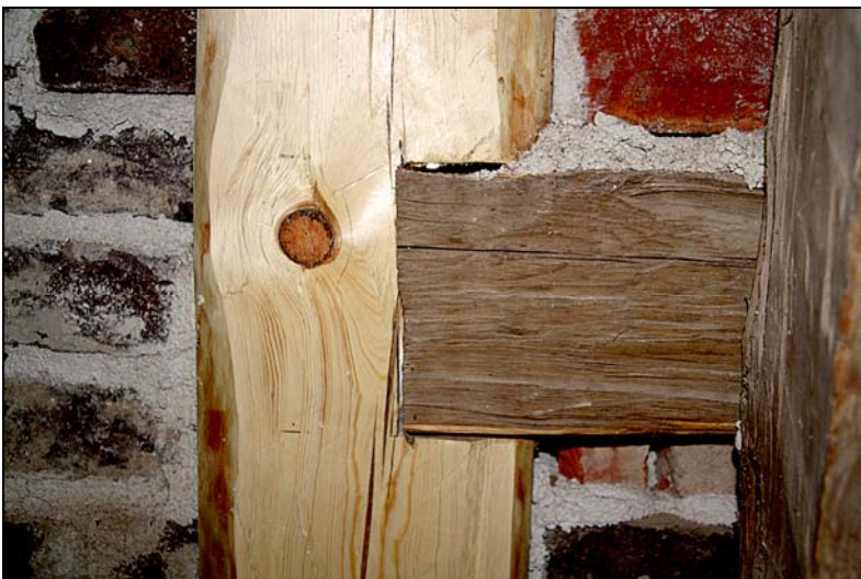
Nyttillverkad stolpe i förband med äldre horisontell bjälke.
