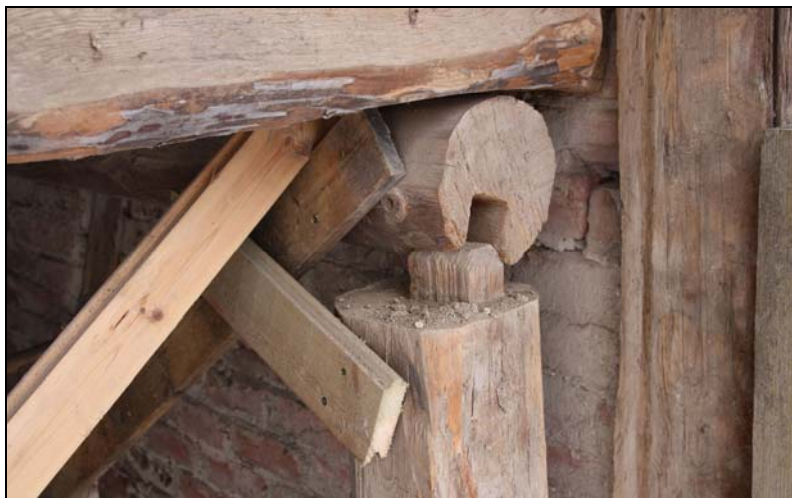
Säkring av inre stomme med provisoriska planksträvor. Bärlinan är på väg att kalva ut ur stolpens tapp.
