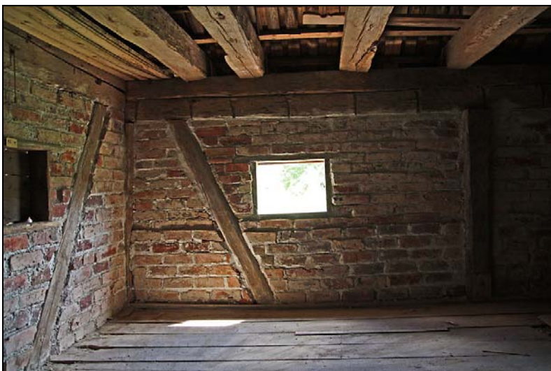
Interiör efter restaurering.
