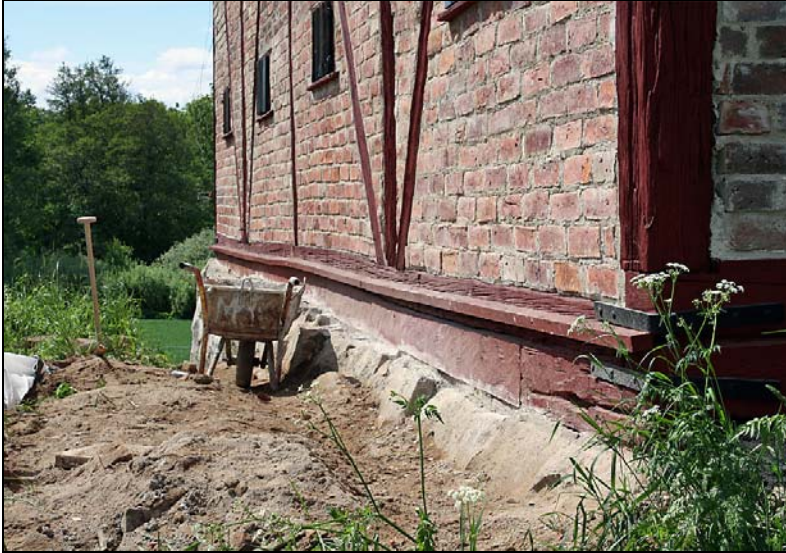
Södra långsidan med stenfot och syll efter restau- tering.
