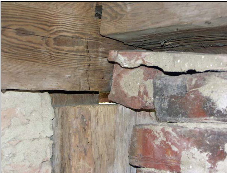
Sydöstra hörnet innan restaurering. Hörnstolpen har sjunkit ned tillsammans med syllen vilket medför att stolpen inte längre bär norra långsidena hammarband.
