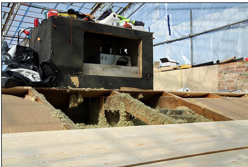
Takstolsfack med lösulls-isolering.
