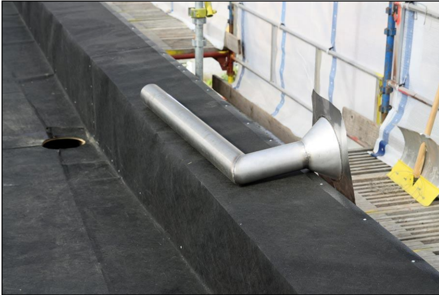
Rör med vattkupa som monteras i utloppshålen och leder vattnet genom muren och ut i utkastaren
