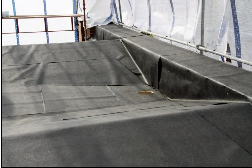
Håltagning för utloppet i fasaden
