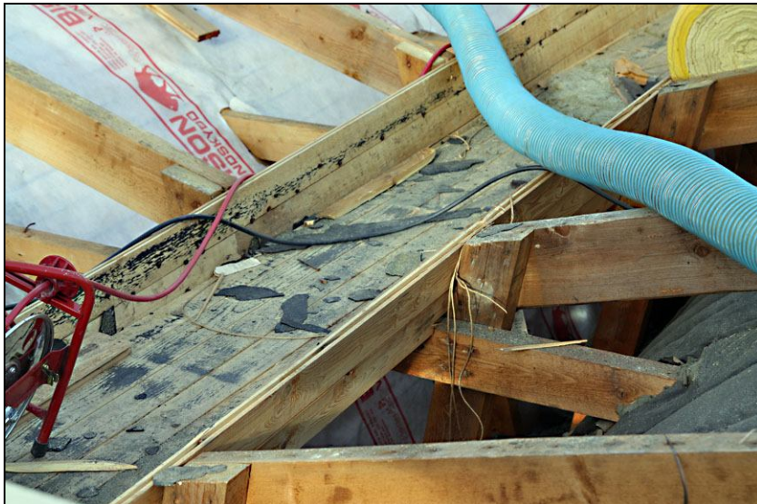
Gesimsrännans stomme. Stommen hade inga större skador och kunde återanvändas efter ny pappning och plåtbeklädnad. Den gamla, reparerade gesimsrännan används som extra säkerhet under det nya koppertaketets rännindalar
