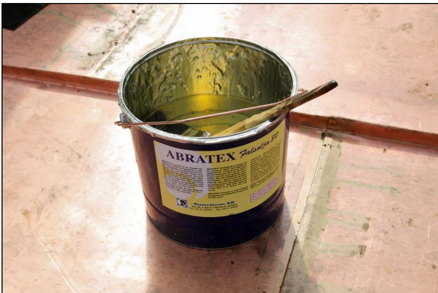
Abratex falsolja har använts vid lägg- ningen av kopparta- ket.
