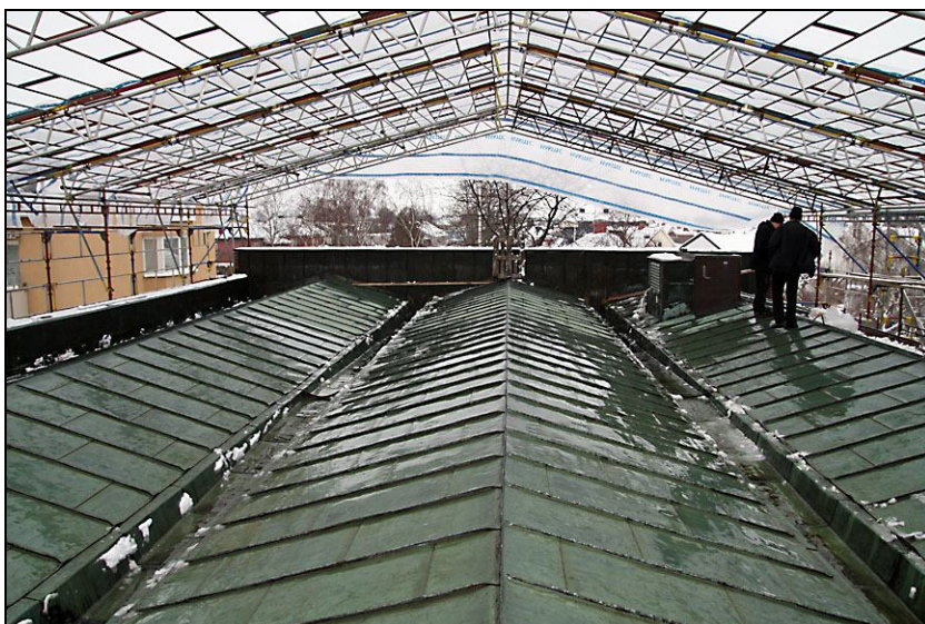
Det centrala sadeltaket med nockfals och halvplåts förskjuten kopparplåt.
