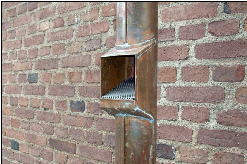
Rengaller för de nya stuprören
