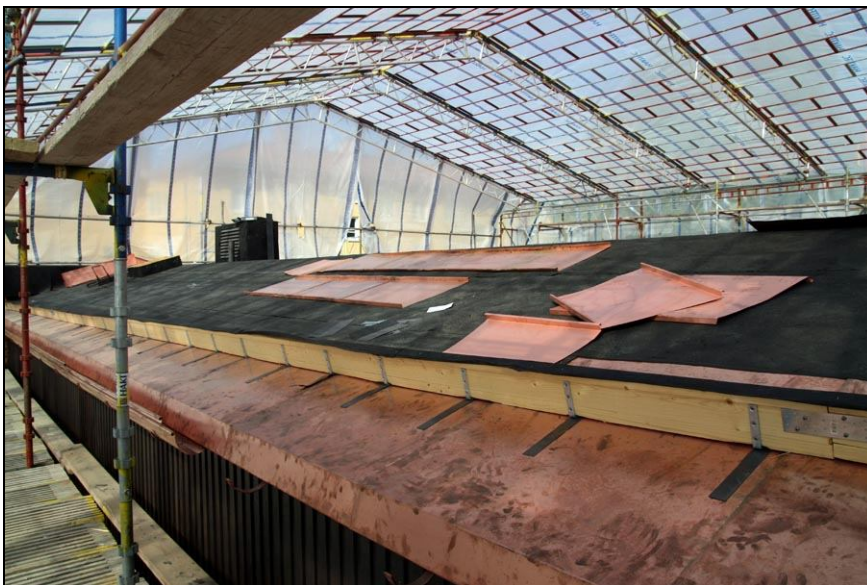
Läggning av kopparplåt kring den nya fotrännan.
