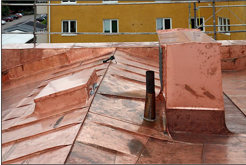
Ny taklucka i det södra hörnet.
