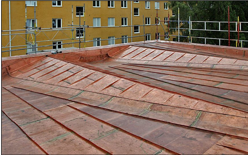
Färdiglagt tak mot sydväst.
