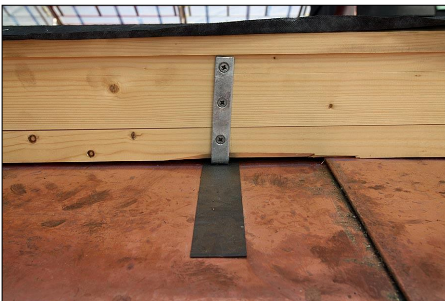
Detalj av fotrännan med vinkeljärn i stål och blyisolering mot kopparplåten.
