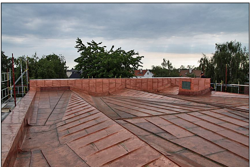
Färdiglagt tak mot nordost.
