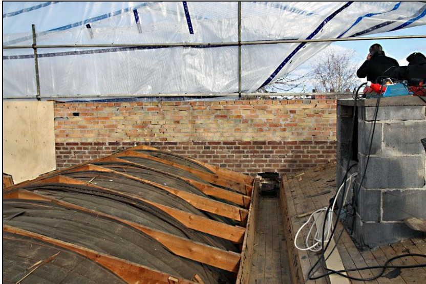
Till vänster i bild de gamla takstolarna efter rivning av plåt och råspont. Valven är isolerade och dess form kan tydligt urskiljas. Till höger i bild skorstenen av lättbetong.
