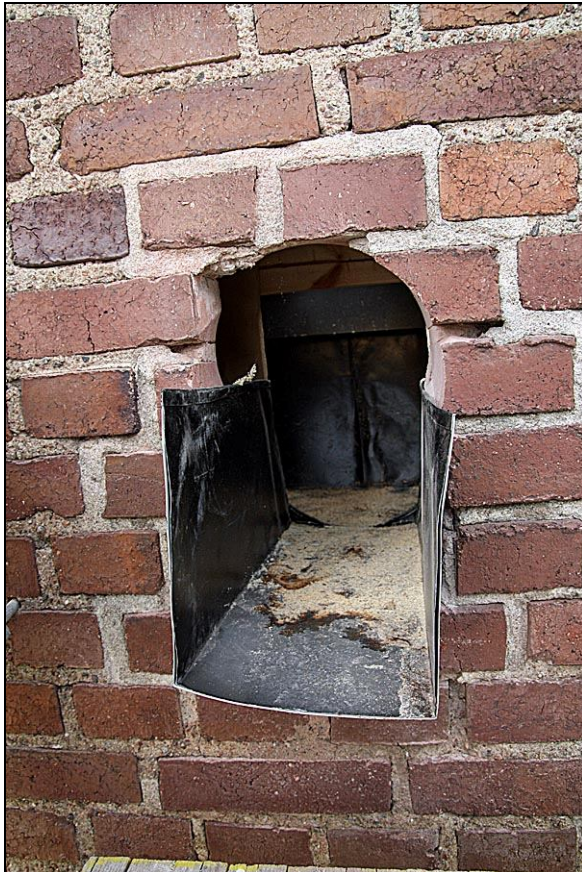
Håltagning för utloppet i fasaden
