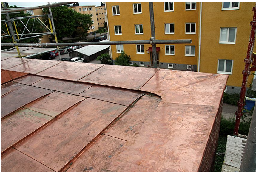
Murkrönets beslag har avrundats i det inre hörnet likt befintlig äldre kop- partäckning.
