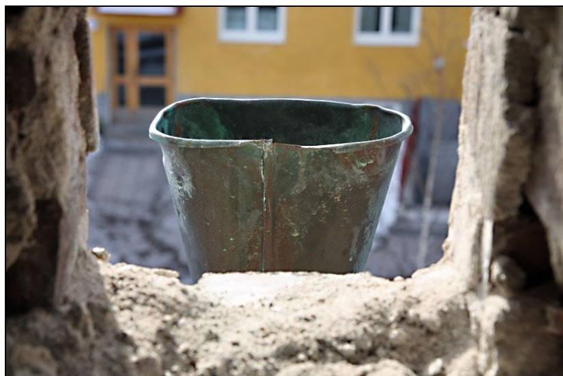
Den befintliga vattkupan med dess avrundat rektangulära sarg som övergår till stuprörets cirkulära.
