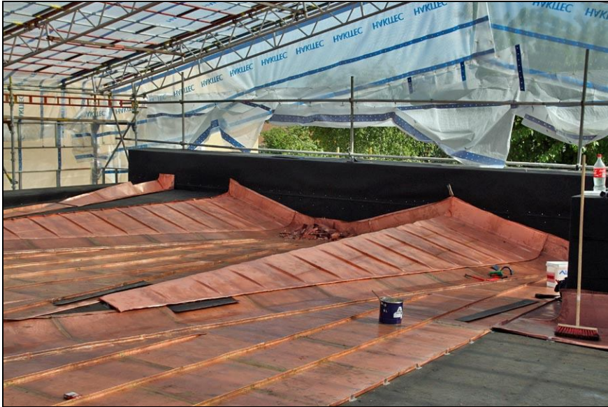
De nya takfallen under plåtläggning.
