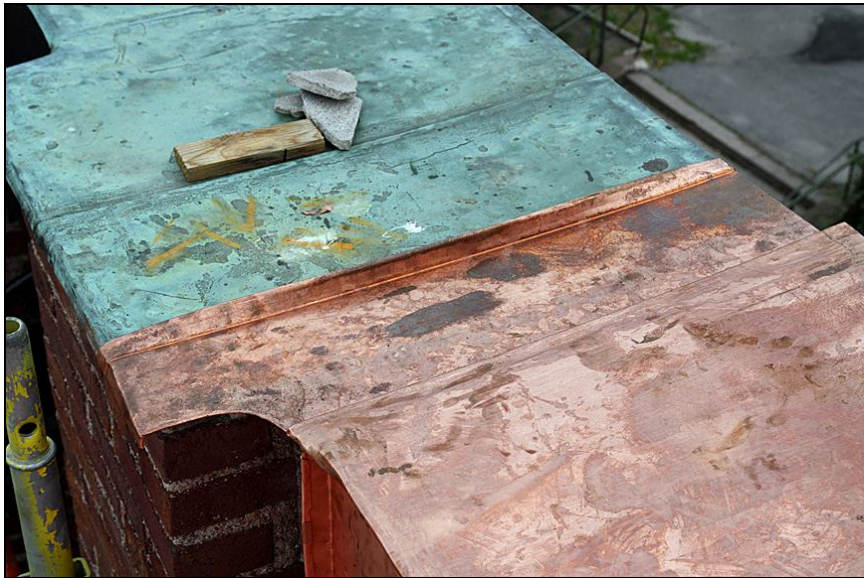
Övergång mellan nylagt och äldre murkrönsbeslag i kyrkans södra hörn.
