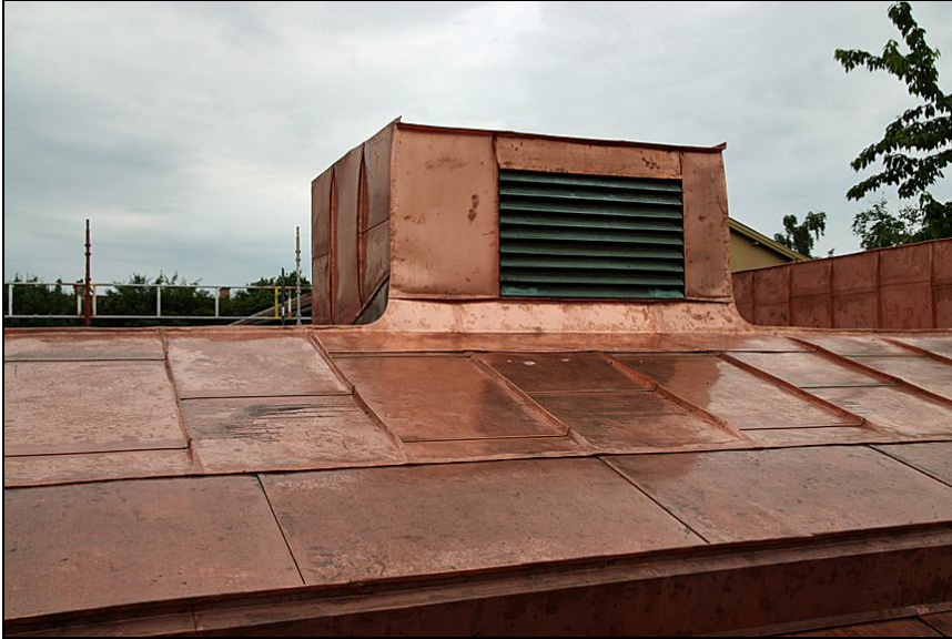
Delvis ombyggd ventilationshuv med bevarat jalusigaller i tjock kopparpålåt.
