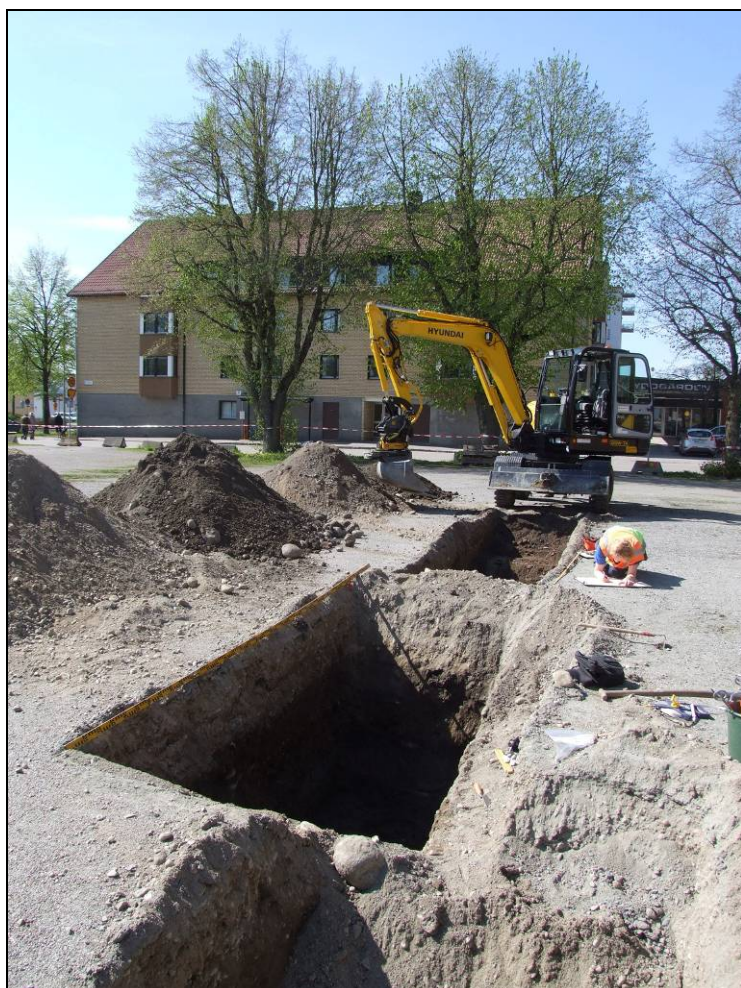
Figur 9. Schakt 1, 2 och 3 i kv. Hökarens västra del. Foto mot sydväst av Linda Qviström, Upplandsmuseet.
