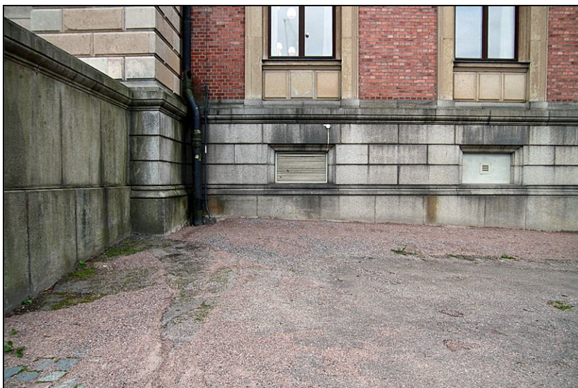
Huvudfasadens norra del efter åtgärd.
