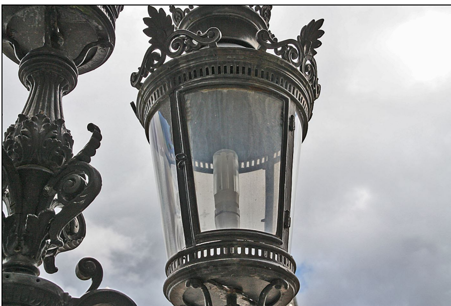
Ny ljuskälla i plastcylinder i befintlig kandelaberarmatur.
