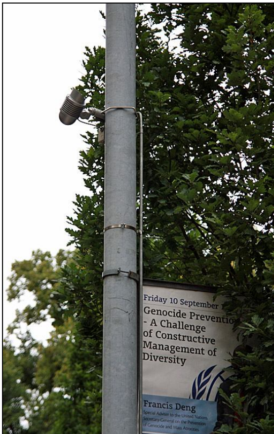
Strålkastare monterade på befintliga stolpar (So5)
