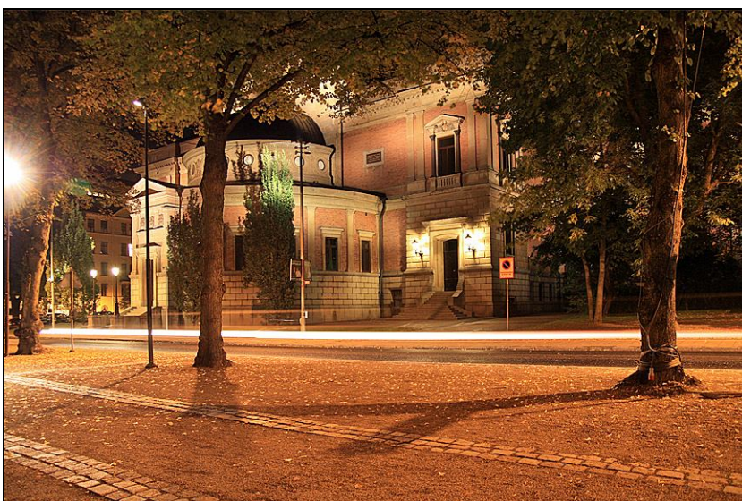
Universitetshusets fasad mot Övre Slottsgatan.
