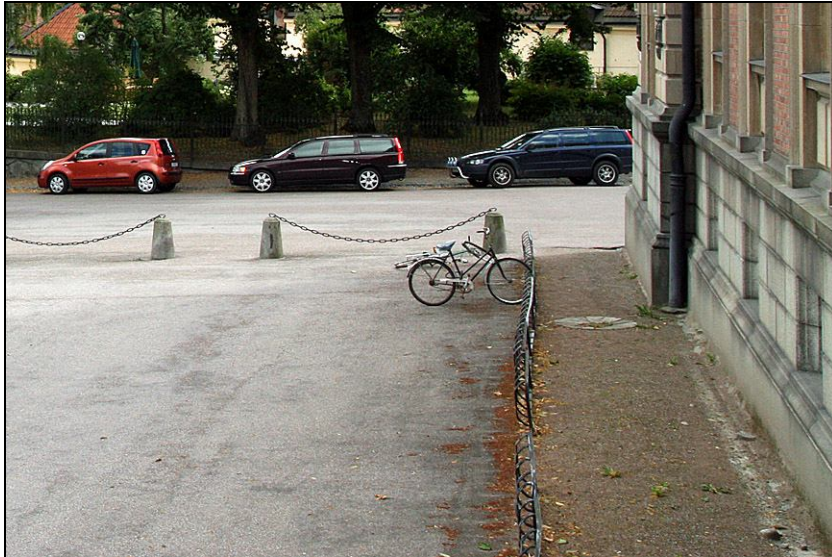
Huvudfasadens södra del innan åtgärd.
