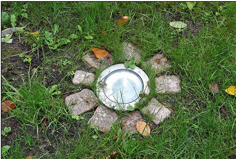
Nedsänkt markstrålkastare med stenskoning.
