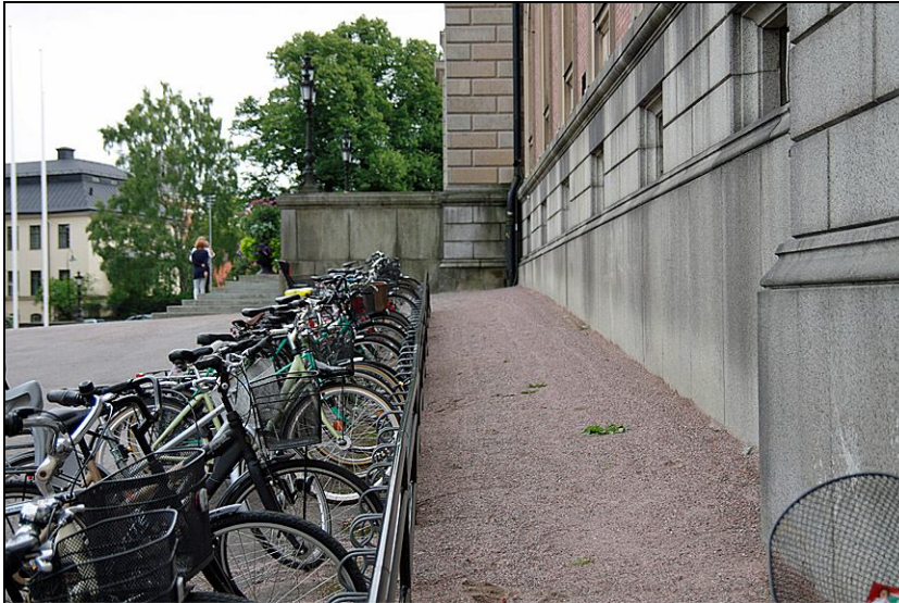
Huvudfasadens norra del efter åtgärd.
