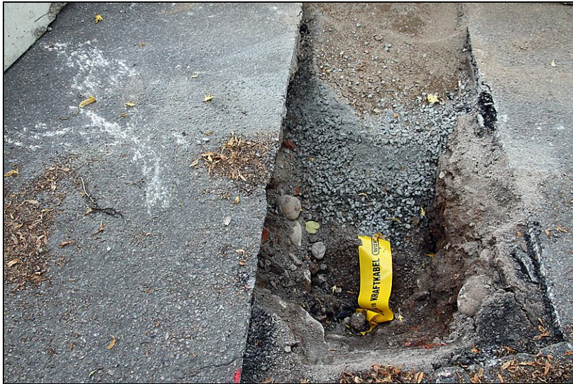
Håltagning för stolpfun- dament.
