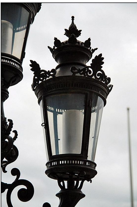
Ny ljuskälla i plastcylinder i befintlig kandelaberarmatur.
