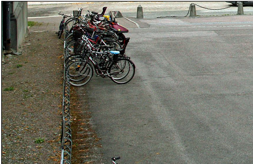
Huvudfasadens norra del innan åtgärd.
