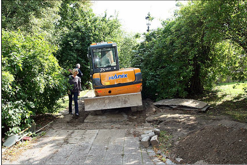
Schaktningsarbeten i Universitetsparken i samband med kabel- dragning.
