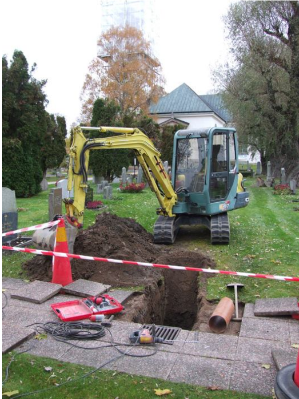
Figur 6. Sträcka 1 grävdes från dagvattenbrunnen i kyrkogårdens södra del och fram till kyrkans södra korsarm.
