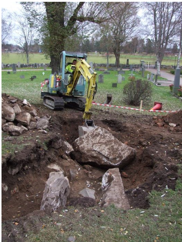
Figur 11. Hörnstenen flyttades åt sidan för att dagvattenledningarna skulle kunna dras fram. Foto från väster.
