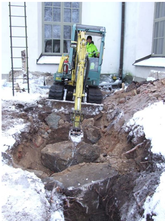
Figur 29. Stenarna i det norra vapenhuset flyttas undan för att ledningarna ska kunna läggas ner. Foto från väster.
