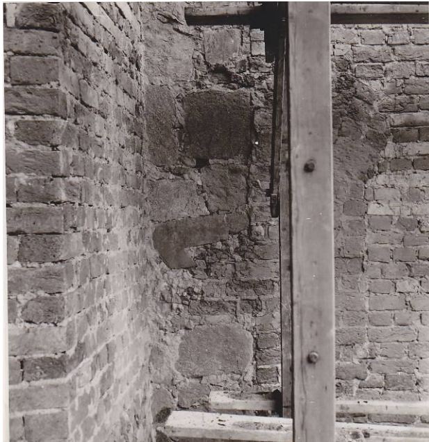
Figur 45 (tv). Vid putsnedknackningen 1962 syntes en tydlig skarv som visar var öppningen in till den medeltida korsarmen börjat. I muren syns också rester av ett valvanfang murat i tegel. Foto Ola Ehn, Upplandsmuseet.
