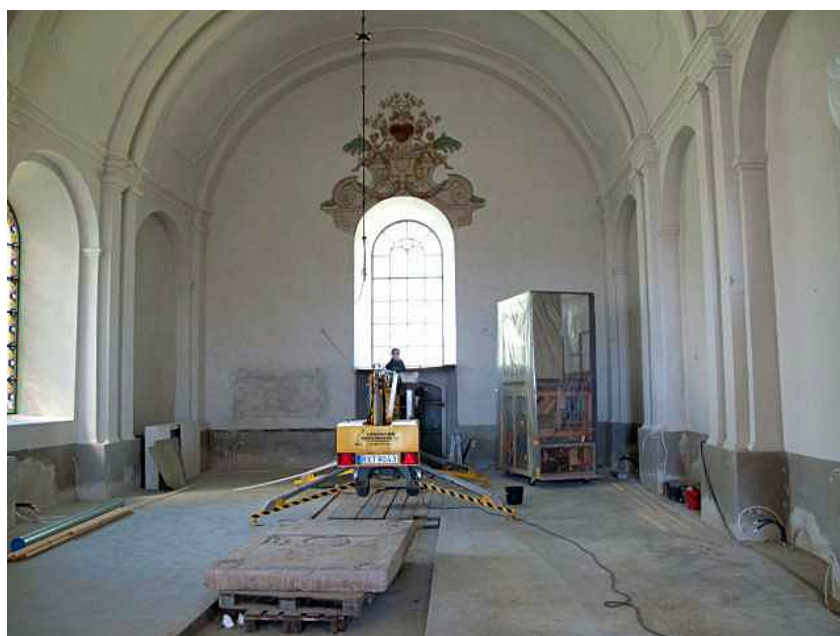
Norra korsarmen under återläggning av mittgången. Foto Upplandsmuseet/Johan Dellbeck
