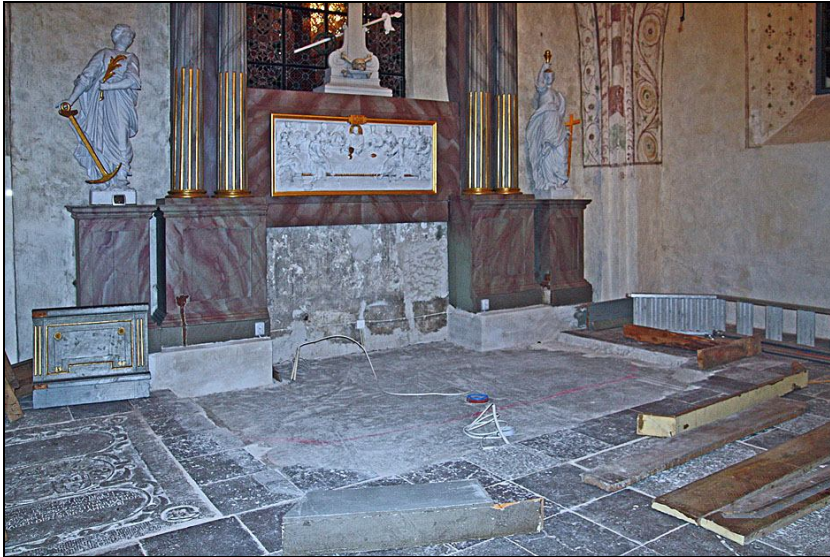
Altarrundelns anslutning till östväggens altaruppsats. Korgolvet har höjts, vilket medför att altarrundelns anslutning till väggen måste justeras. Den gamla anslutning framträder som träfärgade partier på väggen.
