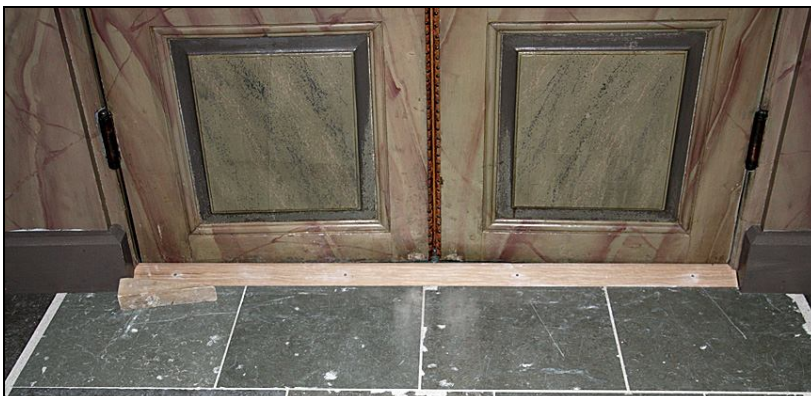
Inre vindfångs- dörrar med ny tröskellist.
