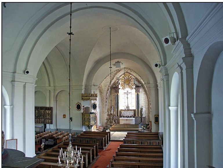
Innan restaurering. Kyrkorummet från läktaren. Foto Upp- landsmuseet/Johan Dellbeck 2007
