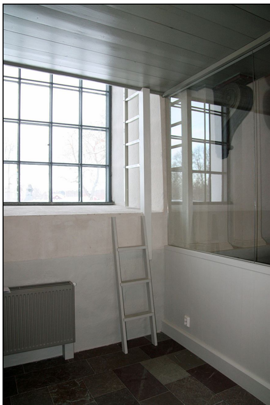
Utrymningsstege från läktaren till förberedelserum- met.
