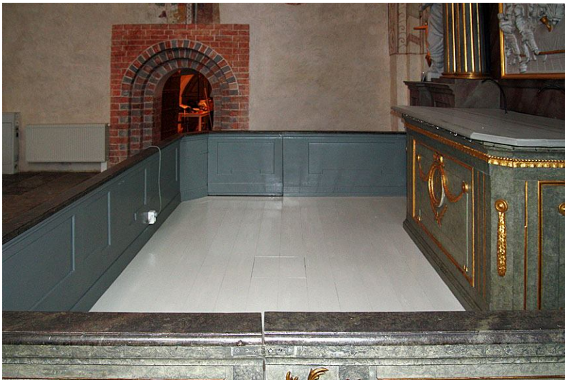
Efter restaurering. Skrankets insida har målats om i sin helhet i samma färg som tidigare. I mitten av golvet finns en inspektionslucka för underliggande installationer.
