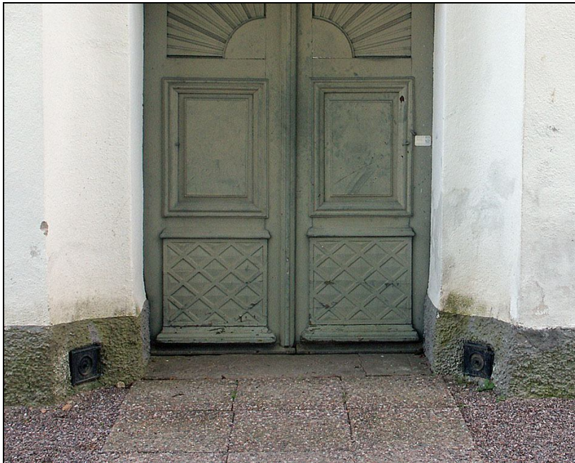
Gjutjärnsventiler som sattes upp vid restaureringen 1938. Foto Upplandsmuseet/Johan Dellbeck 2007
