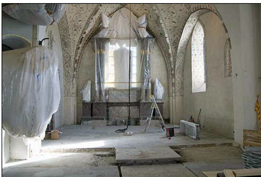
Koret under återläggning av kalkstensplattor. Foto Upplandsmuseet/Johan Dellbeck.
