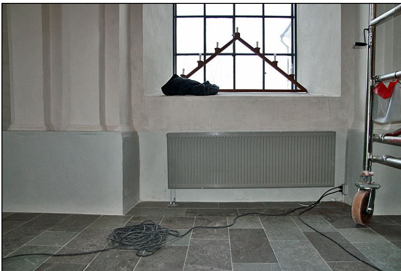
Panelradiator under fönster som kompletterar golvvärmen.
