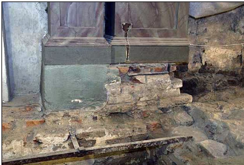
Altaruppsatsens fundament med golvet och altarrundeln avlägsnad. Rundelns anslutning till altaruppsatsens podium framträder som ett mörkare, träfärgat parti. Knäfallets kontur framträder som gränsen mellan den putsade och oputsade delen av sockeln. Foto Upplandsmuseet/Bengt Backlund.
