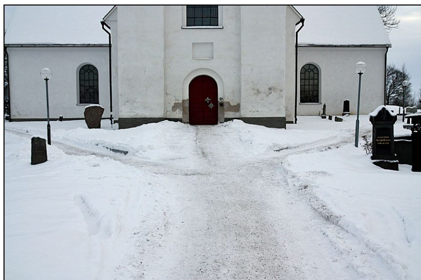
Entrén i väster efter ombyggnad.
