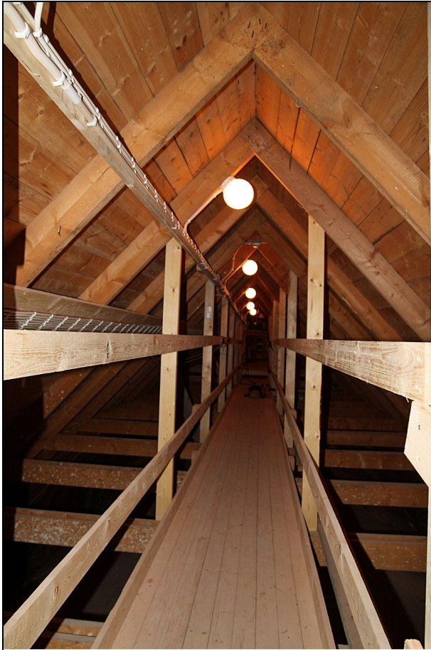
Nybyggd landgång på vinden med kabeldragning på en regel som fästs vid undersidan av sparrarna.
