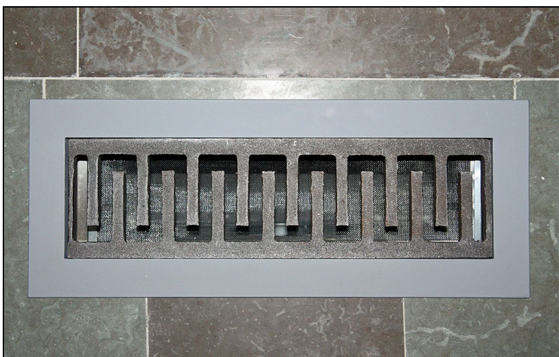
Tilluftsdon i kalkstengolvet.
