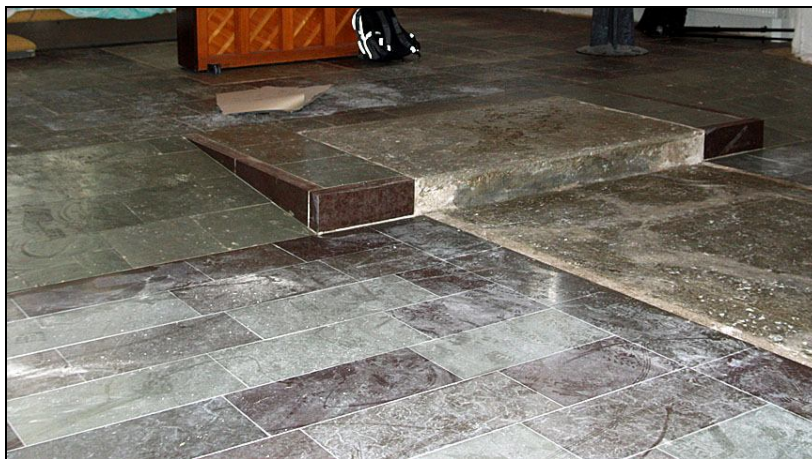
Övergång mellan korsmitt och kor med ramper och avsats i kalksten.
