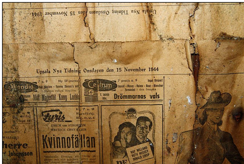
2010-08-10. Väggar-na i drängkammaren har klätts med tidningspapper.
