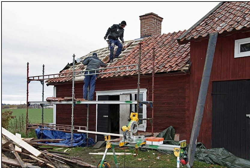
2010-10-26. De rengjorda tegelpannorna återmonteras på det sydvästra takfallet.
