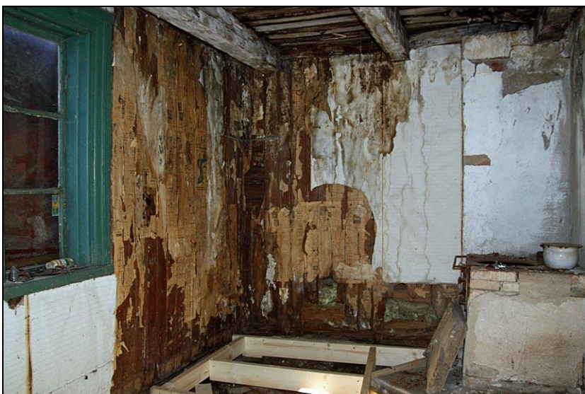
2010-10-22. Drängkammarens nordöstra hörn under pågående golvarbeten.
