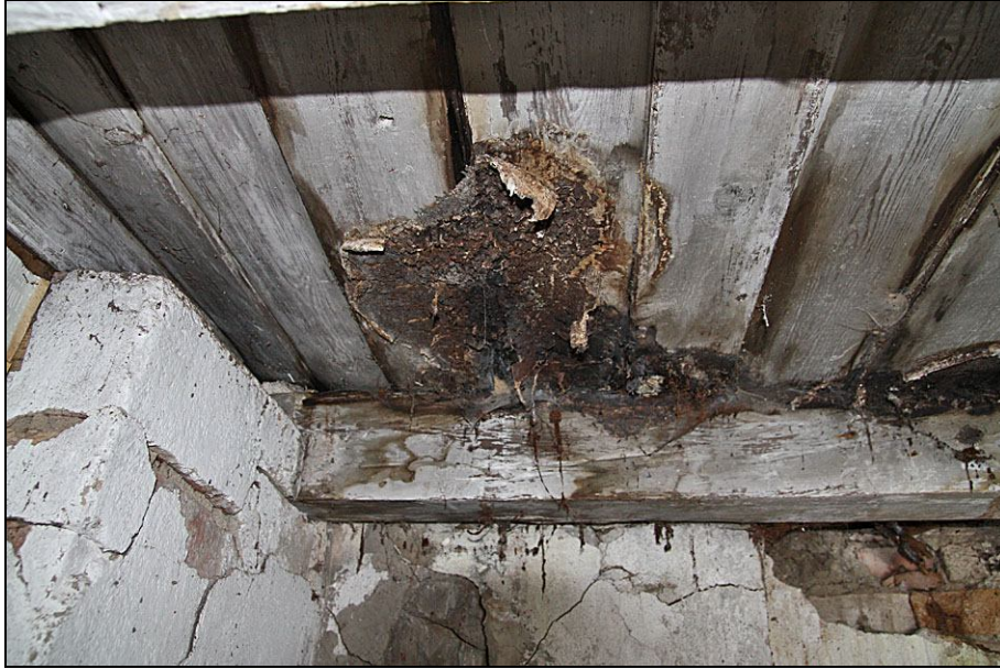
2009-10-22. Uttorkad fruktkropp ovanför drängkammarens vedspis. Innan restaurering.
