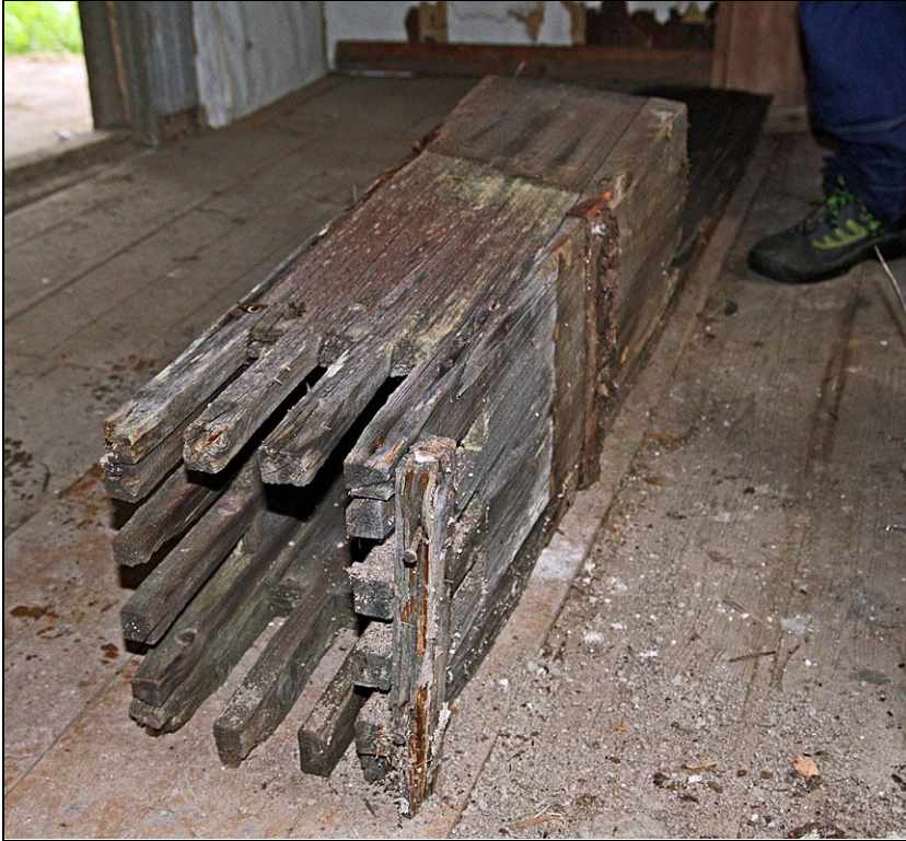
2010-10-22. Demon- terad ventilations- trumma för brygghu- set.
