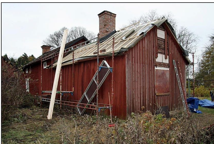
2010-10-26. Det nordöstra takfallet under pågående läkning.
