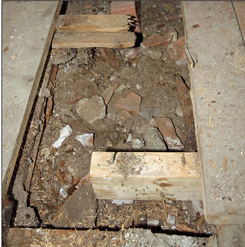
2010-08-10. Drängkammarens brädgolv med två borttagna bräder. Sentida bär-linor av byggreglar visar att golvet har reparerats i sen tid, men det finns också äldre lagningar. Delvis tycks dagens brädgolv ha lagts ovanpå ett äldre, underliggande brädgolv.
