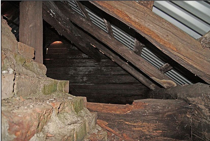
2010-08-10. Murstock och taklag på det nordöstra takfallet innan restaurering.
