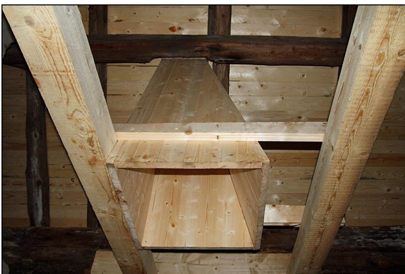
2010-11-01. Den nya ventilationstrumman monterad på de gamla platsen. Urtag i mitt-åsen visar trummans rätta position. Bjälkarna är nya.
