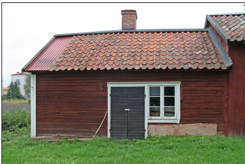
2010-08-10. Sydvästra fasaden innan restaurering.
