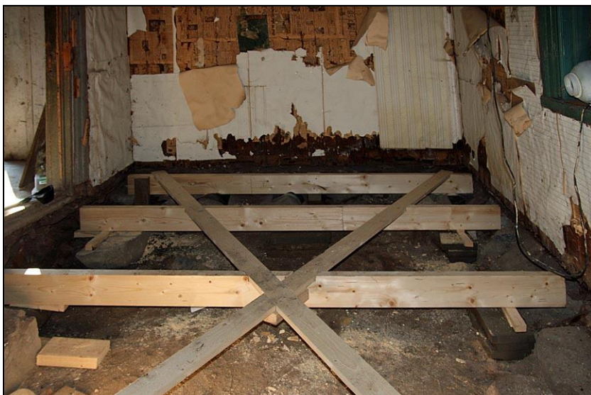
2010-10-22. Drängkammarens brädgolv har rivits ut och grunden har rensats från skräp och organiskt material. Nya bärlinor har satts upp.
