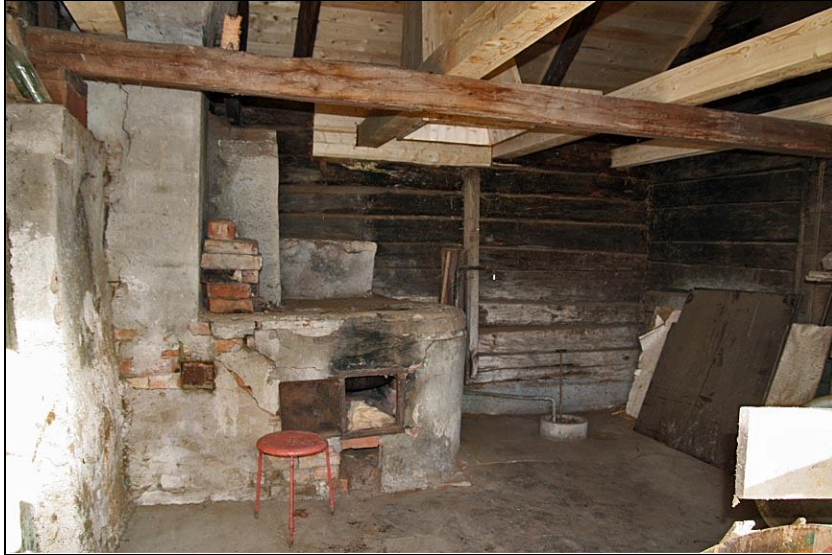
2010-11-01. Bryggerummet med demonterat innertak, nya takbjälkar och ny ventilationstrumma.
