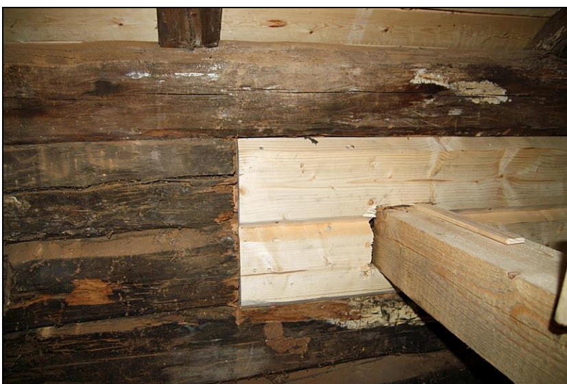
2010-11-01. Halvsulningar vid en av takbjälkarnas upplag i nordöstra långväggen.
