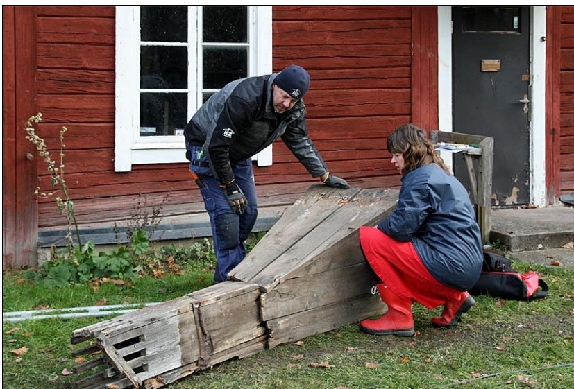
2010-10-26. Den gamla ventilationsstrumman inspekteras inför uppsättningen av den nya.
