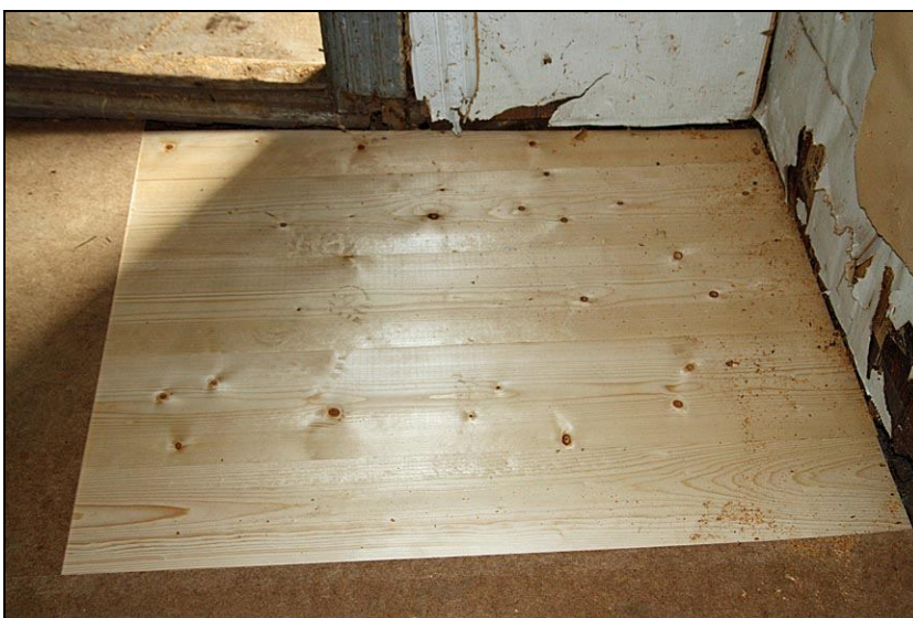
2010-11-01. Det nya plankgolvet av 45 x 220 mm plank lagt på bärlinorna.
