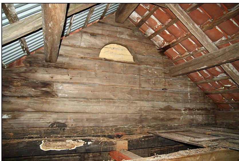
2010-08-10. Taklag och yttertak innan restaurering. På sydvästra takfallet ligger enkupigt tegel på öppen läkt. På nordöstra takfallet sitter ett tillfälligt skyddstak av trapets-korrugerad plåt. Lunettfönstret på det södra gavelröstet är igensatt med bräder.
