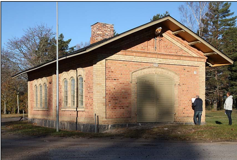
2010-10-25. Smedjan från väster efter färdigställda arbeten.
