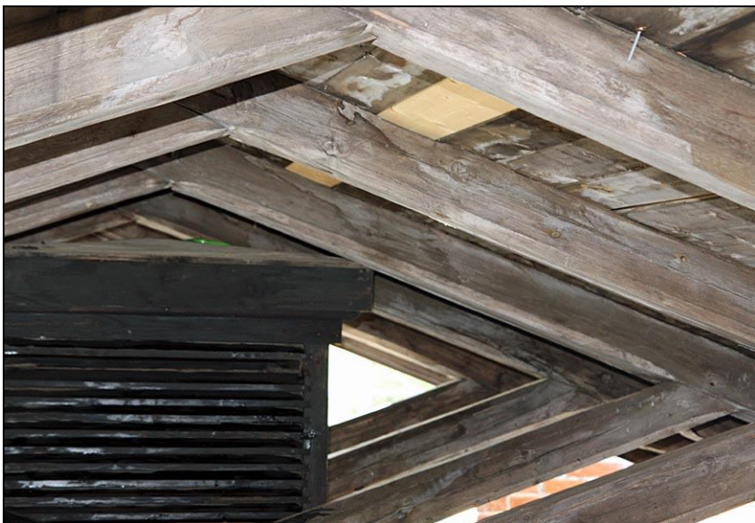
2010-09-20. Skärmtaket reparerades med enstaka nya bräder.
