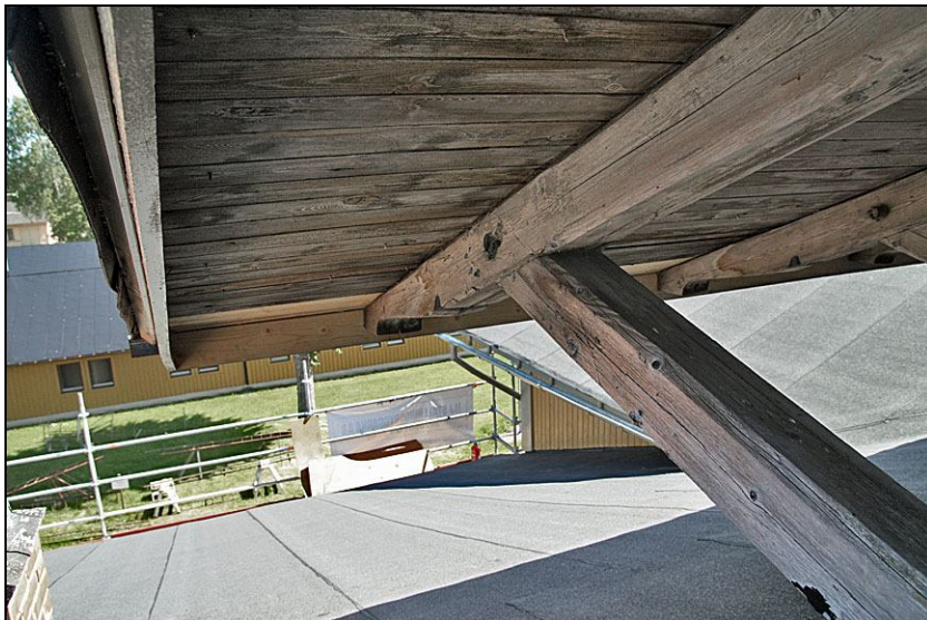
2010-06-22. Ventilationshuvarnas skärmtak hade bristfällig papp-täckning i takfoten och mindre partier av underbrädningen fick bytas ut.
