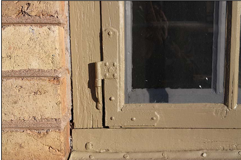
2010-10-25. Smedjan efter färdigställda arbeten.
