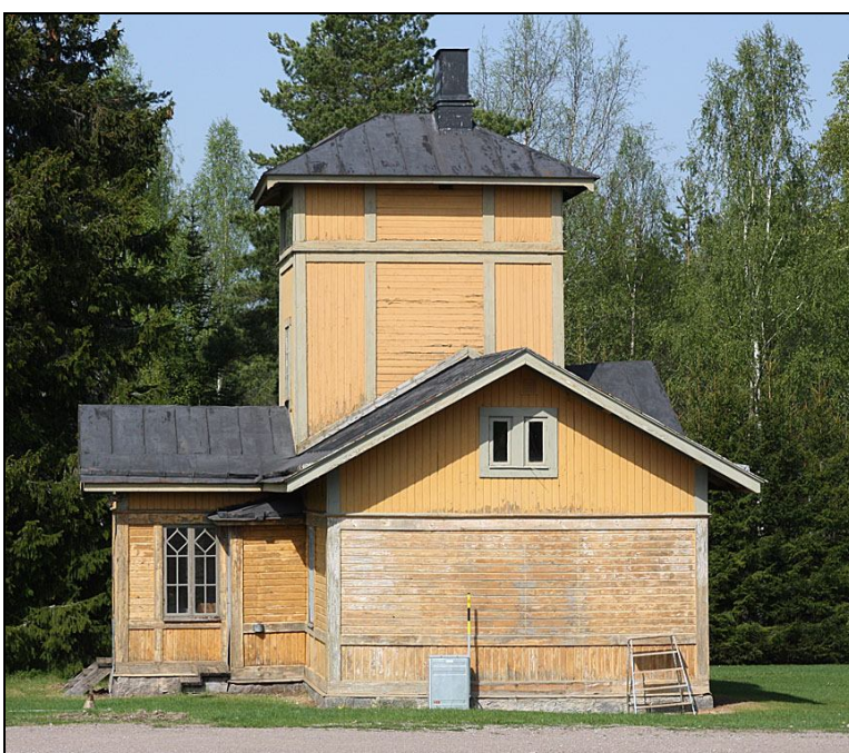
2010-05-20. Badhuset från öster efter skrapning av nedre delen av fasaderna. Den östra gaveln frilades från en senare tillbyggnad vid en restaurering 1996 och målades då med linoljefärg i dagens färgsättning.
