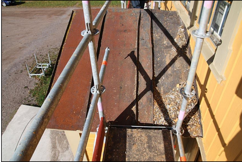
2010-09-20. Det plåtklädda skärmtaket över entrén. Plåten rengjordes och målades sedan.
