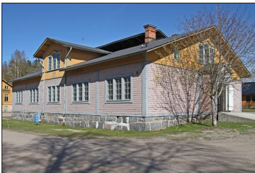
2010-05-07. Norra stambaracken från sydväst. Innan restaurering.
