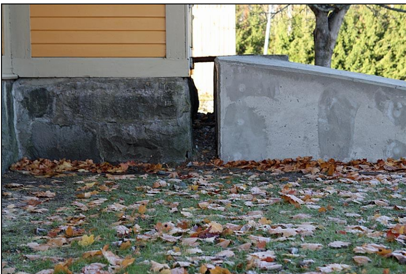
2010-10-25. Efter restaurering. Detalj av nygjuten körbro.
