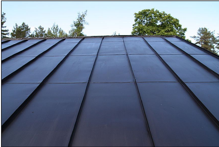
2010-06-22. Smedjan efter restaurering. Det nya plåttaket lades i samma mönster som det gamla, med hakfalsar på linje och falsat plåtformat 52 x 113 cm (60 x 120 cm plåt). Taket målades med svart linoljefärg.
