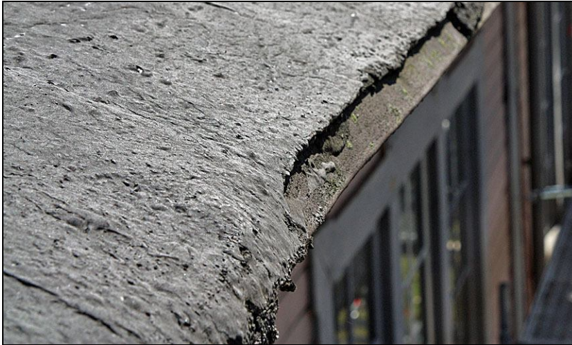
2010-05-07. Det gamla papptakets utförande i takfoten. Sprängblecket är nedknäckt och pappen har böjts ned mot plåten. Blecket var i god kondition och behövde inte bytas ut. Istället skrapades det och målades
