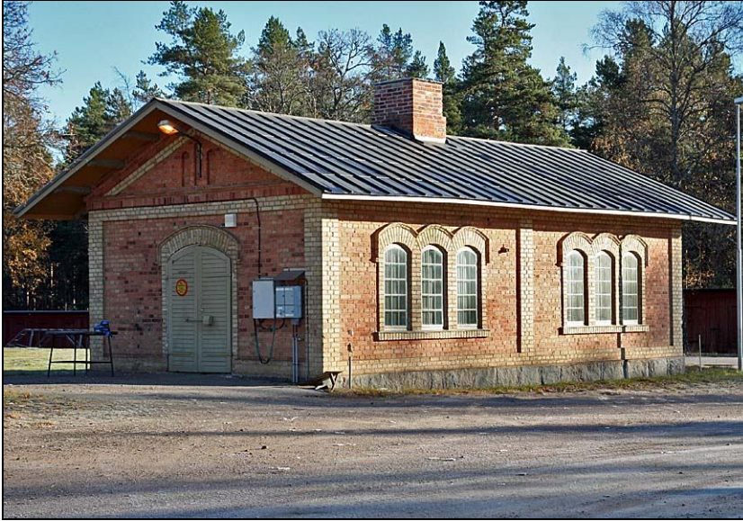
2010-10-25. Smedjan från öster efter färdig- ställda arbeten.
