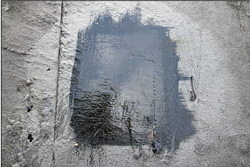
2010-08-25. Provstrykning på nedre delen av norra takfallet med Isotrol på rengjord yta samt Hagmanittäckt yta.
