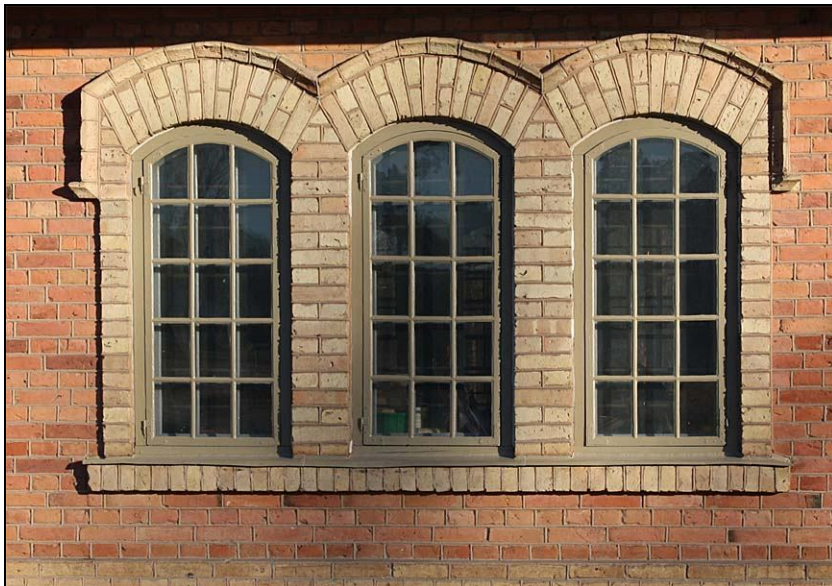
2010-10-25. Smedjan efter färdigställda arbeten. Fogen mellan karm och mur har kom- pletterats med kalkbruk.
