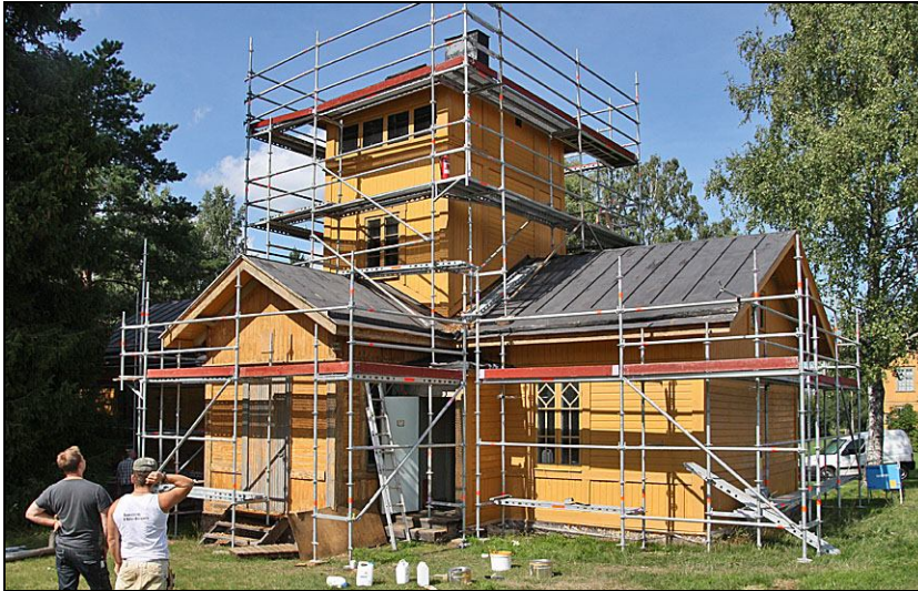
2010-08-11. Badhuset från sydost efter grundstrykning.
