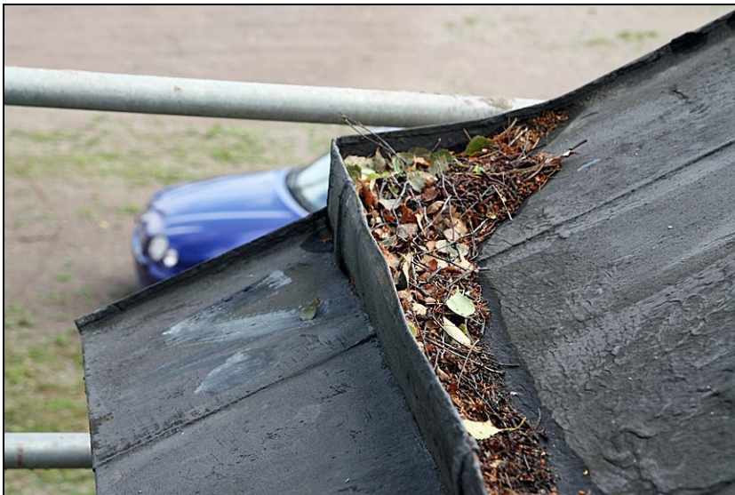
2010-08-25. Fotränna vid norra takfallets östra hörn innan restaurering.
