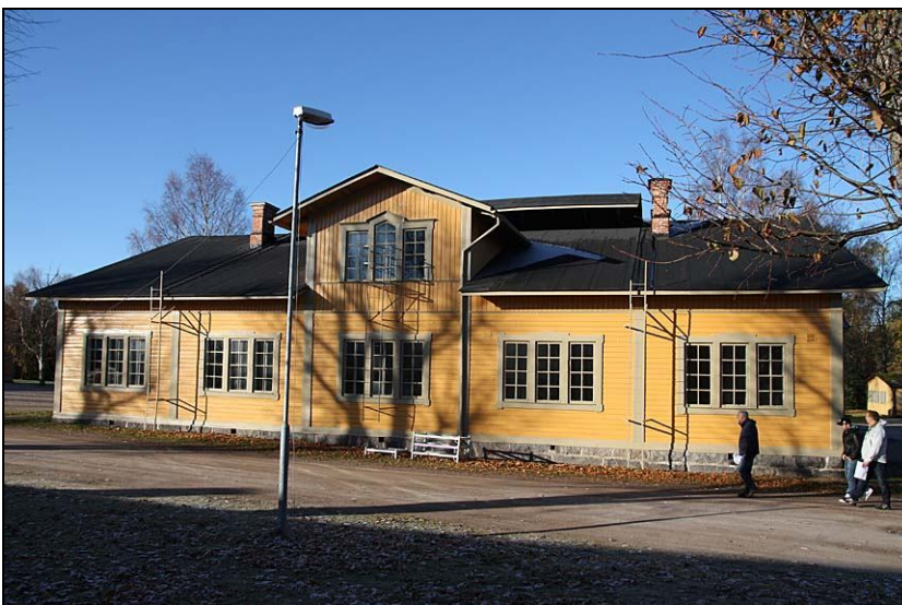
2010-10-25. Fasad mot öster. Efter restaurering.
