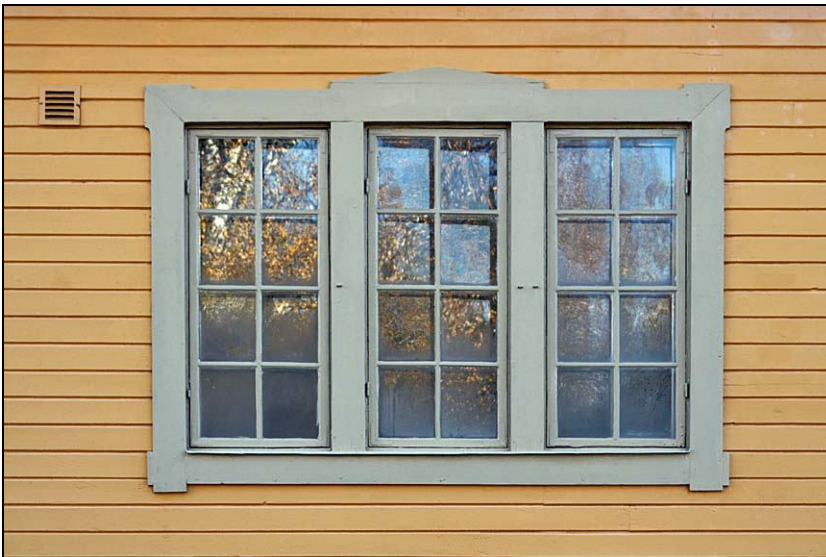
2010-10-25. Renoverat fönsterparti på västra fasaden. Efter restaurering.
