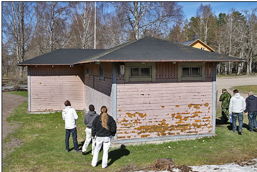
2010-05-07. Brandboden från söder. Innan restaurering.
