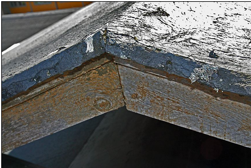
2010-05-07. Skärmtaket för ventilationshuvarna innan omläggning. Pappen var nedvikt och spikad mot en träläkt.
