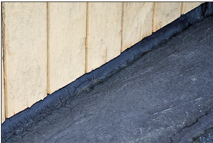
2010-05-07. Detalj av huvudtakfallets anslutning till takkupans vägg. Innan omläggning.
