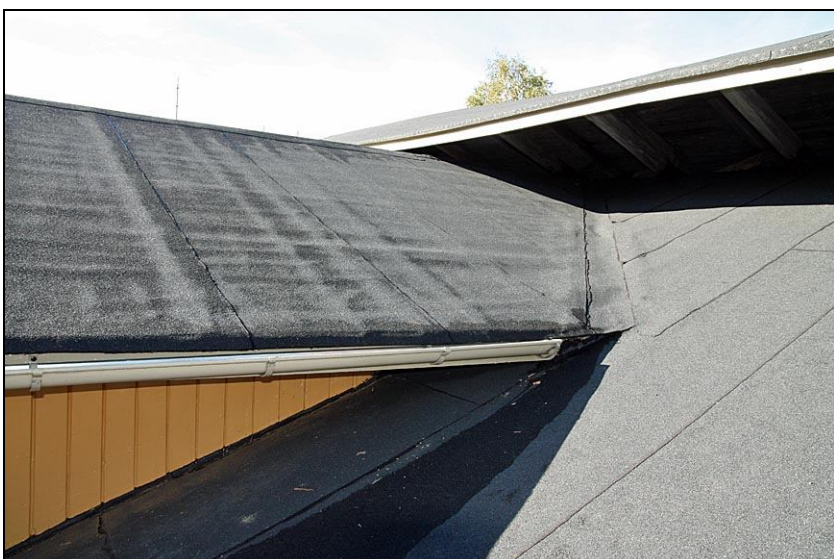
2010-09-20. Huvudtakfallet och takkupans takfall efter omläggning.
