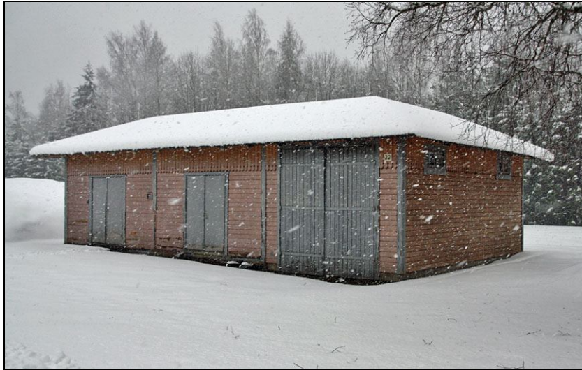
2010-04-22. Brandboden från nordost. Innan restaurering.
