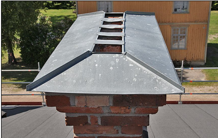
2010-06-22. En av skorstenarnas överbeslag var sönderrostat och ett nytt beslag tillverkades med det gamla som förebild.
