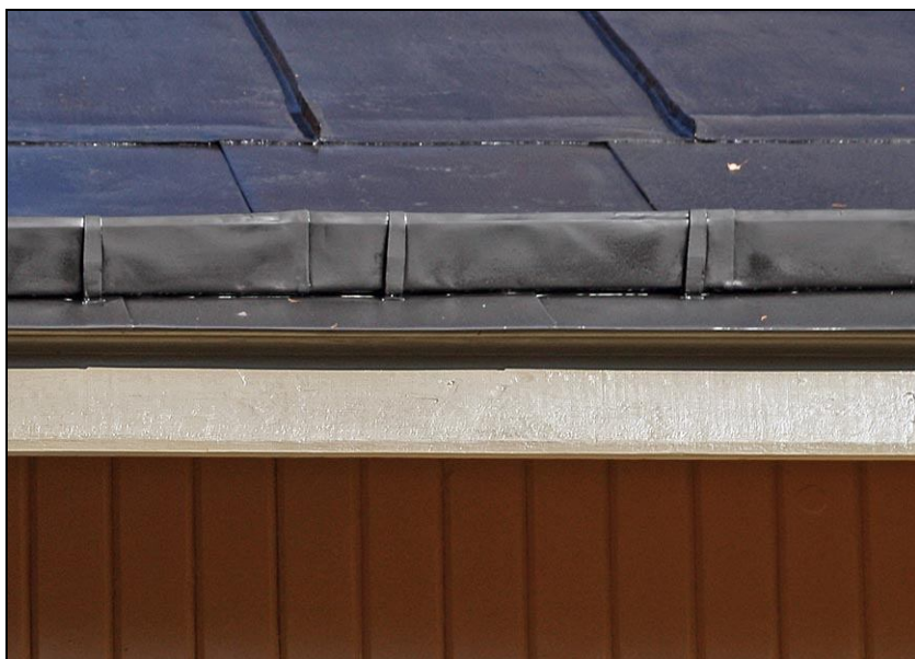
2010-10-25. Ny fotränna och fotplåtar. Efter restaurering.
