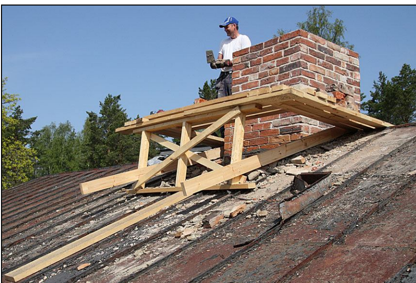
2010-05-20. Skorstenen under restaurering. De övre skiften har murats om.
