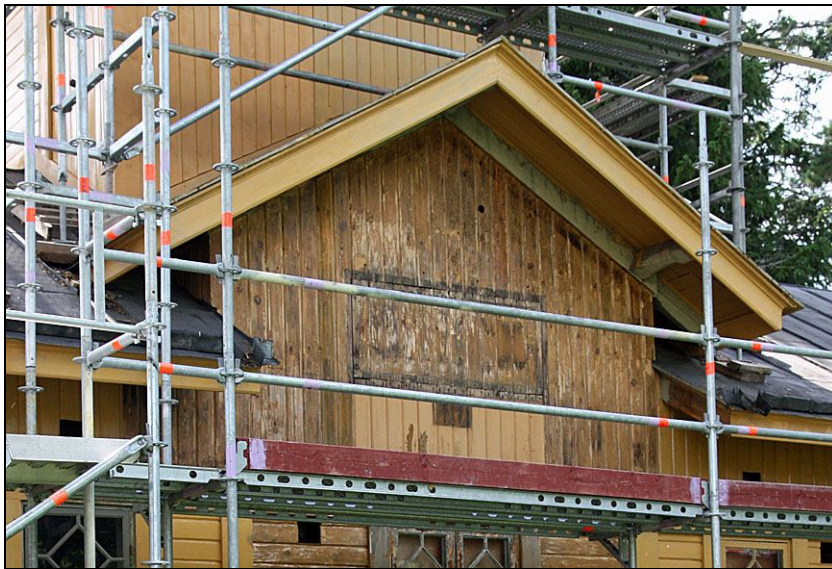
2010-08-11. Badhuset under restaurering. Väggfältet mitt i bild inramades tidigare av en slät trälist och innanför ramen satt en årtalsskylt av masonit. Väggfältet har inskarvad panel som tycks täcka en äldre öppning.
