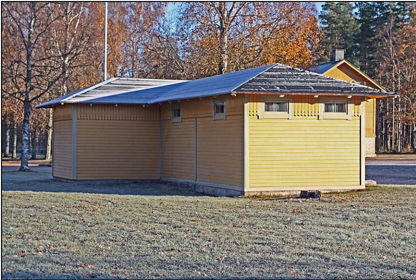
2010-10-25. Brandboden från söder. Efter restaurering.
