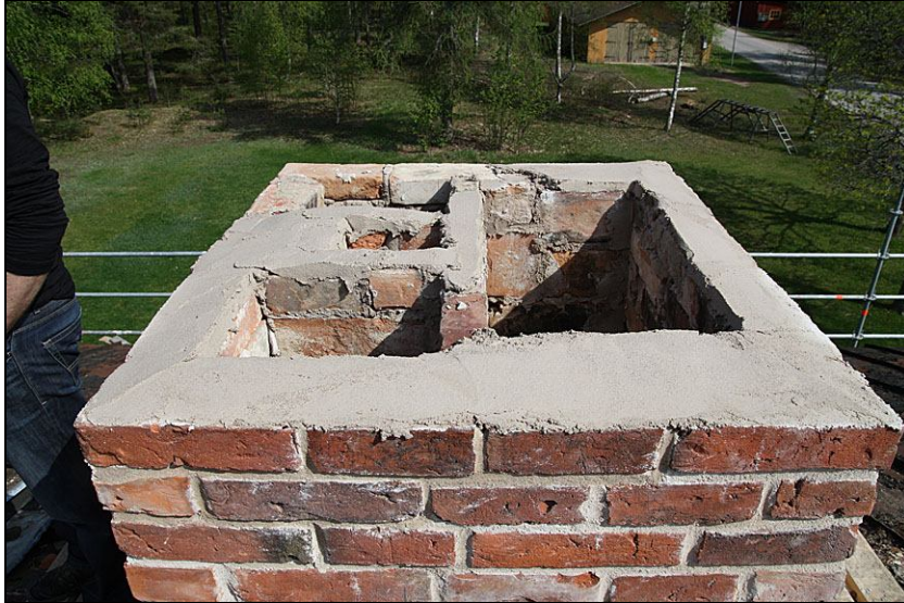
2010-05-20. Den restaurerade skorstenen. Överbeslaget demonterades vid ommurningen och återmonterades sedan.
