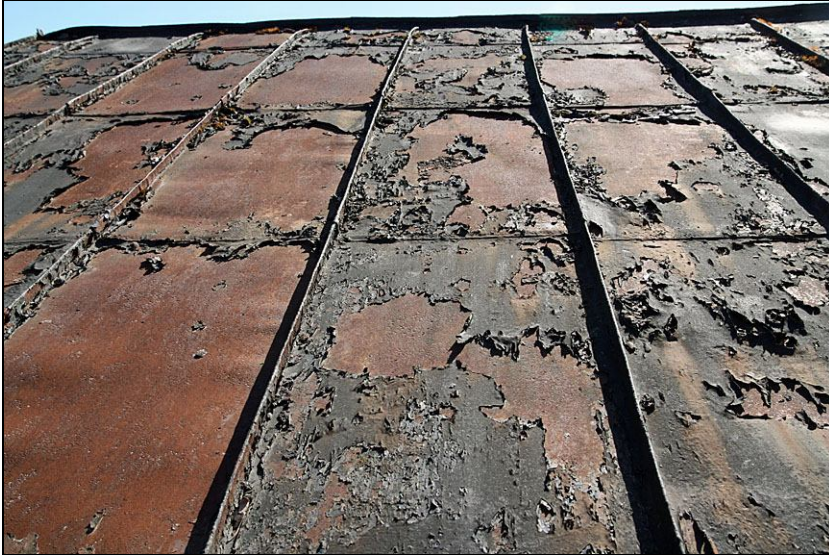
2010-05-07. Plåttaket innan omläggning. Taket hade omfattande ytrost, klammerlossning och på vissa ställen genomrostade partier.
