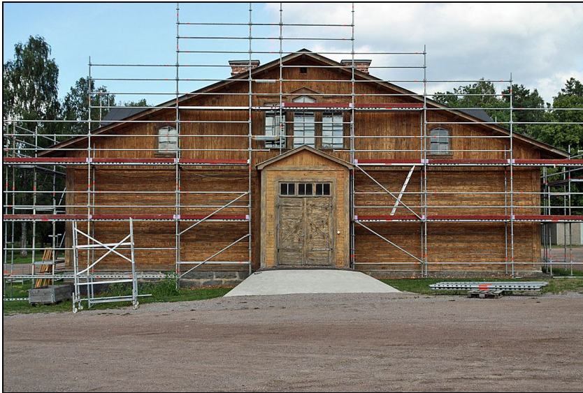
2010-08-11. Norra stambaracken från norr. Under restaurering. All färg på gavelfasaden har avlägsnats.
