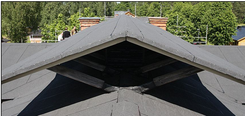
2010-06-22. Efter restaurering. Skärmtaket ovanför ventilationshuvven har reparerats och fått ny papp-täckning. Pappen har vikits runt kanten och spikats.
