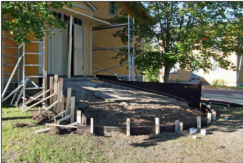
2010-09-20. Form-sättning inför om-gjutning av betong-ramp.
