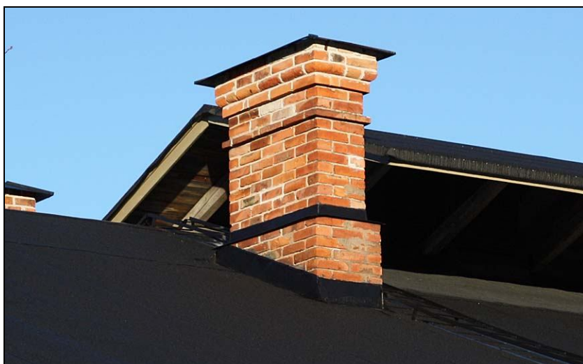
2010-10-25. Skorstenen efter restaurering.
