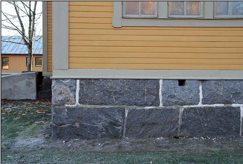
2010-10-25. Stenfoten vid det nordvästra hörnet efter restaurering. Fogarna har kompletterats med kalkbruk.
