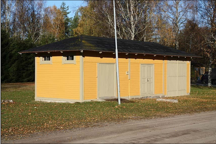
2010-10-25. Brandboden från sydost. Efter restaurering.
