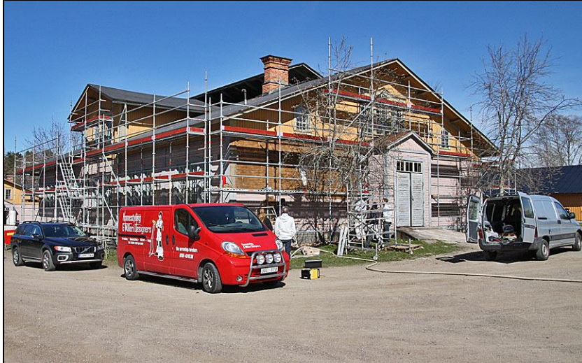
2010-05-07. Mellersta stambaracken från sydväst under pågående färgborttagning.
