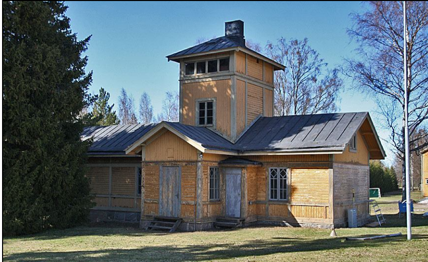
2010-05-07. Badhuset från sydost efter skrapning av nedre delen av fasaderna.
