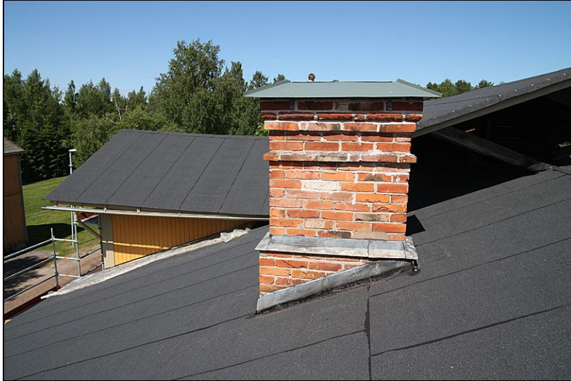
2010-06-22. Skorsten efter restaurering och takfall med ny papp.
