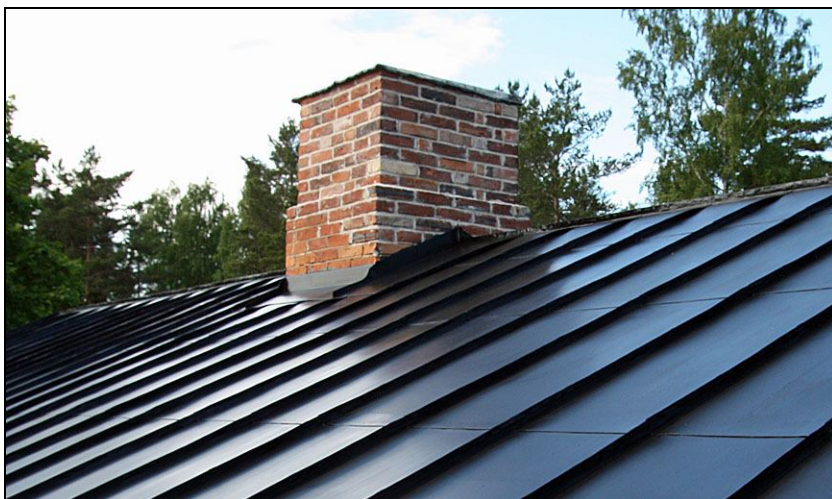
2010-06-22. Skorstenen efter färdiglagt plåttak och återmonterat överbeslag.
