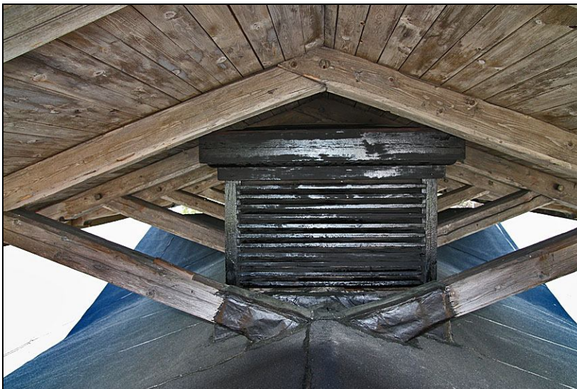
2010-06-22. Efter restaurering. Ventilationshuvven har strukits med svartpigmenterad trätjära.
