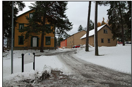
Kalvhagen från nordväst med gevärsförrådet närmast i bild.
