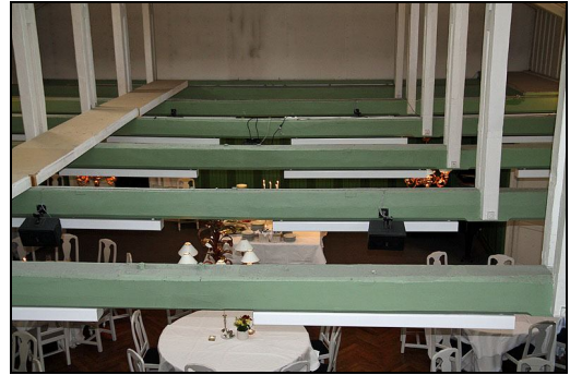
Den öppna takstolskonstruktionen över marketenterihallen.
