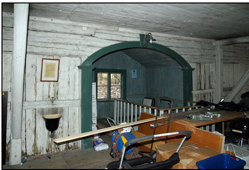
Utbyggnaden på brunshusets baksida, som rymmer själva brunnen.
