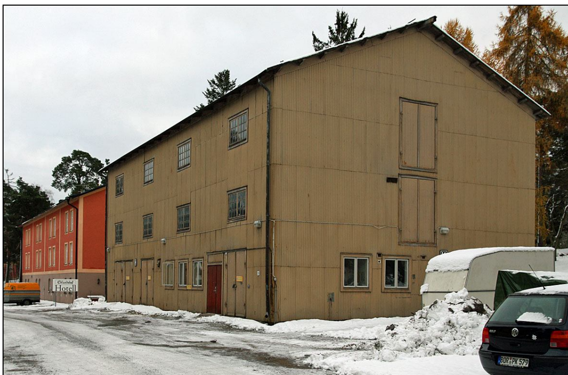
Södra plåtförrådet från norr.
