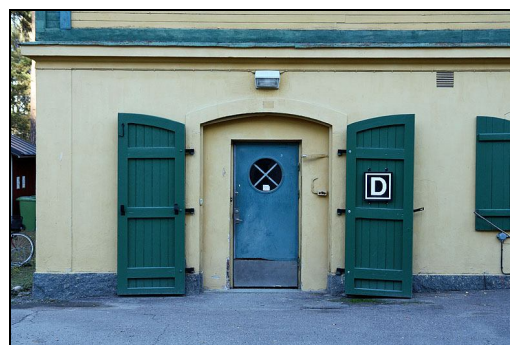
Slagport till bottenvåningen vid byggnadens nordvästra hörn.
