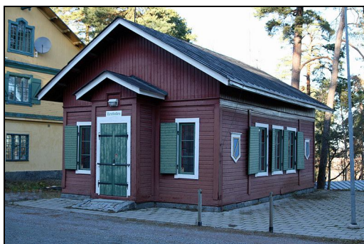
Ammunitionsförrådet från söder.
