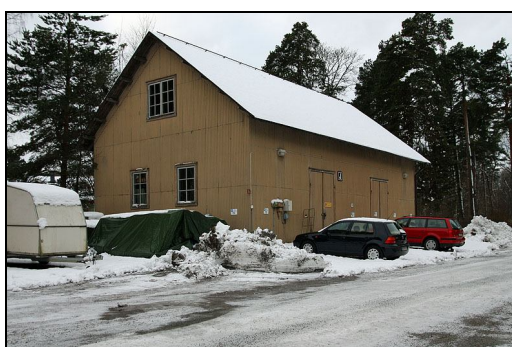
Norra plåtförrådet från öster.
