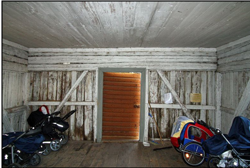
Brunshusets interiör mot söder.
