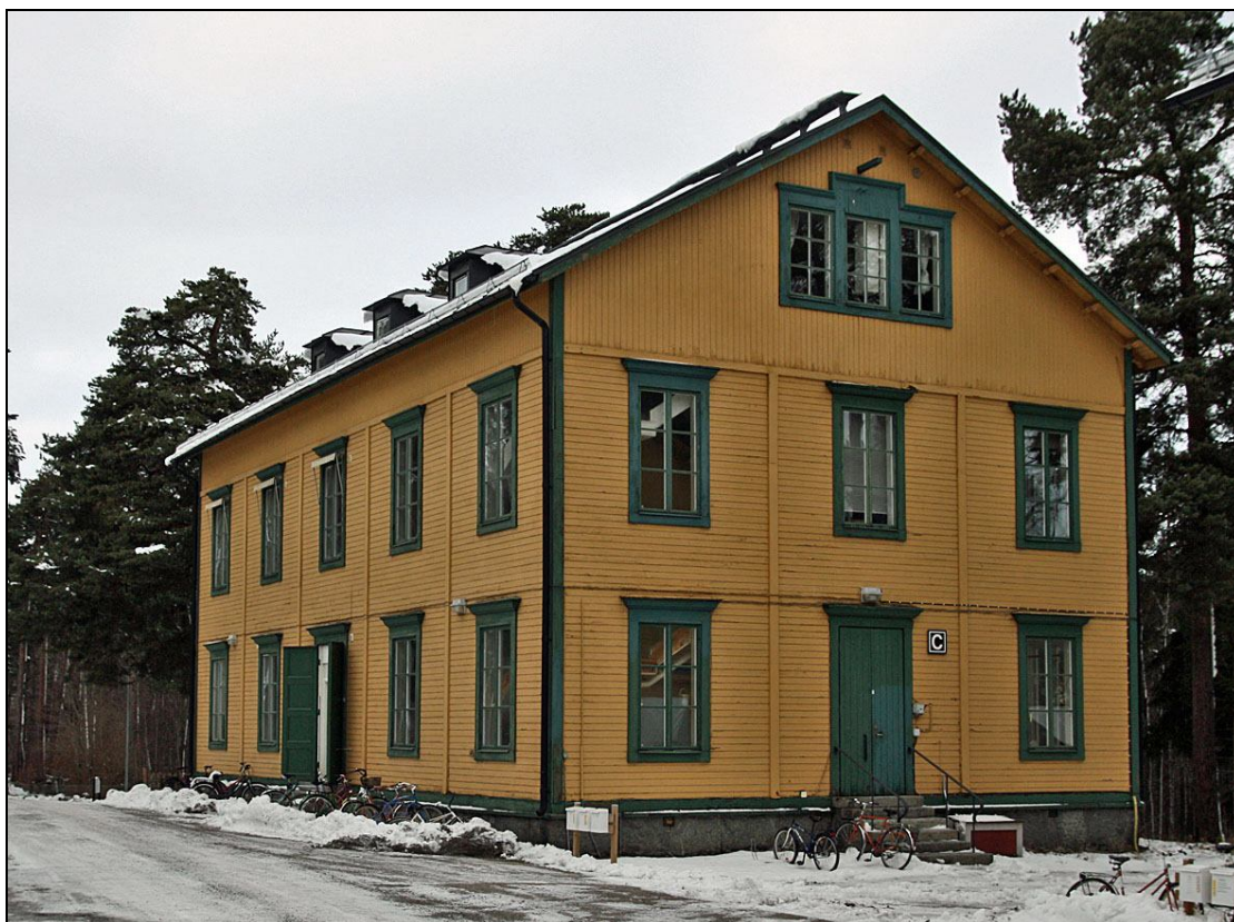
Gevärsförrådet från sydost
