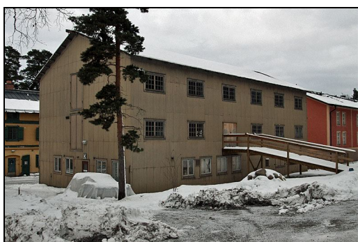
Södra plåtförrådet från väster.
