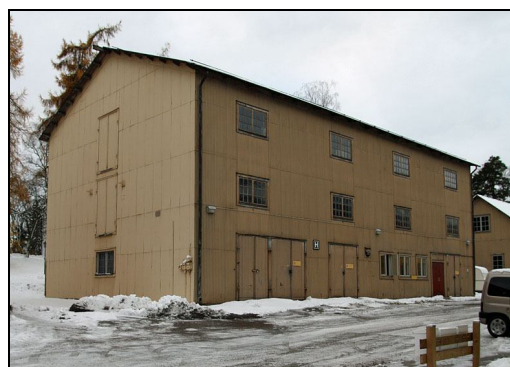
Södra plåtförrådet från öster.
