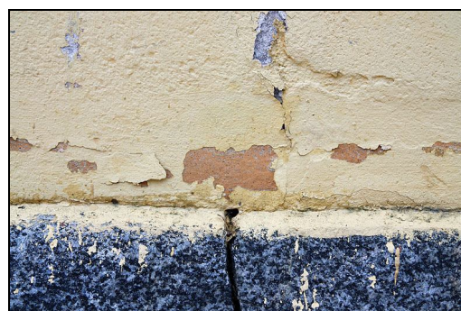
Äldre färgsättning syns bakom det nuvarande färglagret.
