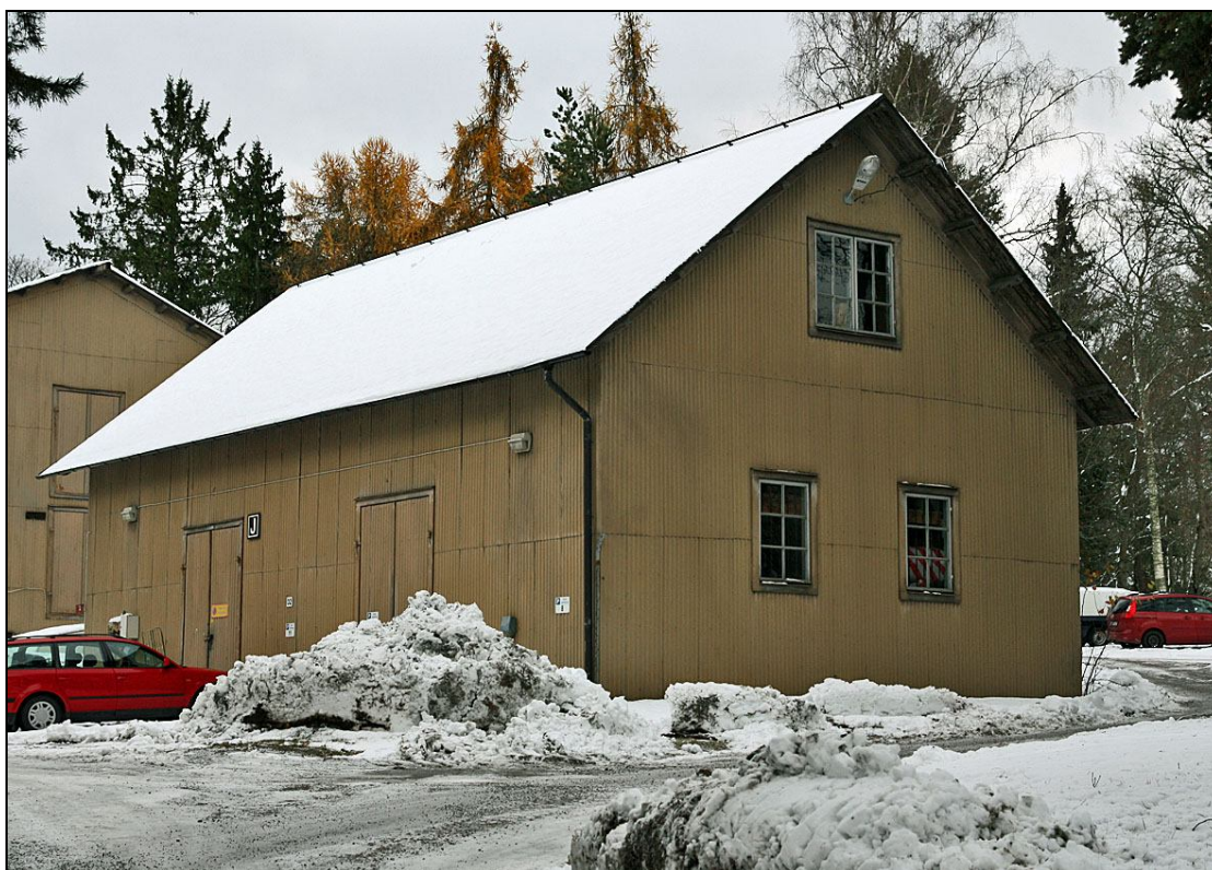
Norra plåtförrådet från norr.
