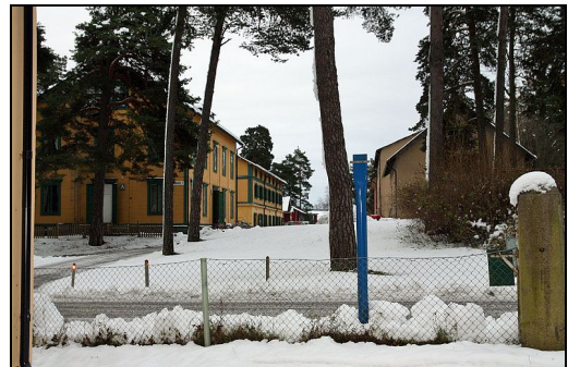
Kalvhagen från nordväst med gevärsförrådet och persedelförrådet till vänster i bild och norra plåtskjulet och södra plåtskjulet till höger i bild.
