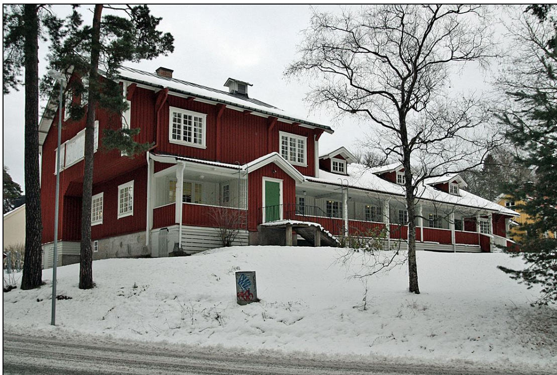
Marketenteribyggnaden från väster
