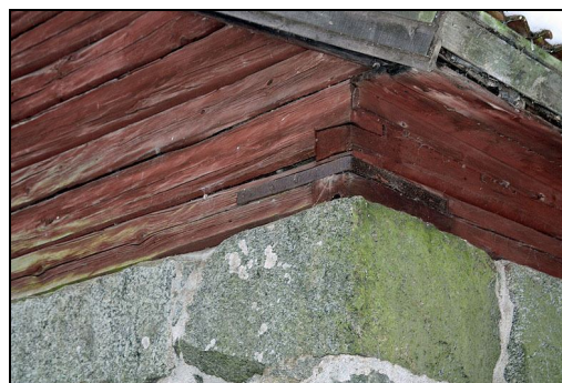
Detalj av den södra knutkedjan.
