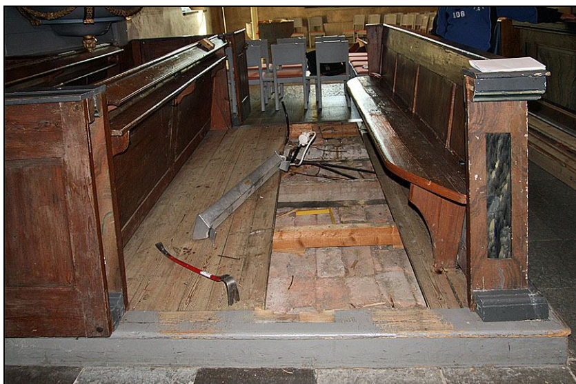
2010-09-27. Bänk nr 2 har demonterats liksom underliggande brädgolv från 1929.
