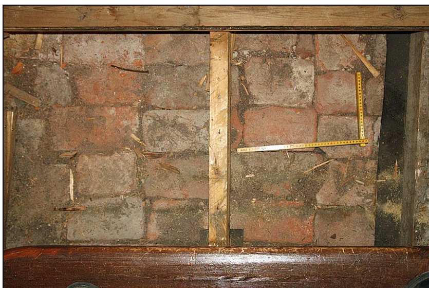
2010-09-27. Brädgolvet låg på bärlinor av sågade 2"4 regler. Bärlinorna låg i sin tur på ett undergolv av tegel, löst satt i sand. Undergolvet är inte lagt i förband och helsten, 1/2-sten och 3/4-sten blandas. Teglet är handslaget, ca 32 x 13,5 x 8,5 cm och har spår av kalkbruk på undersidan. Troligen har tegelstenarna återanvänts när det medeltida tegelstensgolvet bröts upp och ersattes av kalkstensplattor. Tegelstenarna är av samma utförande som de som ligger som golv i sakristian.
