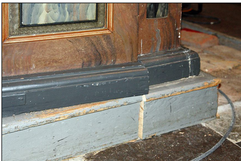
2010-09-28. Bänkkvarteret var något kilformat. Detta innebär att sockelns bakre del fick slipas ner för att gå i linje längs mittgången. Sockelns överstycke flyttades in för att passa i sin nya position.
