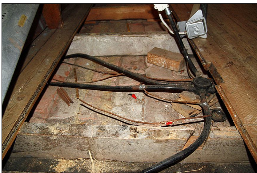
2010-09-27. I ett av facken fanns elinstallationer med stålrör, möjligen från restaureringen 1929.
