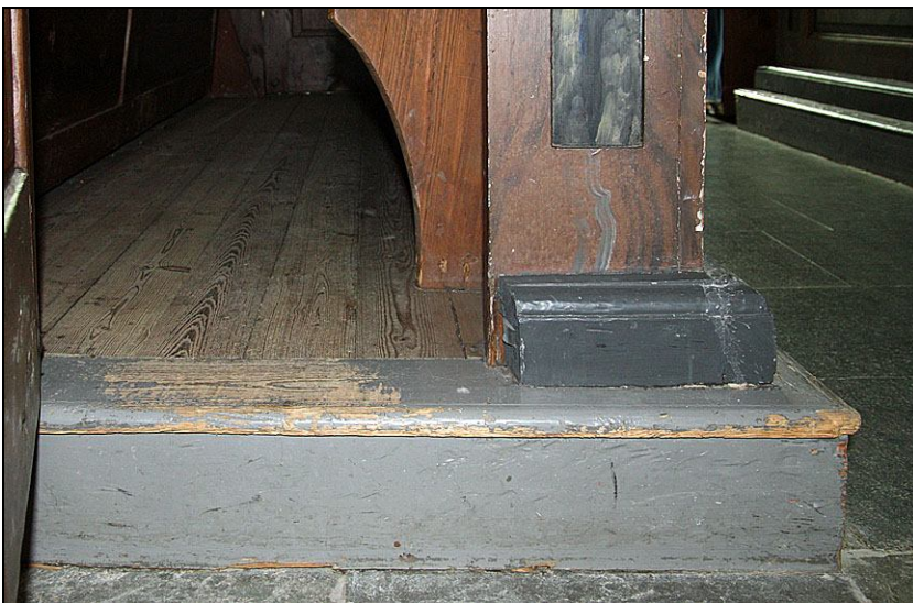
2010-06-09. Bänk- kvarteret innan åtgärd. Sockel till bänk nr 1.
