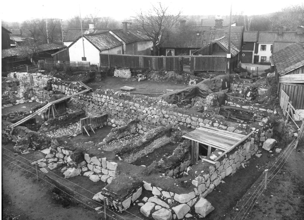
Figur 2. Klostret under utgrävning fotad från sydöst. På fotot ses Klostrets östflygel (th i bild) och östra delen av den södra flygeln. På bilden framgår tre av de gårdar som från och med 1700-talet kom att uppföras över Klosterruinens norra del, samt över Klosterkyrkan. Gatan som löper mellan husen som skimtar i bildens högra hörn är Munksundsgatan. Undersökningen som pågick mellan 1929-1931 har id-nummer 192901 i StadsGIS. Foto Nils Sundquist, Upplandsmuseets arkiv.
