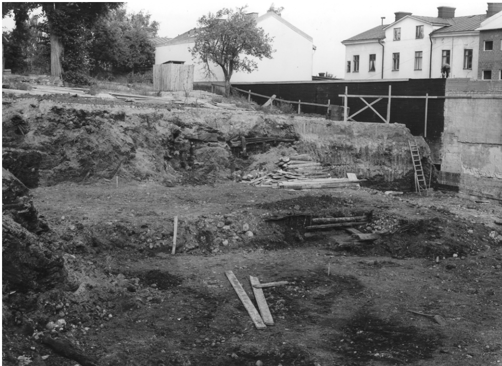
Figur 54. Utschaktning av kvarteret Apotekaren sommaren 1955. I bildens mitt något till höger ses resterna efter den märkliga anläggning som av Anna-Märta Berg beskrivs i originaldokumentationen som en vägbank kallad "Sandbron". I SR-registret anges denna som grusbank och i Medeltidsstaden finns tillägget (gata?). Foto Anna-Märta Berg 1955, Upplandsmuseet.
