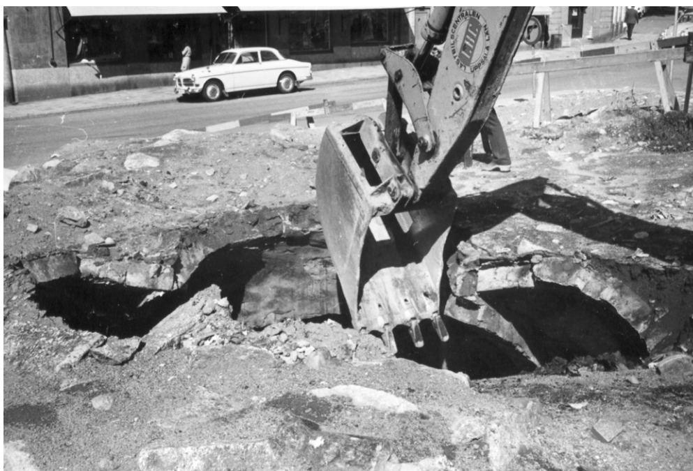
Figur 17. Rivning av senmedeltida gotiska källarvalv vid den s.k. Långholmen 1968. Undersökningen som är av byggnadsarkeologisk karaktär har id-nummer 196801 i StadsGIS Enköping. Fotograf okänd, Upplandsmuseet.
