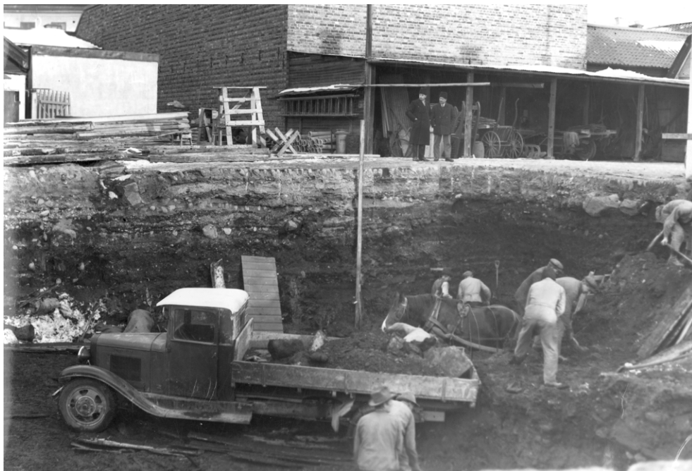
Figur 47 och 48. Byggnadsarbeten i kvarteret Borgmästaren i januari och februari 1934. I bakgrunden på bilden ovan skimtar Stora torget och en nyfiken publik. I samband med arbetet gjorde Nils Sundquist några arkeologiska iakttagelser av bl.a. husgrunder, stenläggningar, en brunn, rustbäddar och risgärdesgårdar. Undersökningen har id-nummer 193401 i StadsGIS. Foto sannolikt Nils Sundquist, Upplandsmuseet.
