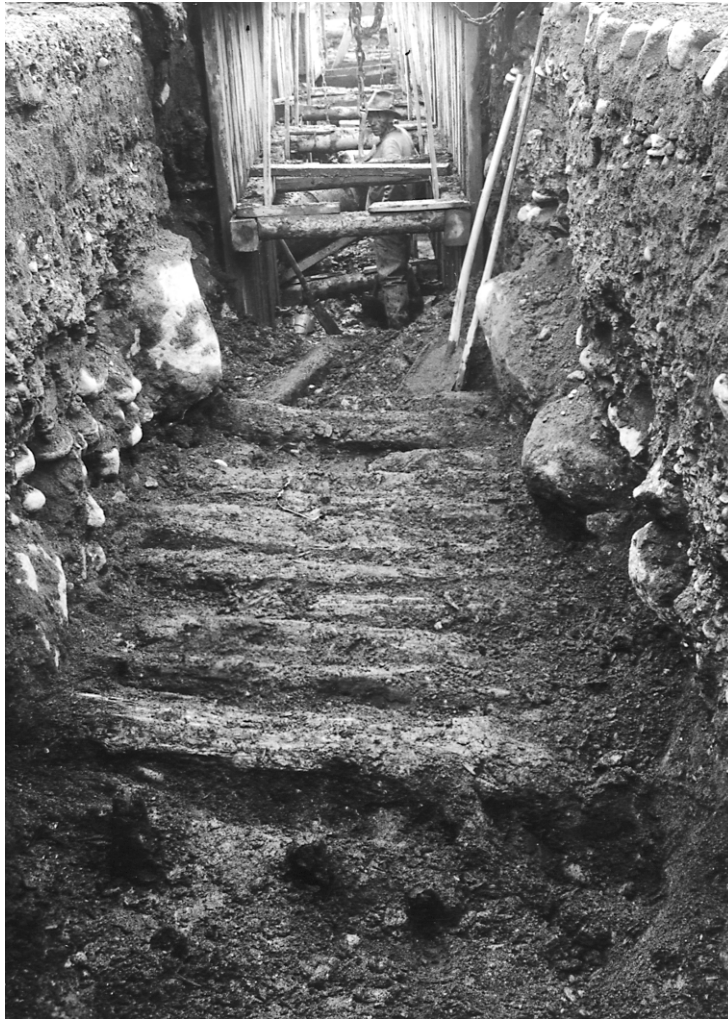
Figur 30. Vid grävning av huvudkloak i Ågatan sommaren 1930 påträffades lämningar efter äldre stadsbebyggelse, stående och liggande pålkonstruktion och grundmurar samt en hel del lösa fynd. Undersökningen har id-nummer 193001 i StadsGIS. Fotograf okänd, Upplandsmuseet.
