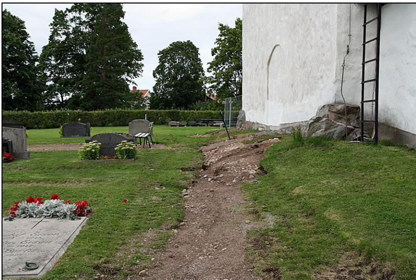
Det igenfyllda schaktet till genomföringen i västväggen. De delar av västväggens grundmur som blottades vid grävningarna och håltagningen saknade egentlig undergrund utan bestod endast av yttligt lagda stenar.
