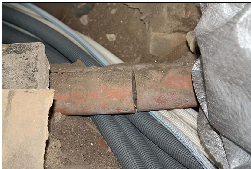
2010-09-30. Äldre tegelrör, sannolikt för elledningar.
