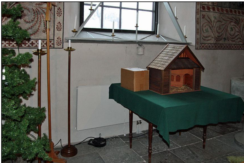
2010-12-15. Ny panelradia- tor under korfönstret mot söder.
