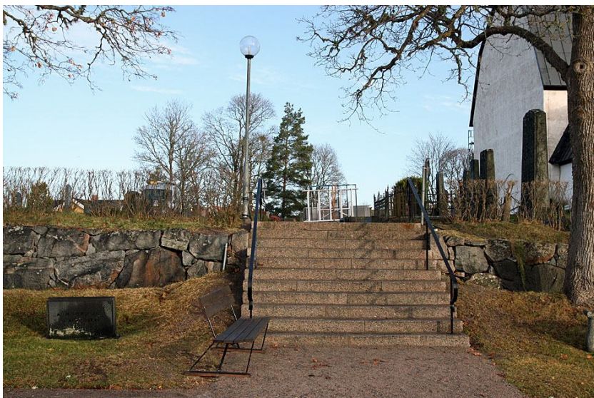
2010-10-28. Trappan efter återläggning. Återläggning har skett i jordfuktad cement.
