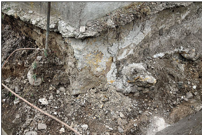
2010-08-20. Frilagt part av sockel vid sakristians nordvästra hörn. Sockelns utseende antyder att marknivån tidigare har varit ett par decimeter lägre. Under marknivån finns bland annat en gul, genomfärgad cement- eller kalkcementputs. Spår av gul avfärgning finns också högre upp på sakristians vägg.
