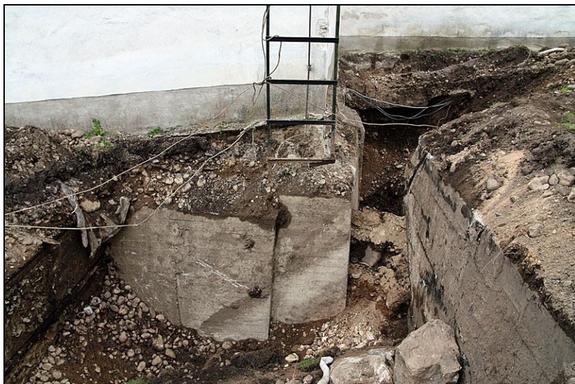
2010-08-20. Friläggning av väggen till sakristians källare. Källaren är utförd 1973 i formgjuten betong. Vid restaureringen skulle källarens väggar fuktisoleras. Efter bedömning av utseendet på väggen och med hänsyn till markens goda dränerande förmåga bedömde man att det räckte att isolera den lutande klacken mellan sockeln och källarväggen.
