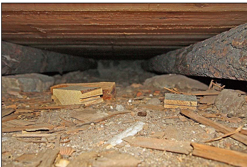
2010-09-16. Lång- huskvarterets bjälklag med obarkade, sågade bärlinor som vilar på stenar i sandfyllning.
