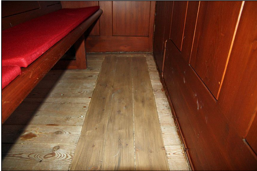
2010-12-15. Lagat skurgolv i det norra bänkkvarterets främsta rad. Nya, patine- rade bräder har lagts in tvärs de gamla.
