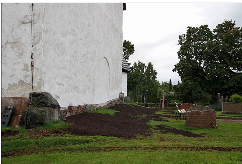
Lagningen avslutad med ett lager matjord med gräsfrön.
