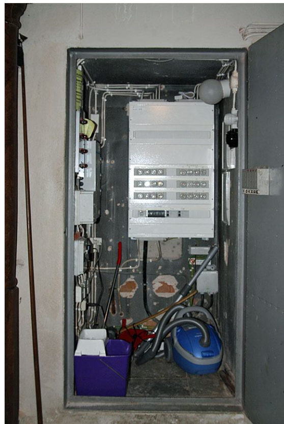
2010-12-15. Nytt elskåp har monterats och de gamla installationerna har demonterats.
