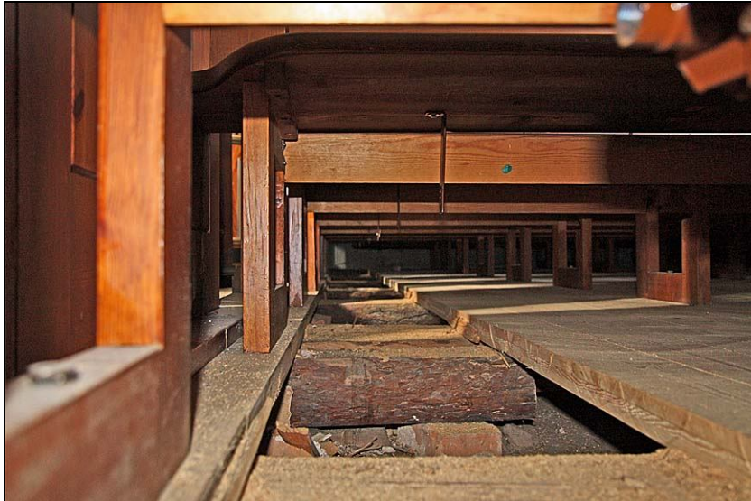
2010-09-16. Södra långhuskvarterets plankgolv efter upp- tagning av tre plank- or närmast mitt- gången. Plankornas spont har sågats av för att det ska vara möj- ligt att lyfta dem
