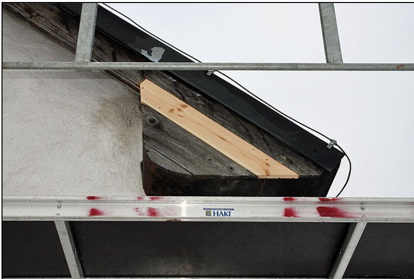
2010-11-11. Infällning av ny bräda vid sakri- stians takfot. Brädan ska tjäras i likhet med omgivande virke när väderleken tillåter.
