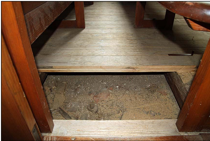
2010-09-16. Lång- huskvarter efter upp- tagning av plank.
