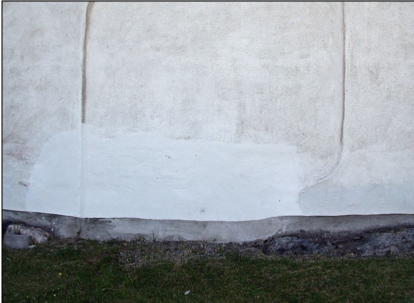
2010-06-23. Vattenledningarna drogs in via kyrkans västvägg, strax under marknivån.
