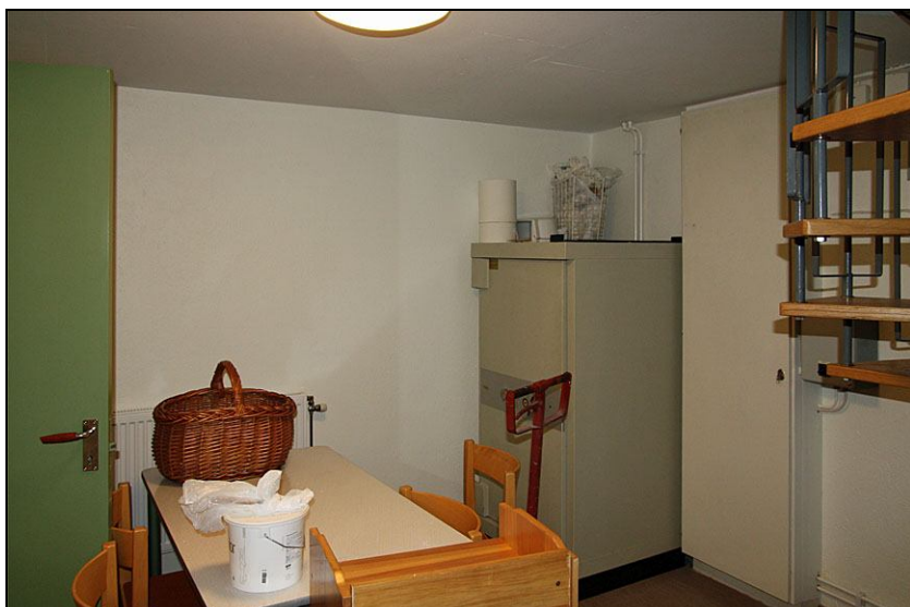
2010-12-15. Väggar i sakristians källare efter ommålning av väggar.
