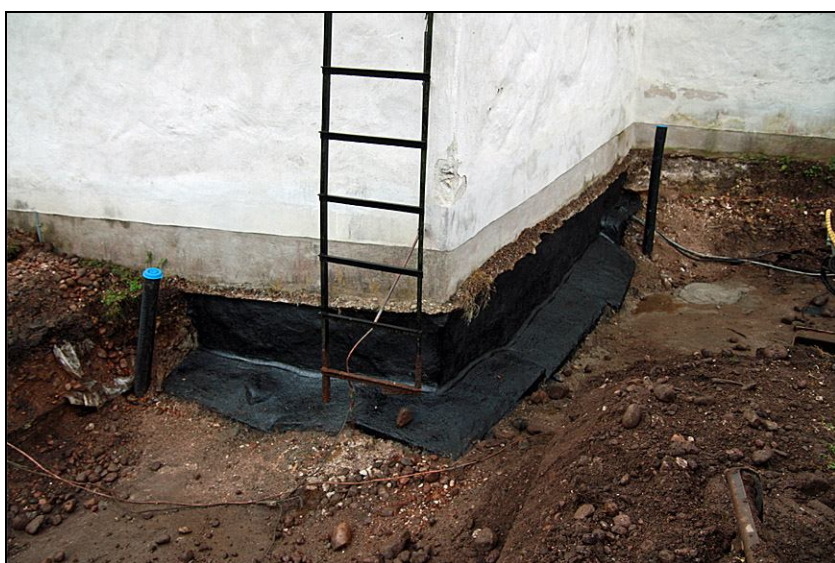
2010-09-02. Sakristians hörn efter grundisoleringsring med asfalt och återfyllning av det uppgrävda schaktet.
