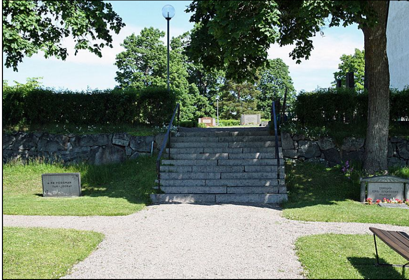
2010-06-23. Stentrappa mellan den äldre, övre kyrkogården och den nyare, lägre. Vattenledningarna för värmesystemet drogs i schakt längs gångarna och stentrappan fick demonteras.
