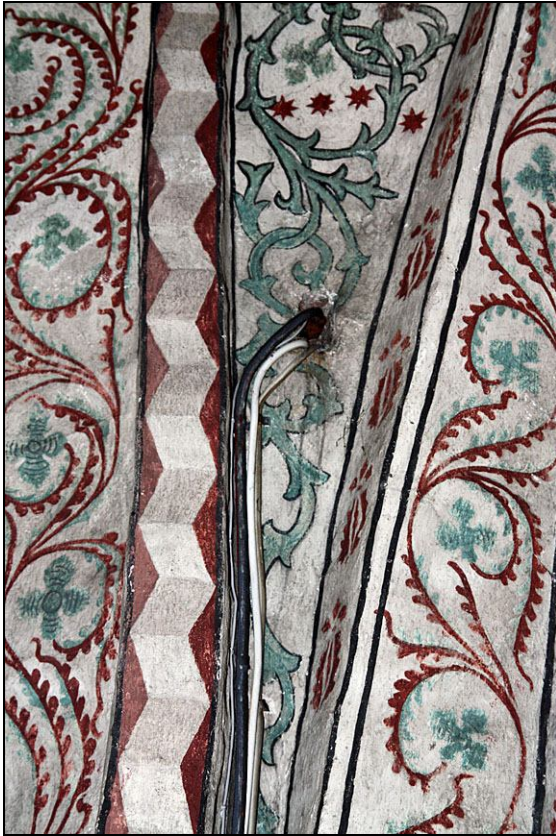
2010-06-23. Tidigare kabelgenomsöringar i valvsvickel i läktarens sydvästra del.
