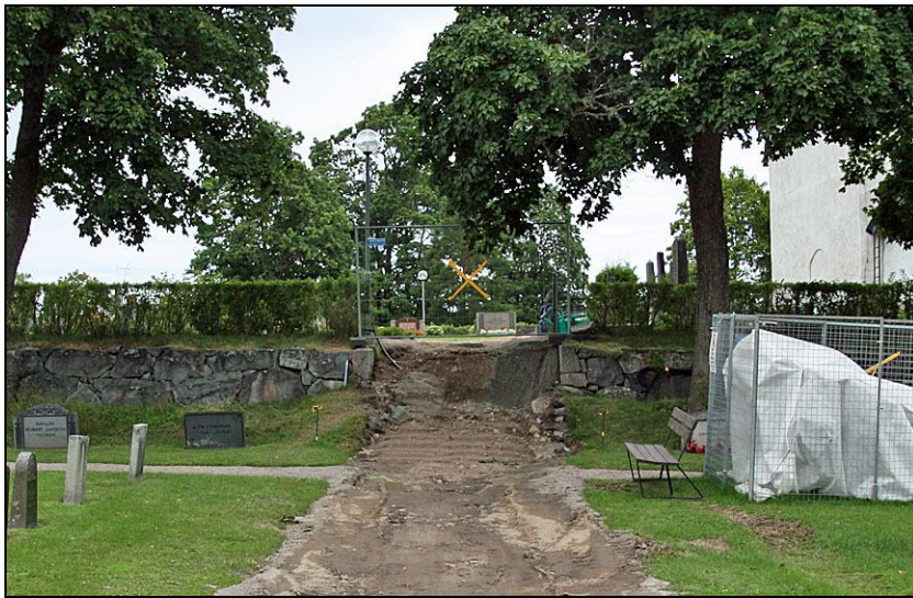
2010-08-20. Samma plats som ovan efter nedplockning av trappan, schaktgrävning och återläggning av grus.
