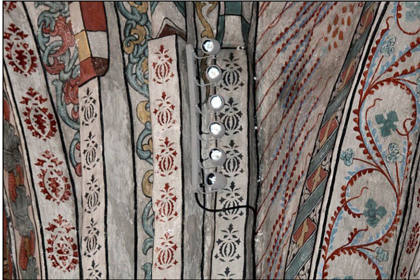
2010-12-15. Ny armatur med spottar på triumfbågens norra sida.
