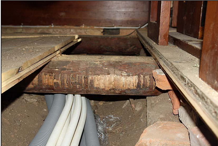
2010-09-30. Sanden under bärninorna har grävts bort och slangar har dragits.
