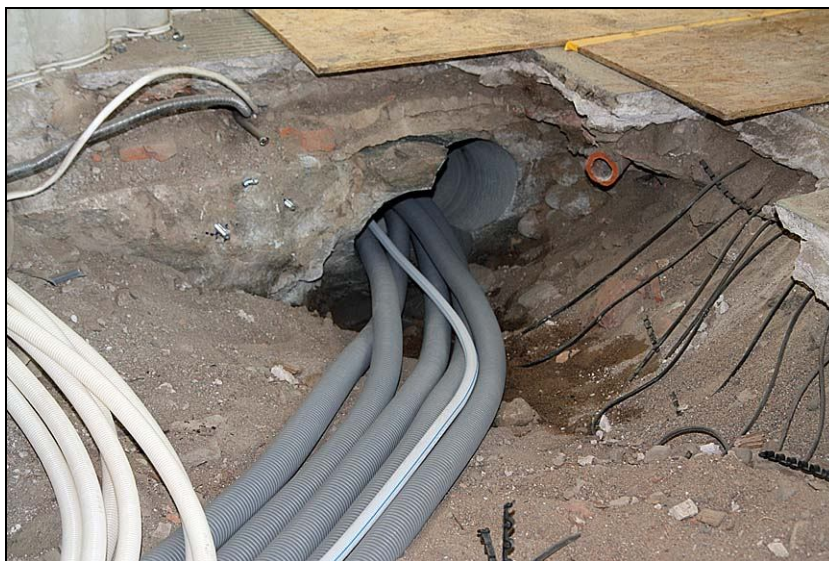
2010-09-30. Kalkstensgolvet i koret invid ingången till sakristian har tagits upp och hål har borrats genom grundmuren för ledningar.
