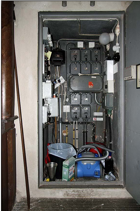
2010-06-23. Utrymme för elskåp och städutrustning i västväggen under läktaren.
