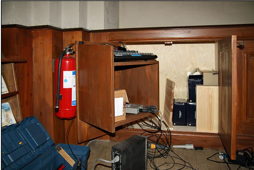
2010-12-15. Mixerbord och annan utrustning har monterats på en av skåpets dörrar, så att det kan fällas ut vid användning och döljas däremellan.
