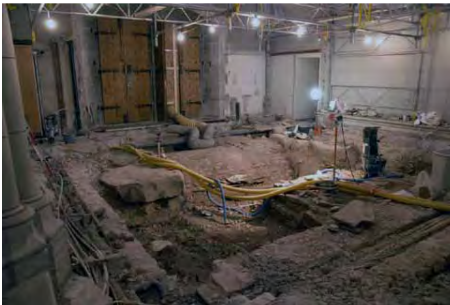
Figur 25. Foto av undersökningsytan från sydväst. Till vänster syns det stora läktarfundamentet A5 och tunnvalvet till källaren A6. Vid undersökningen naggades läktarfundamenten hårt i ovansidan för att den nya grundläggningen till orgelläktaren skulle få plats. Foto: Bengt Backlund, Upplandsmuseet.
