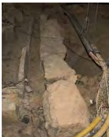
Figur 21. Tröskelstenarna A26 innanför den norra portalen hade i sen tid bilats av för anläggande av ett effektivare värmesystem. Foto: Bengt Backlund, Upplandsmuseet.
