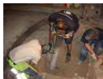
Figur 3. Utschaktningen av jordmassor skedde i gott samarbete och genom hårt arbete i högljud och dammig miljö. För lösa, och med bilmaskin lösgjorda, massor användes en torrsug, dvs en lastbilsmonterad vacuum- dammsugare av större format. Detta visade sig storleken till trots vara ett utmärkt universalredskap i rätt händer och förbättrade arbetsmiljön avsevärt. Foto: Ola Hjertz, Rosendahls bygg AB.
