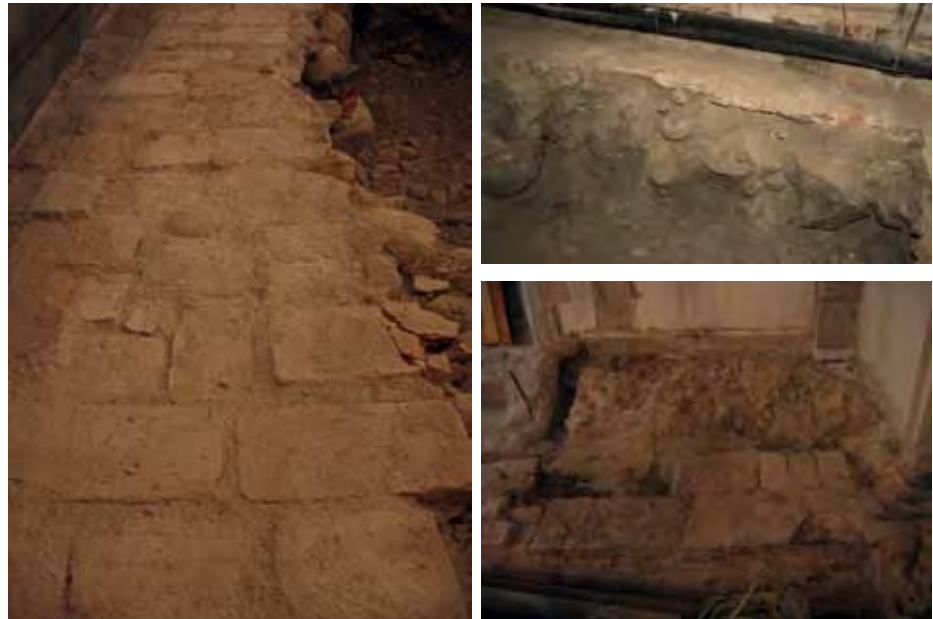
Figur 22. Transeptets ursprungliga tegelgolv låg på en lägre nivå lägre än övrigt i kyrkan och hade bara bevarats ovan grundmurarna (överst t. h.). Partier med golvbeläggning av kullersten och kalkstensplattor (nederst t.h) fanns av oklar anledning till vänster och höger om den norra portens
