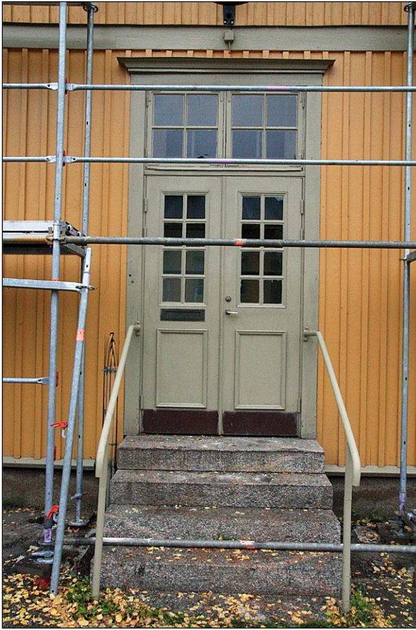
2011-09-28. Entré åt öster efter restaurering.
