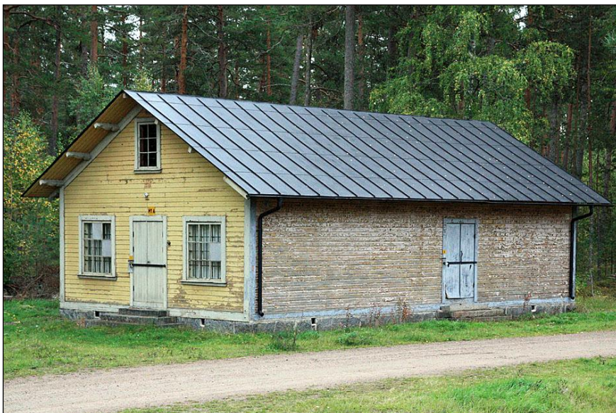
2011-09-28. Byggnaden från nordväst efter avslutad restaurering.
