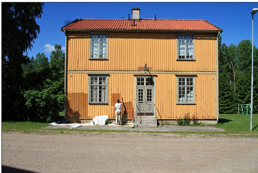
2011-06-29. Östra fasaden. Takpannorna har rengjorts, men beslut fattades om omläggning eftersom pannorna var i dåligt skick.
