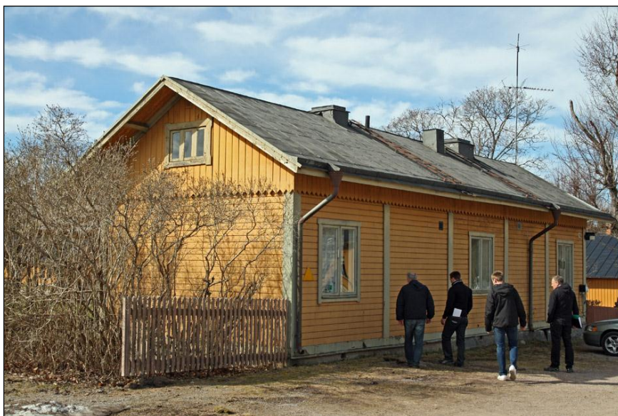
2011-04-18. Byggnaden från nordväst innan restaurering.
