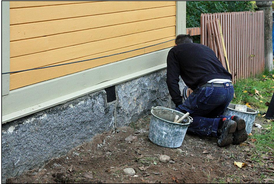
2011-09-28. Komplettering av fogar.
