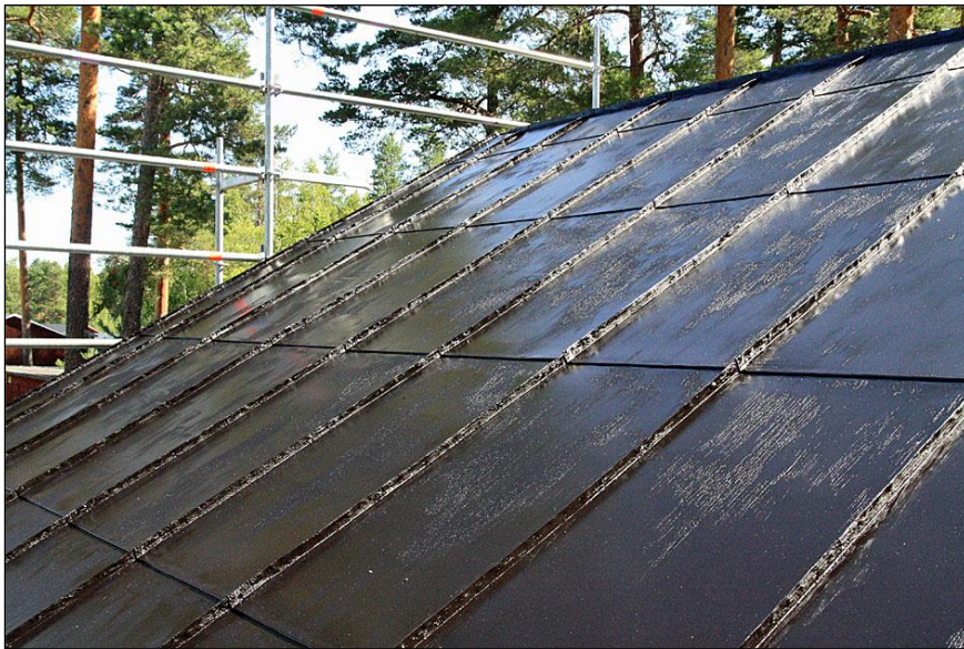
2011-06-29. Västra takfallets norra del efter nyläggning av plåt samt målning.
