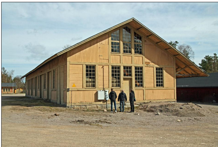
2011-04-18. Den södra gaveln innan renovering.
