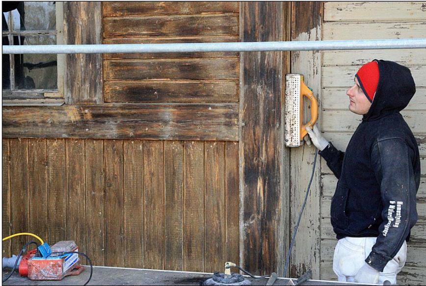
2011-05-05. Färgbortagning med infravärme.
