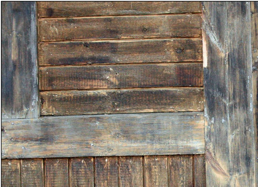
2011-05-05. Fasadparti på byggnad 008, serviceförråd, efter färgborttagning med infravärme. Den liggande respektive stående fasspontpanelen har tydliga spår efter ramsågbladet medan det omgivande listverket är hyvlat.
