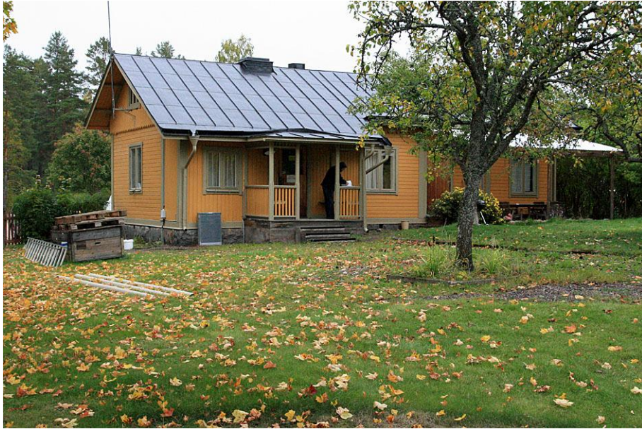
2011-09-28. Byggnaden från sydväst efter restaure- ring.
