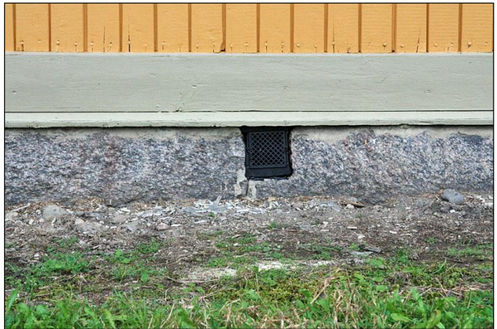
2011-09-28. Stenfot med nyinsatt ventilationsgaller.
