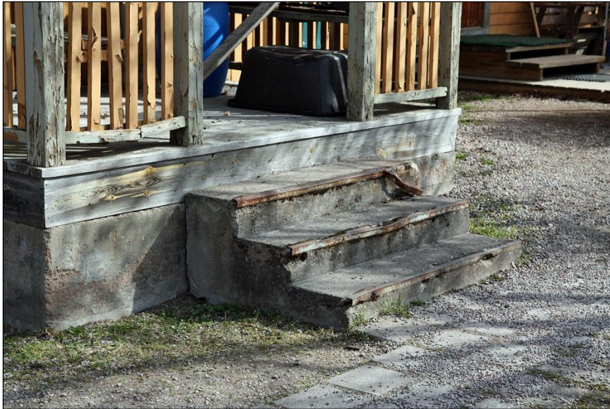
2011-04-18. Detalj av verandan med gjuten trappa
