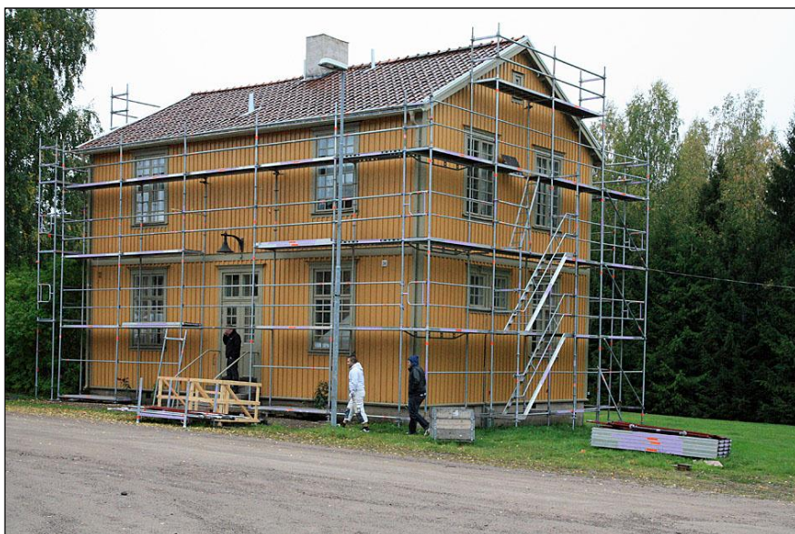
2011-09-28. Byggnaden från nordost efter restaurering. Takfallet har lagts om.
