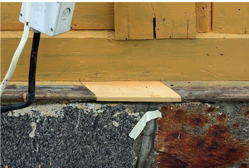
2011-05-05. Lagning av sockelvattnbrüda på västra fasaden.
