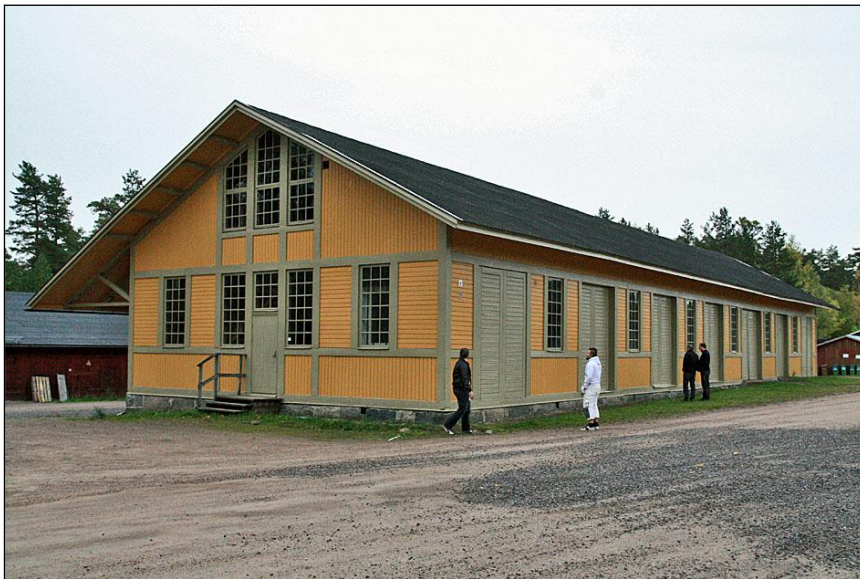
2011-09-28. Byggnaden från sydost efter avslutad restaurering.
