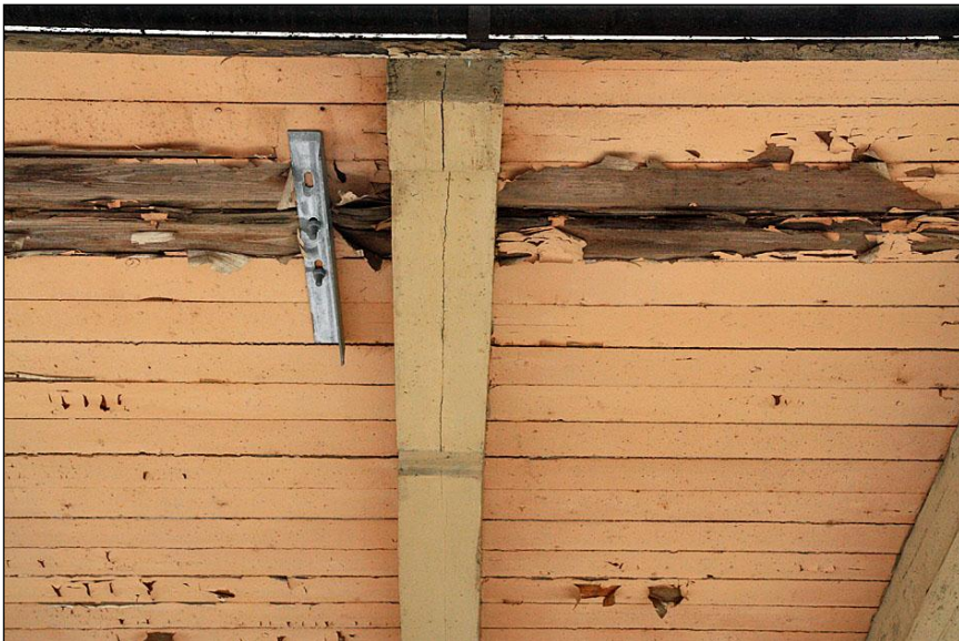
2011-05-05. Skärm- taket åt öster med fästen för snörasskydd innan restaurering.
