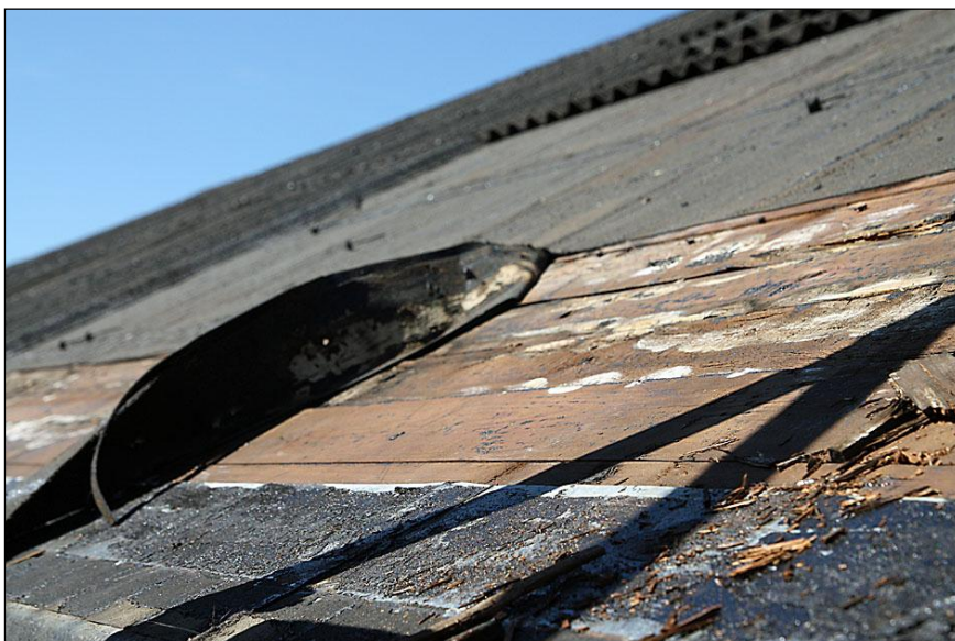
2011-05-26. Demonterat yttertak med underlagspapp och rötskadad underpanel. Skärmtaket i öster.
