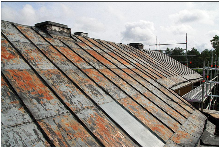
2011-08-16. Takfall åt söder.
