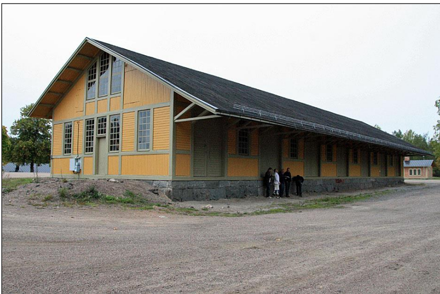
2011-09-28. Byggnaden från nordväst efter avslutad restaurering.
