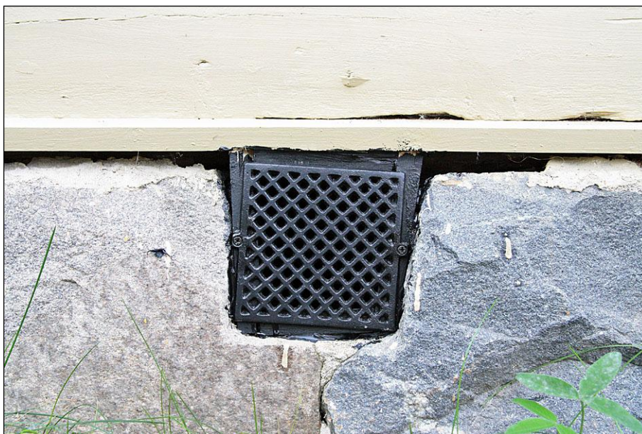
2011-09-28. Nyinsatt gallerventil till stensockeln på by 008.
