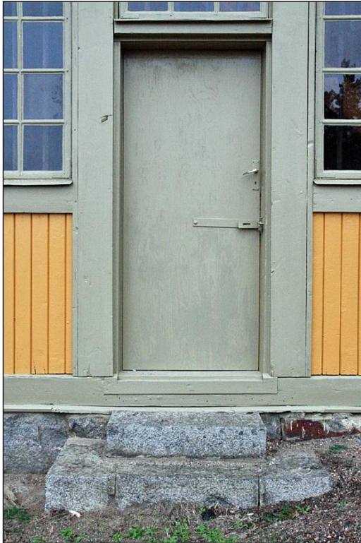
2011-09-28. Dörr på södra gaveln som fått en ny täckskena av plywood i stället för masonit.
