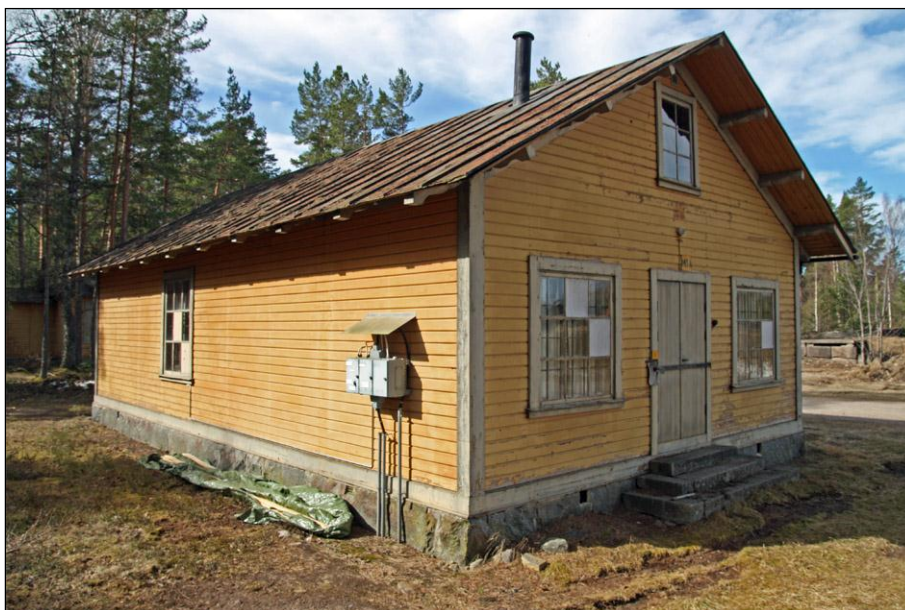
2011-04-18. Byggnaden från nordväst innan restaurering.
