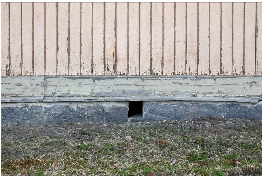
2011-04-18. Stenfot med ventilationsglugg utan galler. Den missfärgade, rosa färgen som återkom- mer på många byggnader i området är troligen målad
