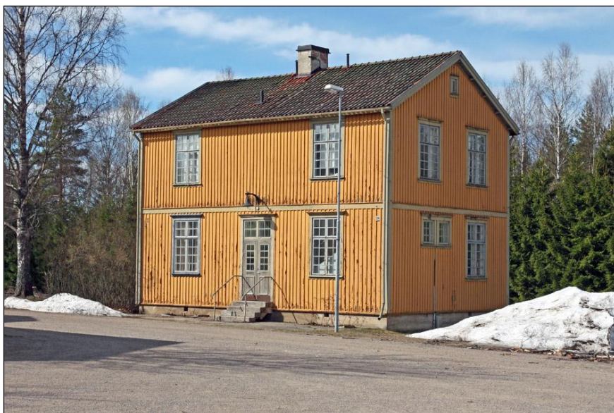
2011-04-18. Byggnaden från nordost innan restaurering.
