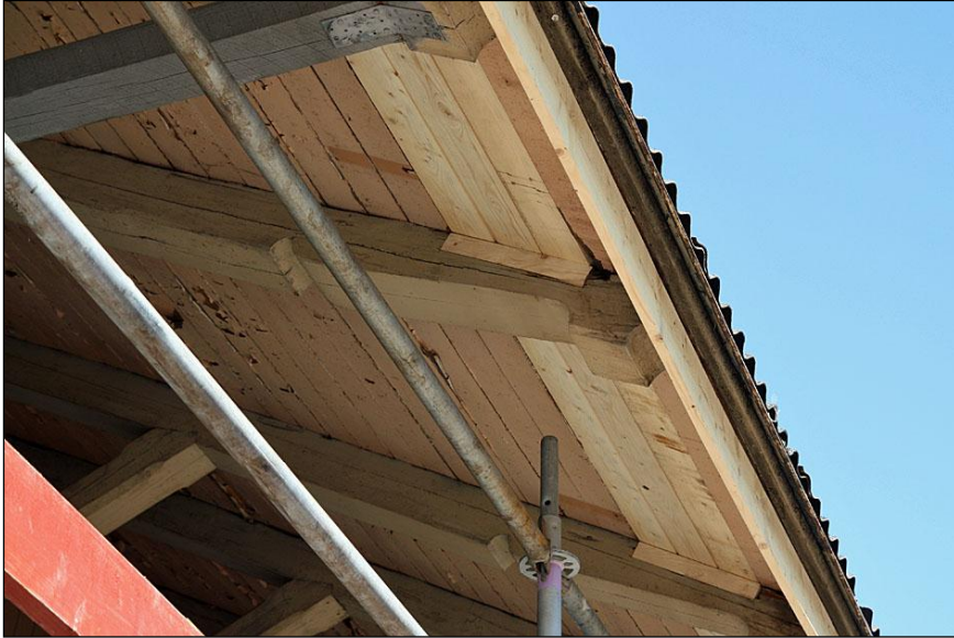
2011-05-26. Lagningar i takfoten på skärmtaket i öster
