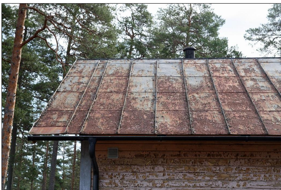
2011-04-18. Västra takfallets norra del innan restaurering
