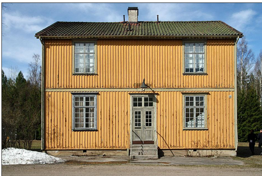
2011-04-18. Östra fasaden innan restaurering
