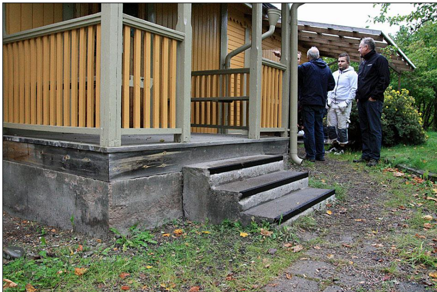
2011-09-28. Veranda efter restaurering. Trappan har fått nya kantjärn till trappnosarna.
