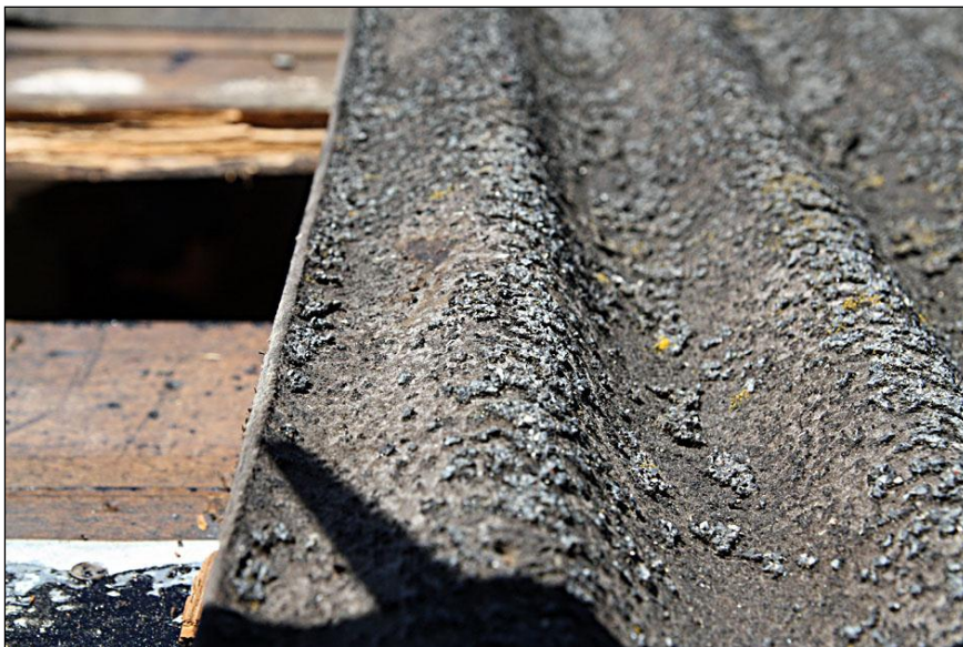
2011-05-26. Detalj av det sinuskorrugerade ondulinetaket.
