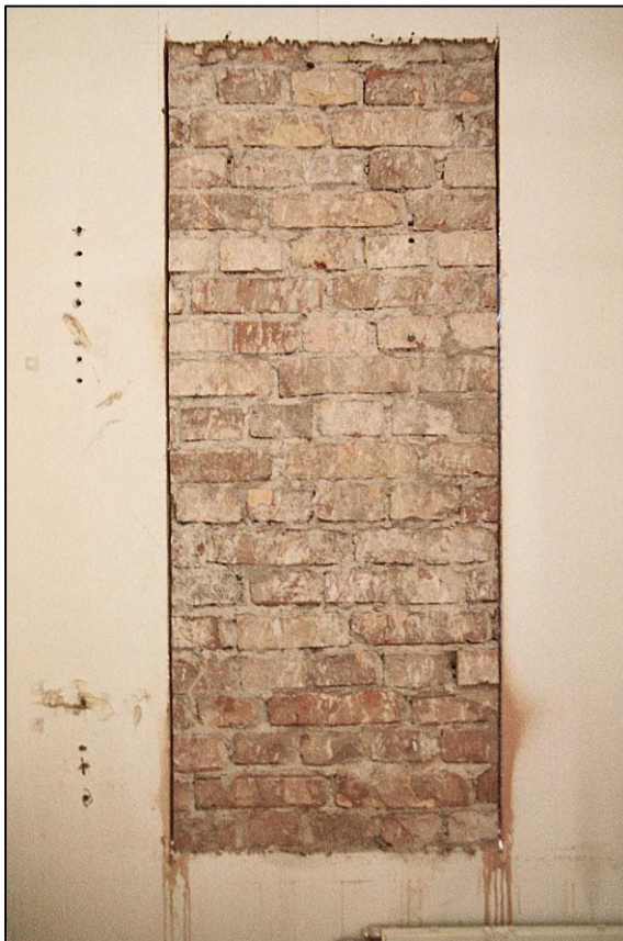
Förråd 214 med genomsågat murparti för ny fönsteröppning. Muren är uppförd i 1 1/2-stens tjocklek med kryssförband. 2011-06-16.
