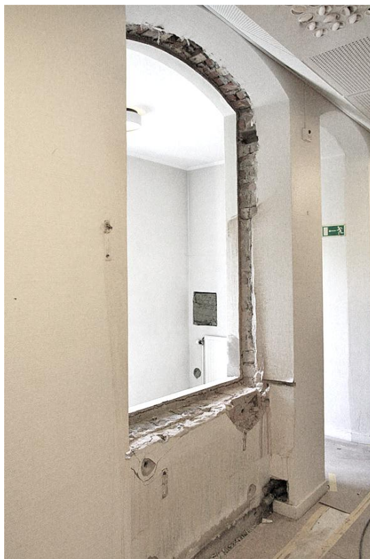
Passage 203 efter borttagning av fönsterkarm. 2011-06-07.
