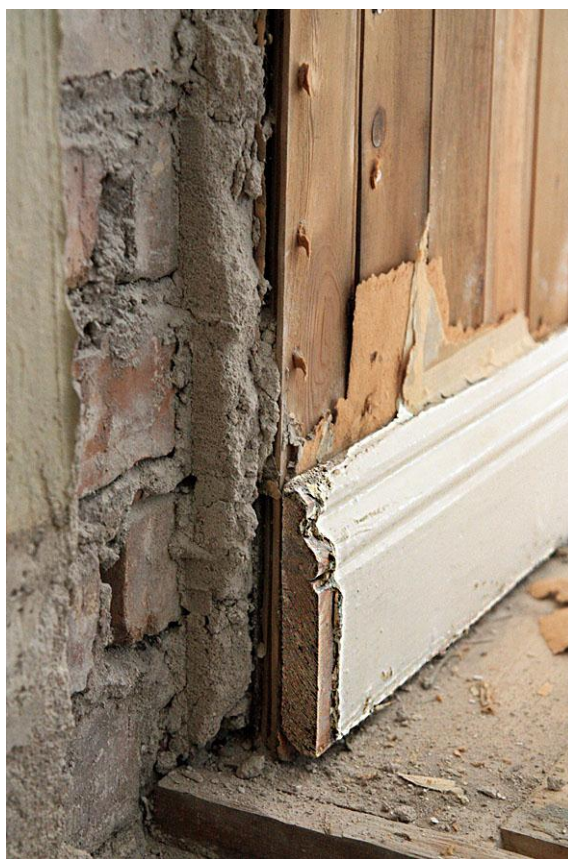
Rum 205, vägg mot sydost. Den murade väggen är täckt med omålad stående spontad panel. Väggen har täckts med papp och tapetsrats. Golvlisten har satts på plats efter tapetseringen. 2011-06-07.
