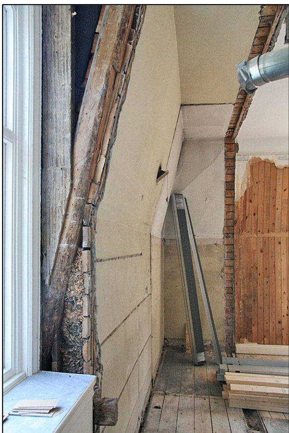
Rum 205 efter rivning av avbalkningen mot förråden 205A och 204A. Väggen mot nordost består av liggande bräder med vassrörning och puts. 2011-06-07.
