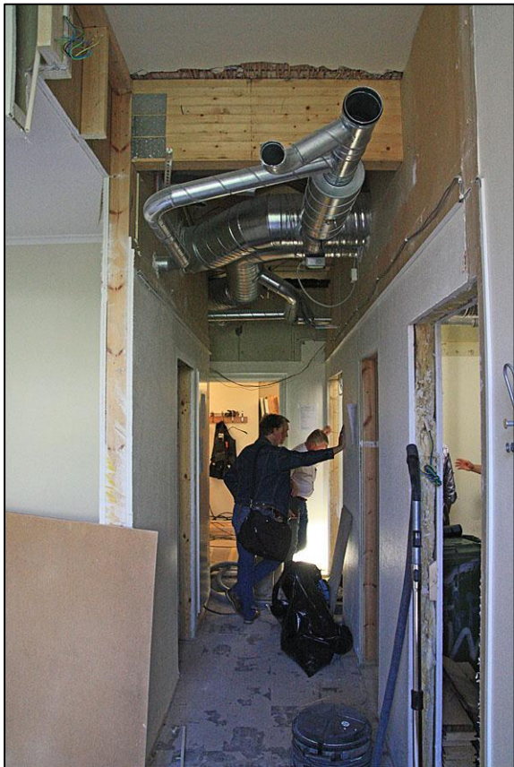
Passage 215. Ovanför det nedpendlade taket döljer sig omfattande installationer, bland annat för ventilation. 2011-06-07.
