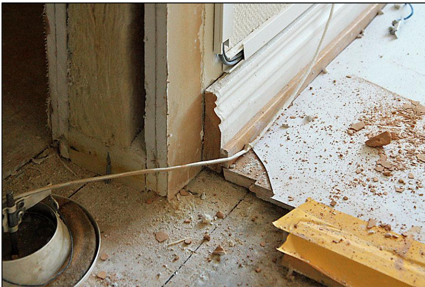
Passage 215. Bilden visar det ursprungliga brädgolvet som täckts med en sentida parkett. Den "allmogeprofilerade" golvlisten bör ha satts upp i samband med att den sekundära gipsväggen uppfördes. 2011-06-07.
