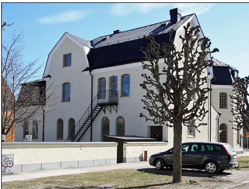
Nordvästra fasaden innan upptagning av nya fönsteröppningar. 2011-04-15.
