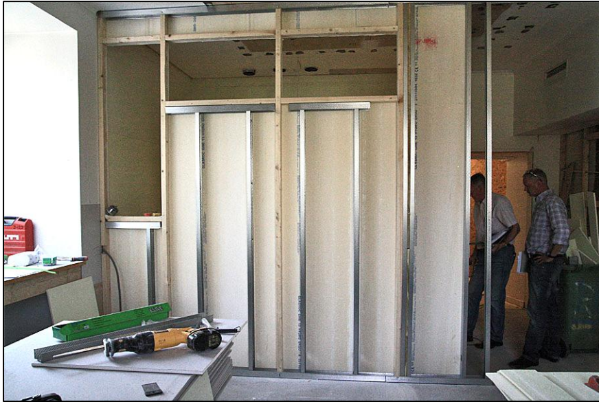
Rum 224. En skiljevägg byggs mellan kök (rum 224 A) och ett nyinrättat diskrum (rum 224 B). 2011-06-07.
