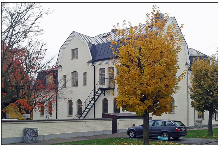
Nordvästra fasaden efter upptagning av nya fönsteröppningar. 2011-10-24.
