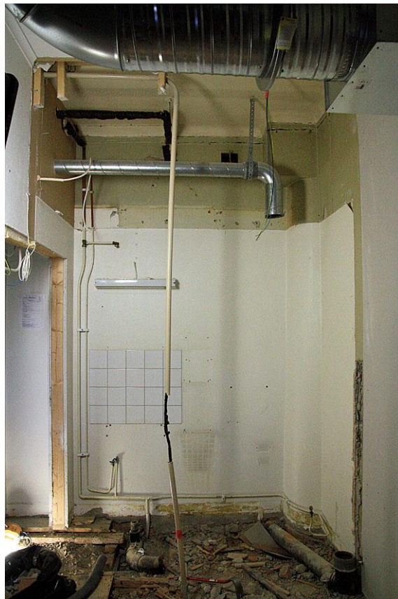
Rum 219 efter rivning av skiljeväggen mot förråd 214. 2011-06-07.
