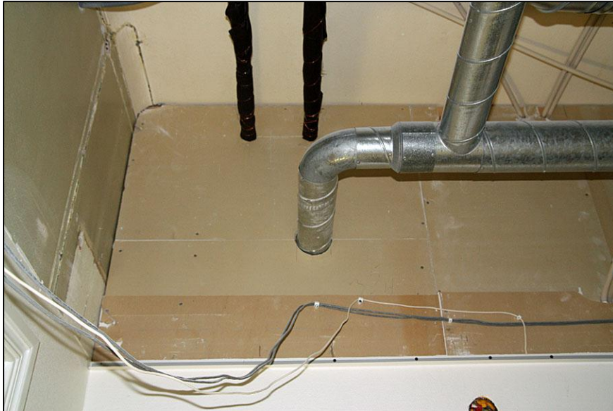
Passage 215 ovan vägg mot 219. Väggen har satts upp i samband med att man sänkte taket och drog avloppsledning, elrör och ventilationsrör i utrymmet mellan bjälklagets undersida och det nedsänkta taket. De äldre väggarna har varit grönmålade, sannolikt målades de i samband med ändringsarbetena 1953. Övergången mot taket sker genom ett hålkäl draget i bruk. 2011-06-07.
