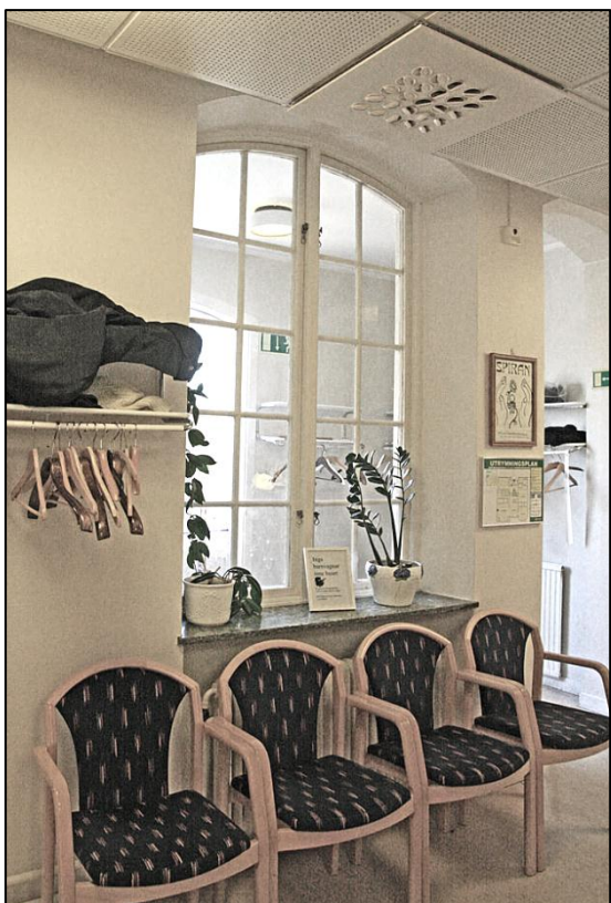
Passage 203 innan ändring. Ursprungligen var utrymmet utanför passagen en öppen balkong och fönstret var alltså ett ytterfönster. Vid en omfattande ombyggnad 1973 ersattes balkongen av ett trapphus. 2011-04-15.
