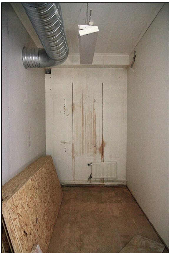
Förråd 214 med hålsågning för ny fönsteröppning i nordfasaden. 2011-06-07.
