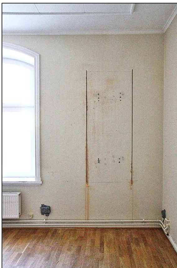
Rum 216 med hålsågning för ny fönsteröppning i nordfasaden. 2011-06-07.
