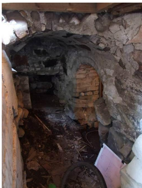
Figur 7. Den nuvarande ingången till källaren i en sekundärt tillbyggd del, här kallar förrummet. Källaringången ses till höger. Rakt fram i bild ses en nisch som möjligen utgör en tidigare trappa ned till källaren. Det är i denna nisch kyrksilvret ska ha gömts undan enligt sägnen. Foto mot V. Anna Ölund, Upplandsmuseet.
