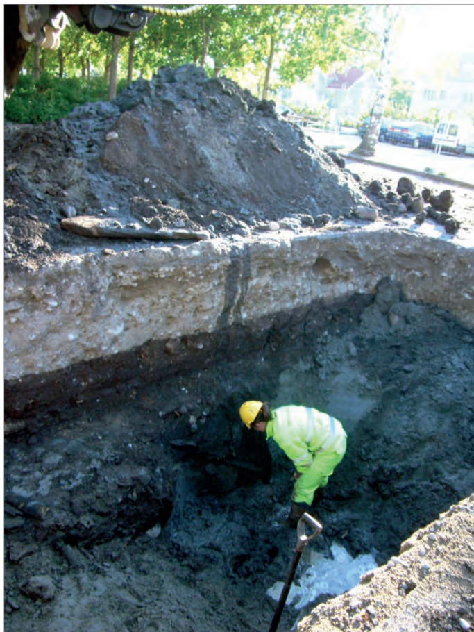
Figur 55. Linda Qviström rensar det som fanns kvar av brunnen 1954 efter djupschaktning. Foto mot Ö Anna Ölund, Upplandsmuseet.
