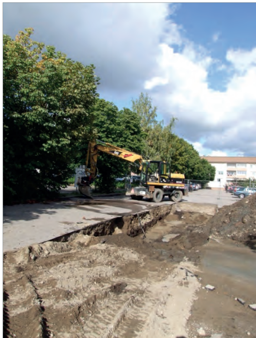
Figur 71. Schakt D på den centrala delen av undersökningsytan. Schaktet grävdes i 1990 års förundersökningsschakt 6. Foto mot N Joakim Kjellberg Upplandsmuseet.
