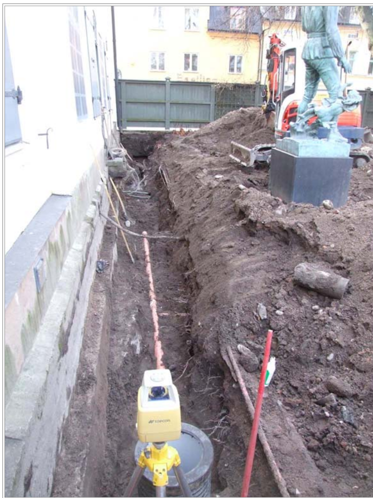
Figur 5. Schakt 1 längsmed Linnémuseets NV långsida. I bakgrunden ses planket mot Svartbäcksgatan. Observera den utstickande syllen under nuvarande Linnémuseet. Foto mot SV, Anna Ölund Upplandsmuseet.
