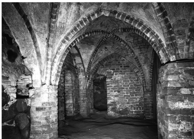
Figur 6. Foto av de medeltida kryssvalven i Värmlandskällaren från den byggnadshistoriska undersökningen 1956 inför restaurangens iordningställande. Fotograf okänd, ur Upplandsmuseets arkiv.
