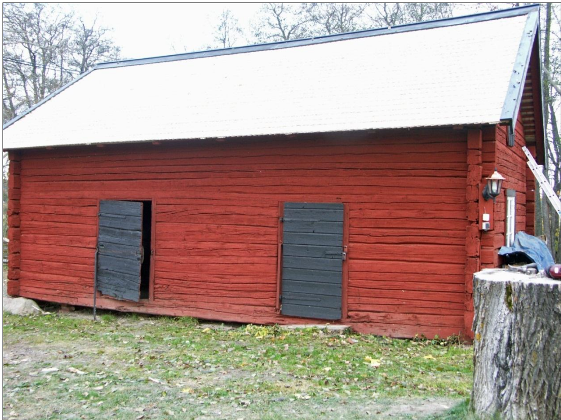
Spannmålmagasinet efter omläggning av stickspântak, montering och tjärstrykning av nya nockbrädor, vindskidor och vattbrädor
