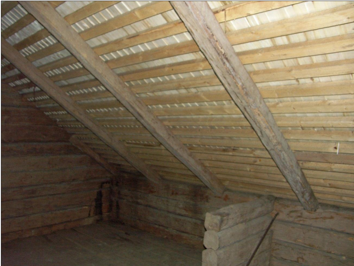
Stickspântaket sett från spannmålsloftet
