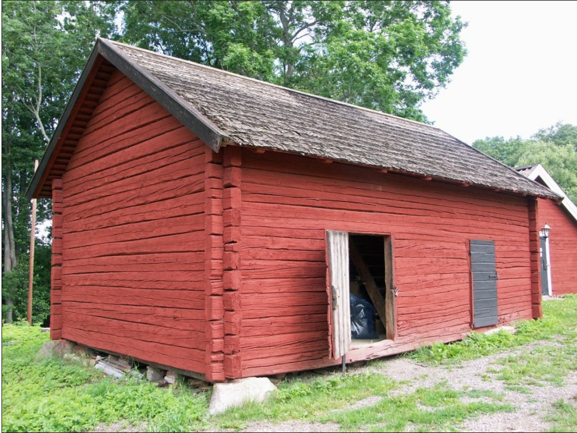
Gaveln mot SV och långsidan mot SO
