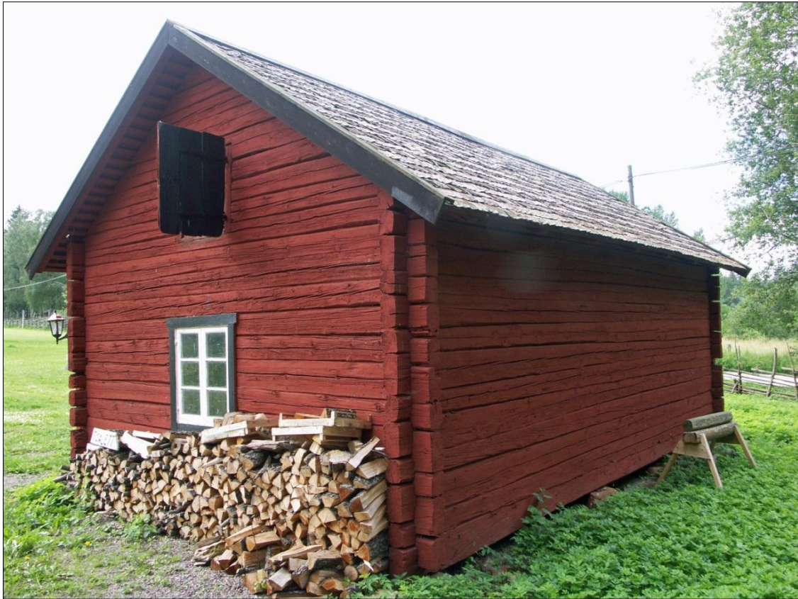
Gaveln mot NO och bakre långsidan mot NV
