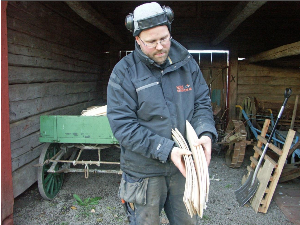
Per Olsson jämför bevarade stickspån tv från takomläggningen 1986 med de nyttillverkade, något tjockare, th
