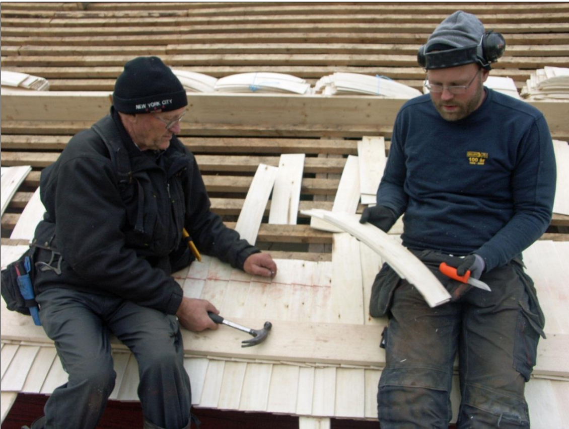
Spikning av stickspån med hjälp av riktbräda
