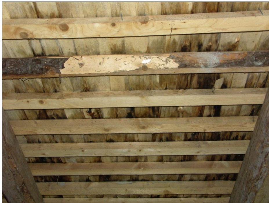
Begränsade fuktskador på stickspån
