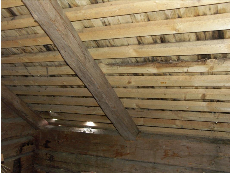
Begränsade fuktskador på stickspån och läkt på takfallet mot SV
