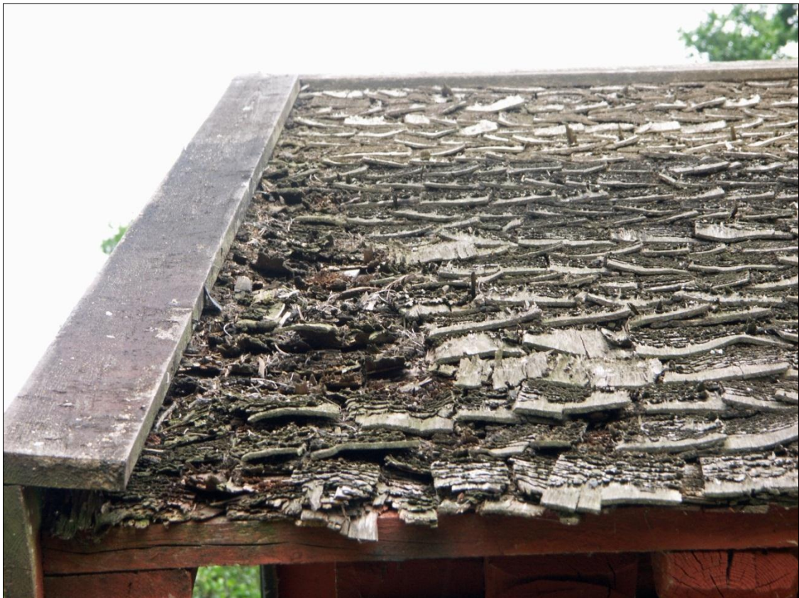
Takfallet vid gaveln mot SV, med rötskadade och spruckna stickspån
