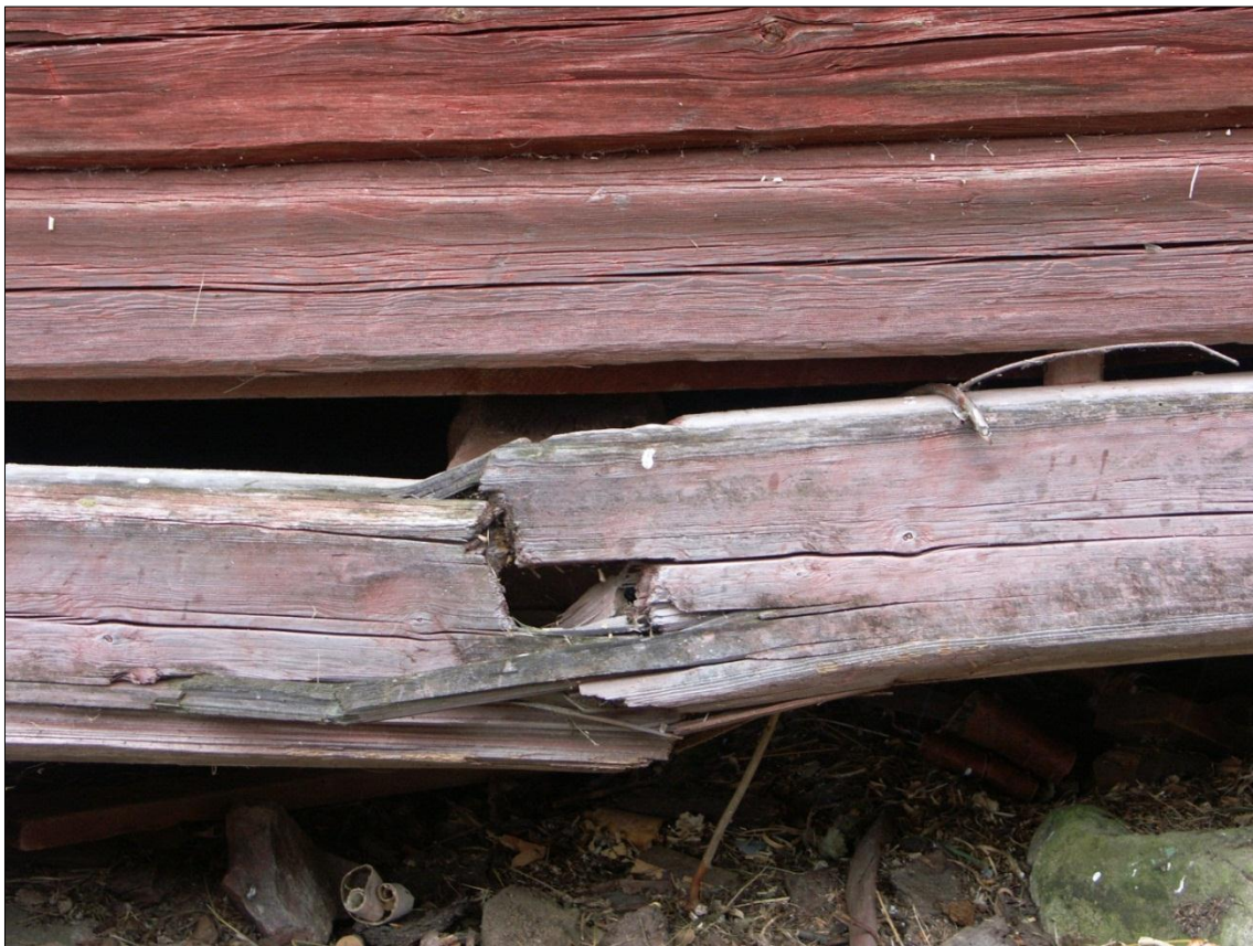
Brott i syllstocken på magasinets gavel mot V, i anslutning för håltagning för golvbjälklag
