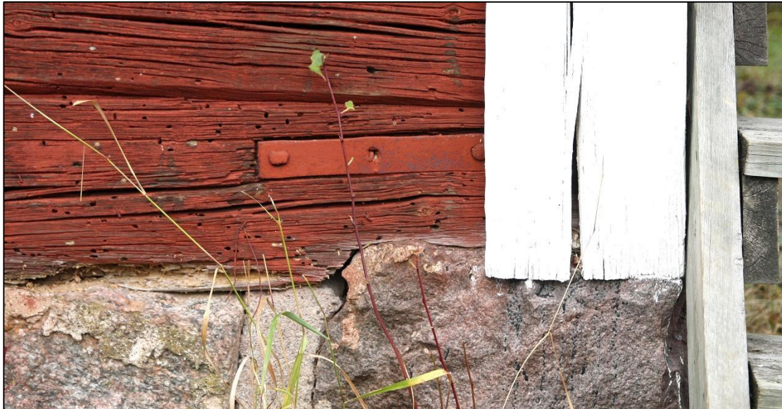
Syll vid sydöstra hörnet med bandjärnsförstärkning.
