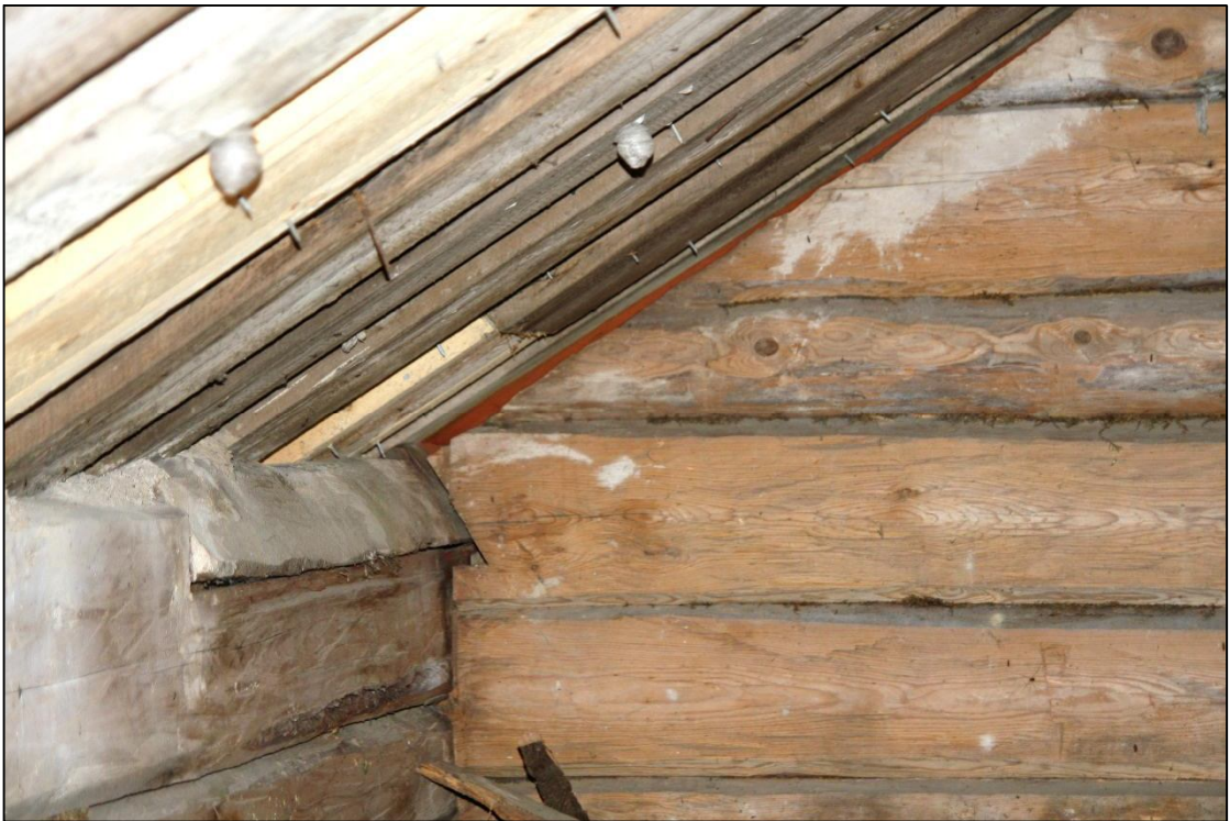
Hammarbandens utstickande, profilerade ändar är iskarvade. Detta gäller samtliga fyra ändar. Iskarvningen är nödvändig för att uppnå det önskade utseendet i takfoten.
