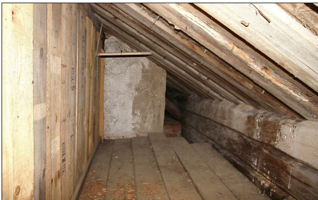
Den norra kattvinden mot väster. Murstocken löper upp mellan sidoåsen och långsidans timmervägg. Avbalkningen är gjord med utskotts- och lådvirke.
