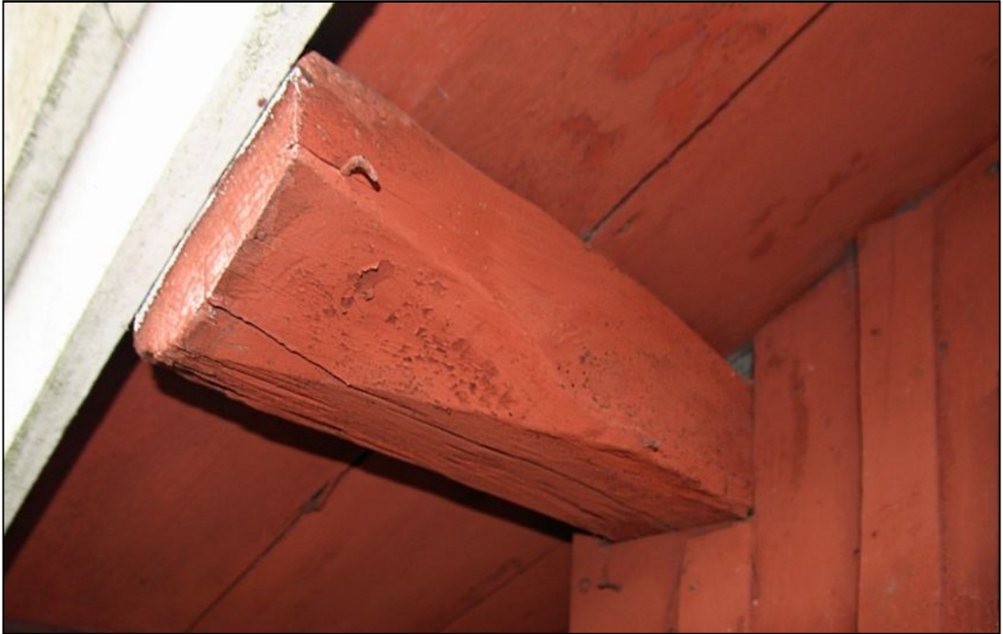
Bilad bjälke till förstugan som utgår från ett urtag i liggtimmerstommen. Bjälken tillhör sannolikt den ursprungliga förstugekonstruktionen.
