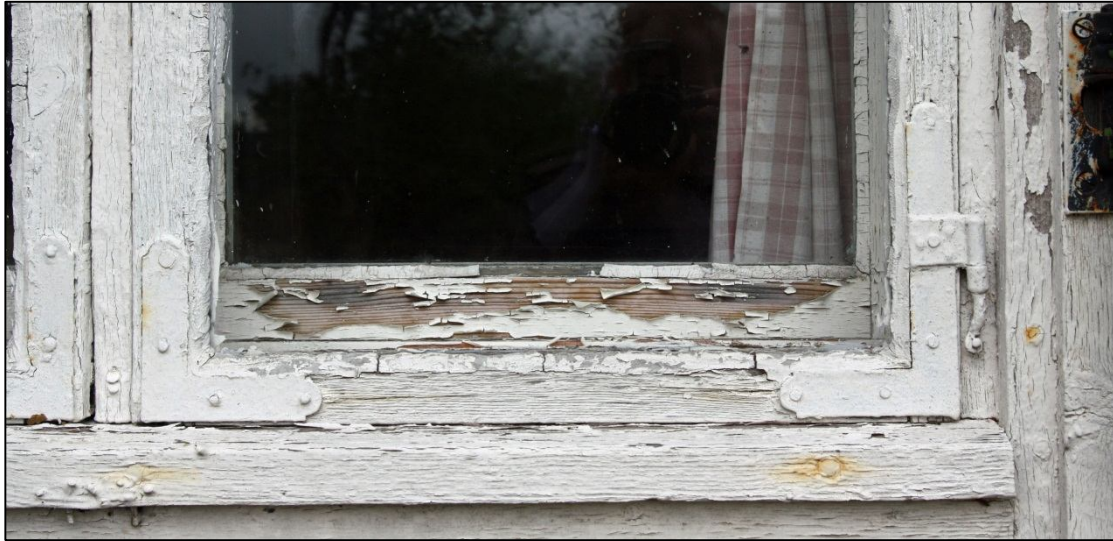
Hörnjärn och gångjärn på bottenvåningens fönster, fasad A. Järnen är av en typ som började tillverkas under senare hälften av 1800-talet och som sedan var populära fram till omkring 1900.
