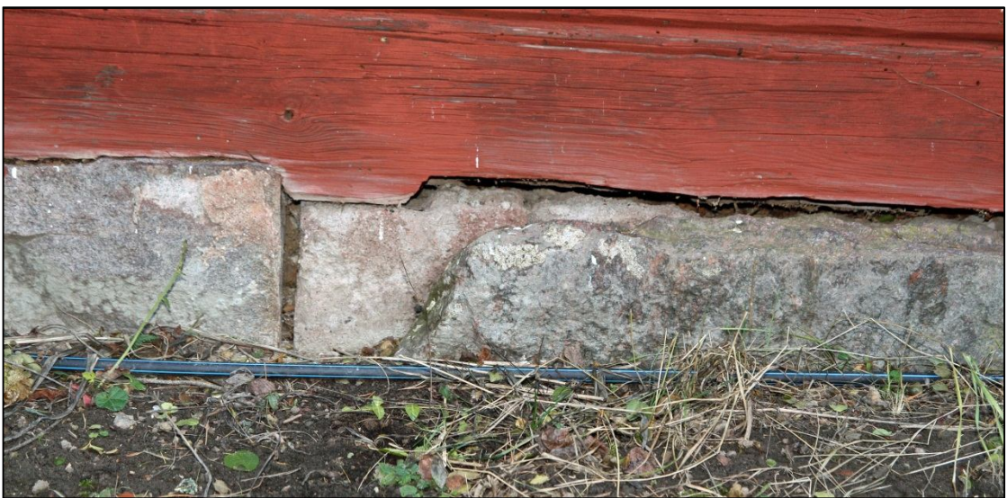
Grundsockel på byggnadens västra fasad. Syllen har lagts genom "iplankning". Detta sätt att laga timmerstommen anges i den ekonomiska besiktningen 1952.
