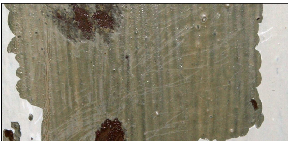
Ådringslasering på dörrbladet mellan förstugan och köket. Färgintrycket motsvarar en blandning av grön umbra och guldockra, närmast motsvarande 3B-94+786 i linoljefärgslikare 2003. Bottenfärgen motsvarar ungefär 5B-94+786.
