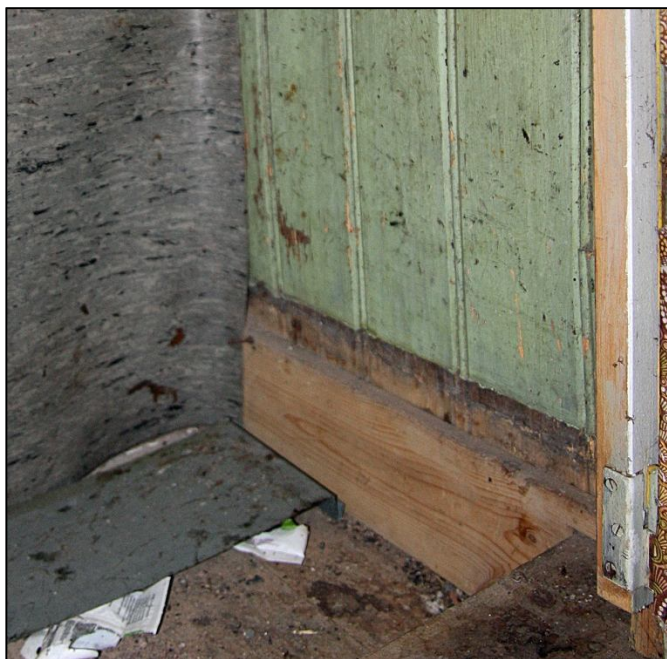
Pärlspontpanel i hörnet mellan spismuren och långvägg C. Den ljusa gröna färgen utgör här panelens enda färglager. Färgen upphör 17 cm ovanför golvytan.
