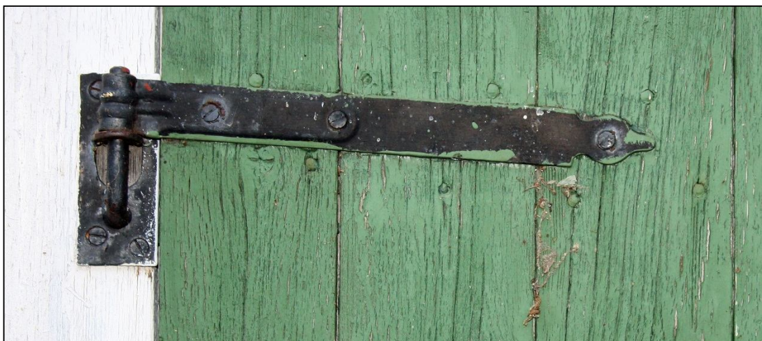
Pressat bandgångjärn till fönsterlucka.
