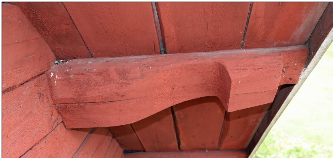
Profilerad ände på det norra takfallets sidoås. Denna typ av profilering, som uppträder i kombination med stora taksprång, uppträder först med den s.k. schweitzerstilen och blir populär i enklare byggnader under senare delen av 1800-talet.
