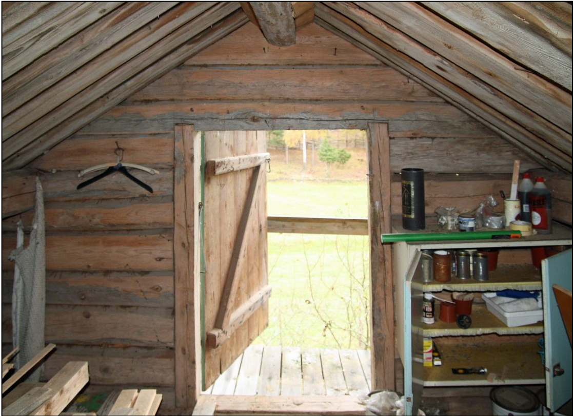
Gavelvägg åt öster inifrån vinden.
