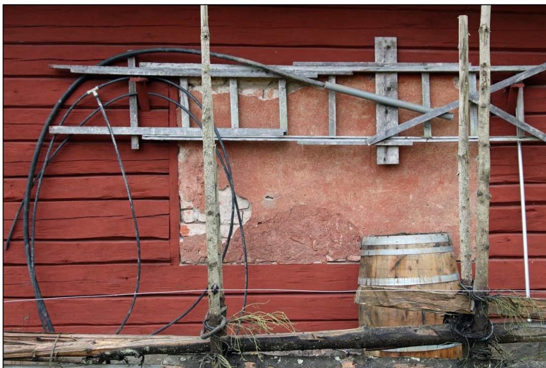
Spismurens baksida med rödfärgad puts på en murning med rött tegel och lerbruk.
