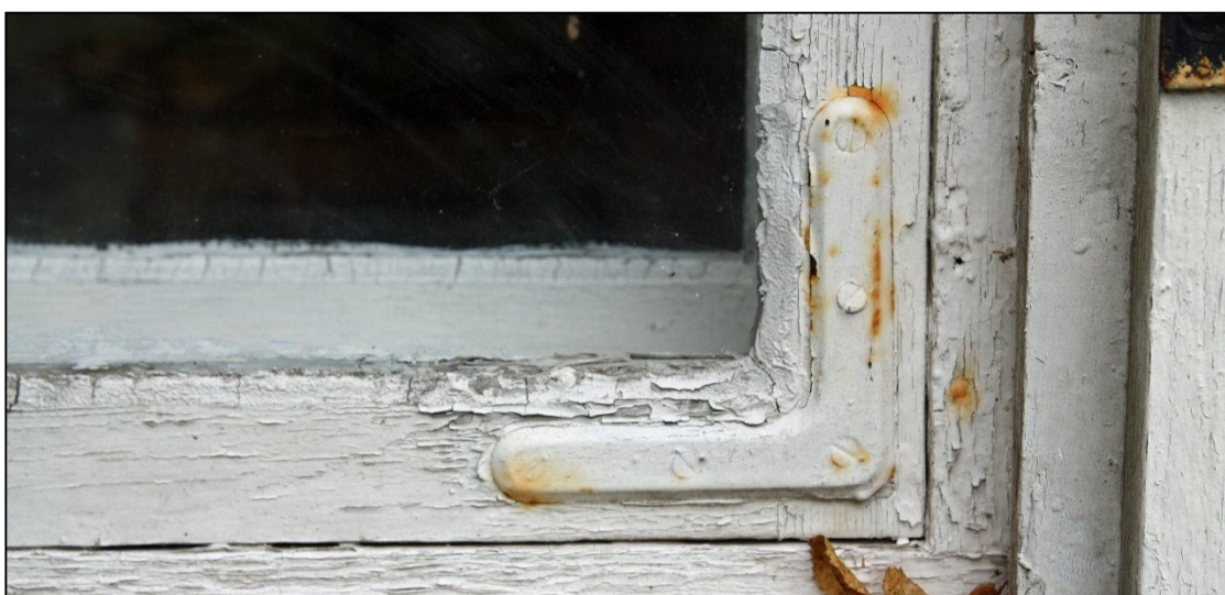
Pressat hörnjärn av en typ som var vanlig under första hälften av 1900-talet. Hörnjärnen är under den vita färgen målade med en ljus kromoxidgrön färg.
