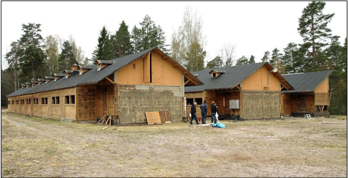
2012-05-03. De tre stallängorna under restaurering.
