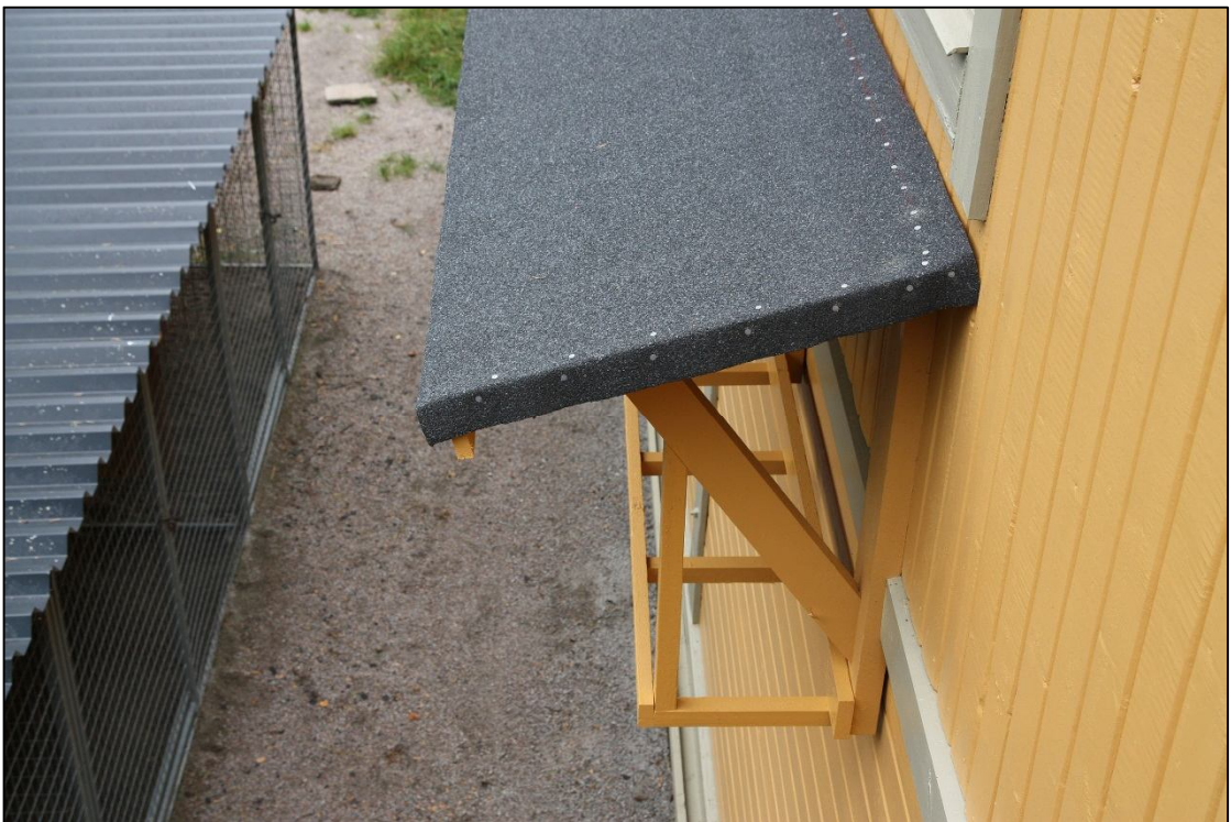
2012-08-21. Nyttillverkat skärmtaket till ställningen på västra stallängan.
