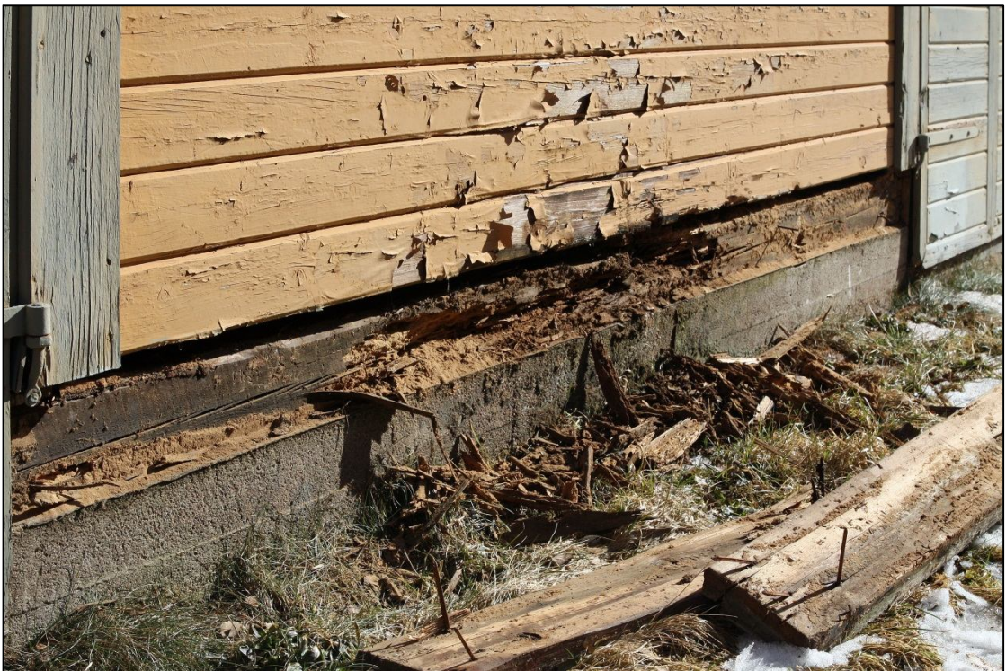
2012-04-04. Rötskador i syll.
