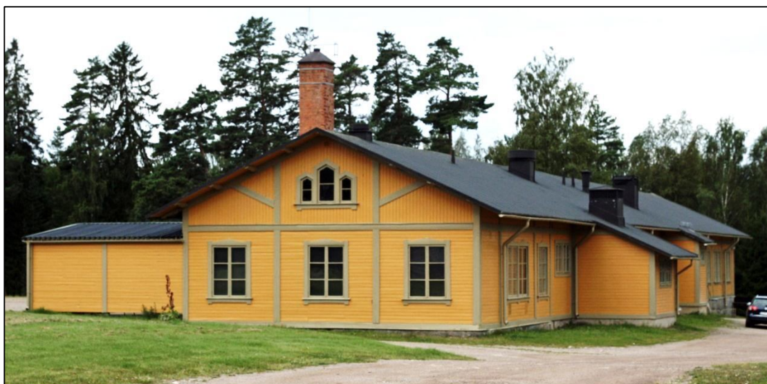
2012-08-21. Byggnaden efter restaurering
