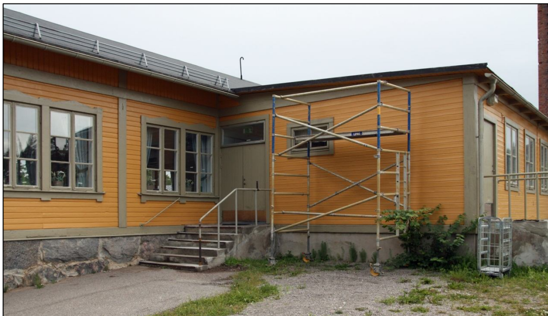
2012-06-27. Byggnaden under restaurering.
