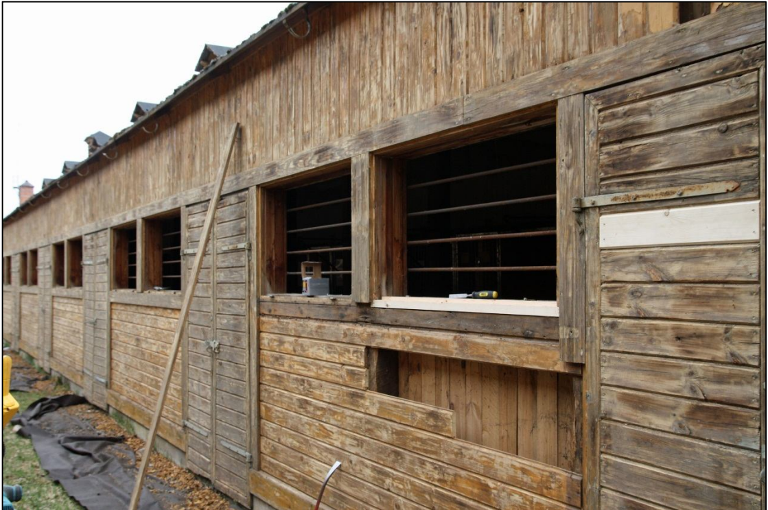
2012-05-03. Fasad med ilagningar av karmbottenstycke på fönster och panel på dörrblad.
