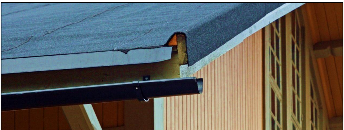
2012-08-20. Takpappens anslutning till vindskivorna efter omläggning, med trakanstlist och nedvik som täcker den övre vindskivan.
