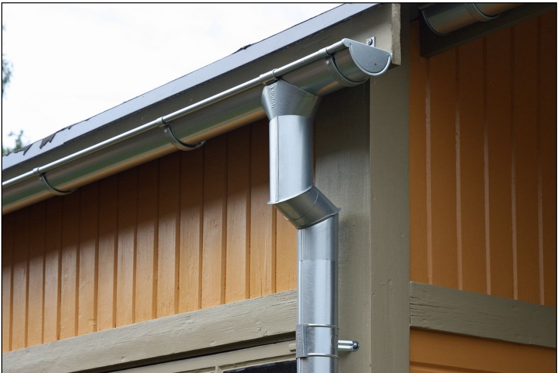
2012-06-27. Galvaniserat stuprör med falsade krokar. Hängränns krokar är skruvade mot en ny takfotsbräda.
