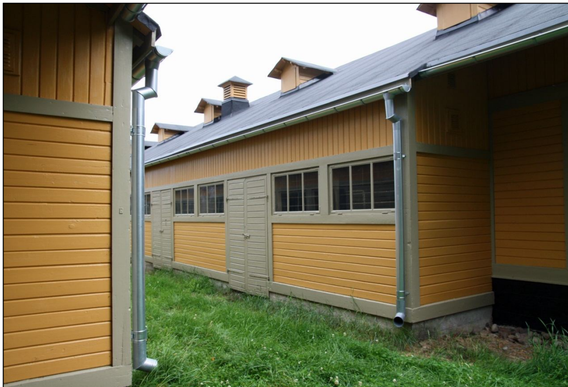
2012-08-21. Östra stallängans västra fasad efter restaurering.
