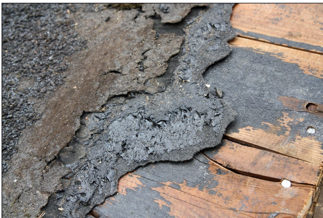
2012-06-27. Befintliga papplager på östra stallängans östra takfall.
