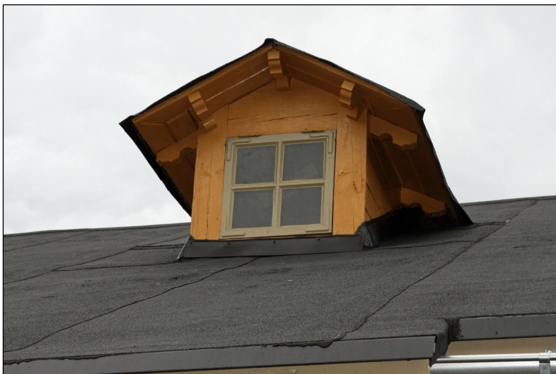
2012-08-21. Takkupa på östra stallängen efter restaurering.
