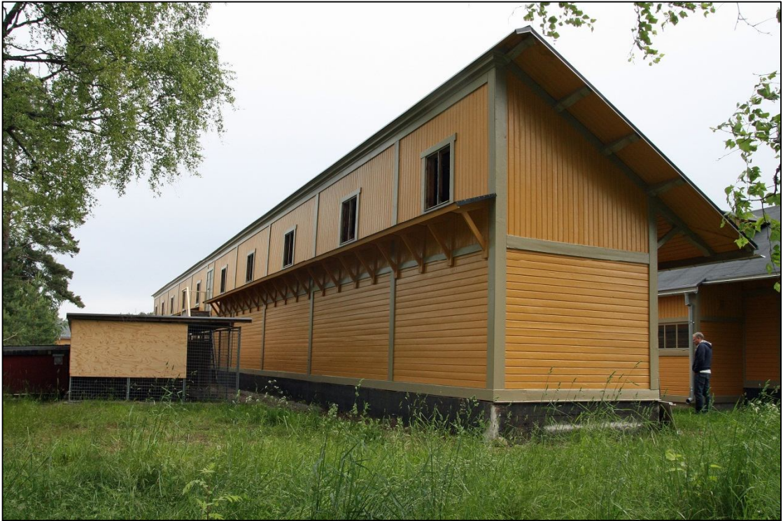
2012-06-27. Västra stallängan med nytillverkad ställning för skidor.
