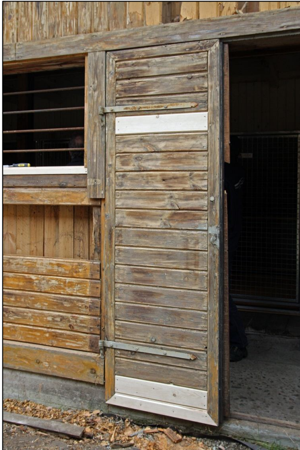
2012-05-03. Lagnig av dörrblad efter färgborttagning.
