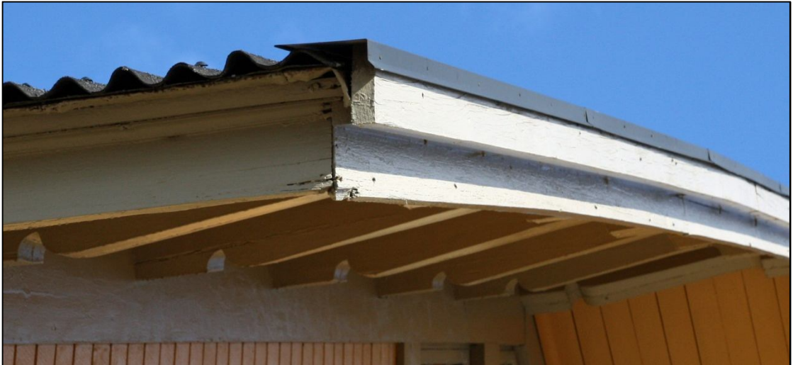
2012-04-04. Utförande av vindskivor och täckbleck innan omläggning.
