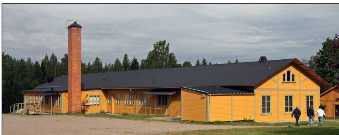
2012-08-21. Byggnaden efter restaurering
