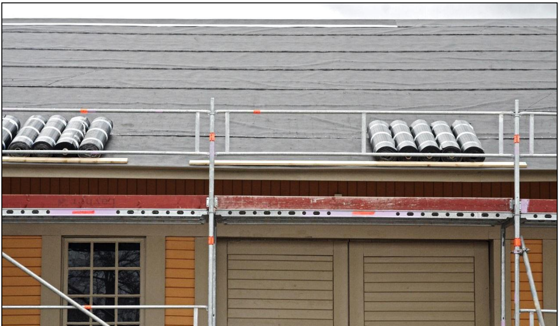
2012-05-03. Ondulintaket har rivits och en ny underlagspapp har lagts på underbrädningen. Rullar med den nya takpappen ligger på takfallet.
