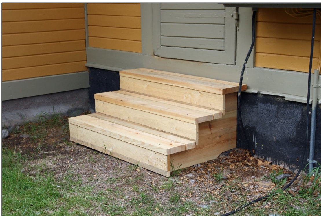
2012-06-27. Nyttillverkad trappa till mellersta längan, med den gamla som förebild.
