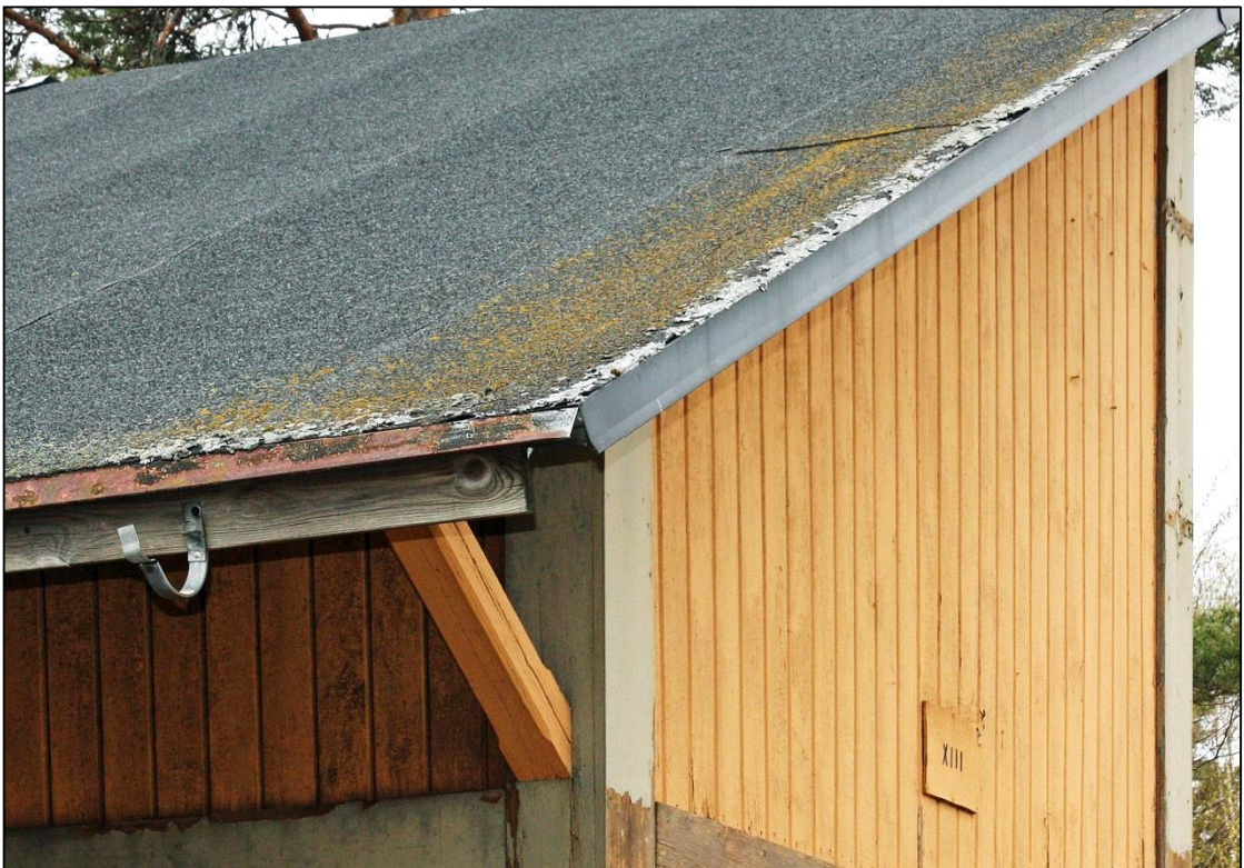
2012-05-03. Takfot på västra stallängans östra sida med tryckimpregnerad takfotsbräda.
