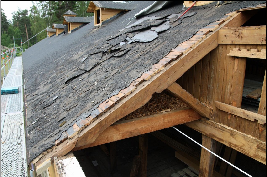
2012-06-27. Friläggning av takkonstruktionen på östra stallängans östra takfall. Utförandet med profilerad sparre, som är gjord för att synas, visar att den yttre delen av byggnaden ursprungligen saknade väggar och det nedre takfallet fungerade som ett skärmtak. Vid inklädningen verkar det som om man förlängde takfoten något.
