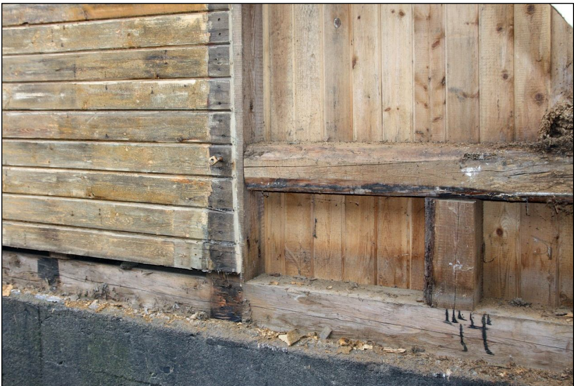
2012-05-03. Frilagd syll och stomme på västra stallängans västra fasad.
