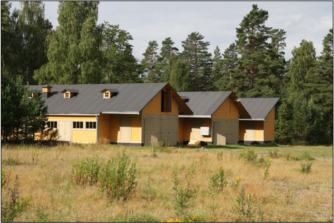
2012-08-21. Stallängorna efter restaurering.
