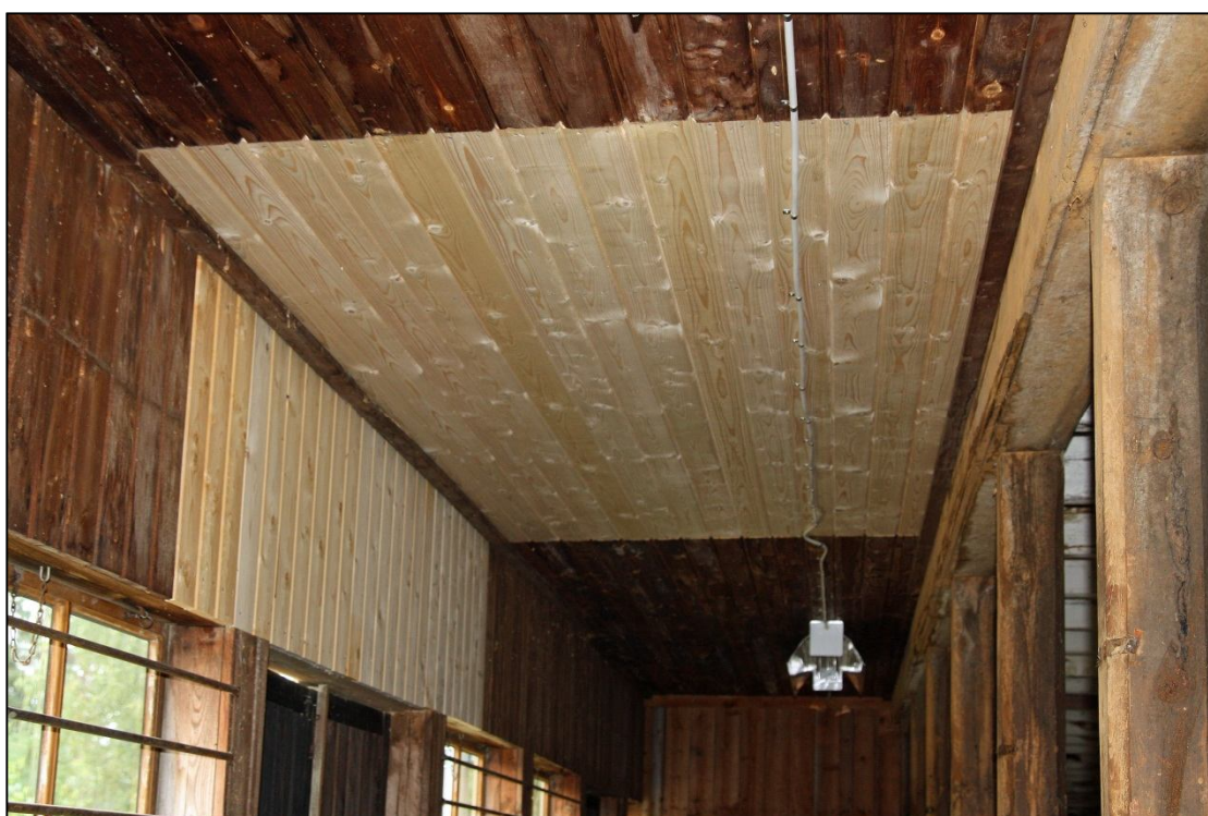
2012-08-21. Lagningar i panel, östra stallängen.
