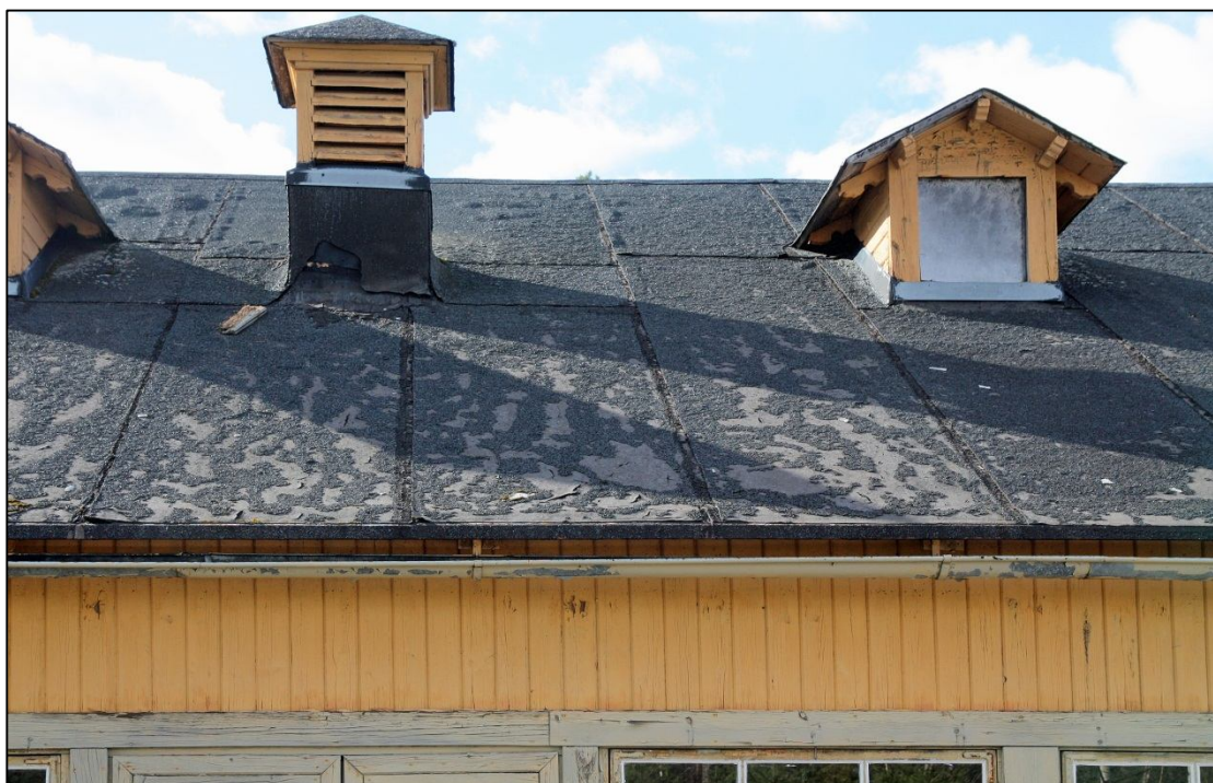
2012-04-04. Takfallet på den östra stallängan innan restaurering. Takpappen är kraftigt urlakad och vittrad och skyddsbeläggningen har till stora delar försvunnit.
