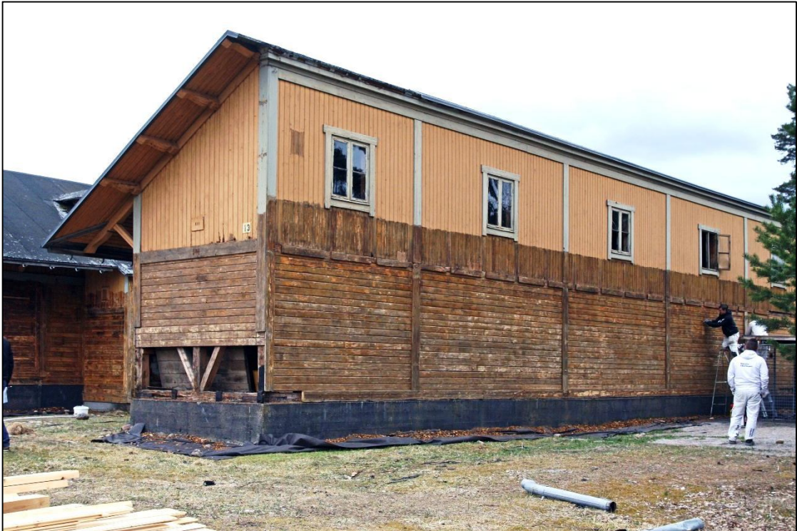
2012-05-03. Västra stallängans västra fasad. Ställningen för skidor har rivits och panelens färglager har tagits bort upp till fönsterbröstningen.
