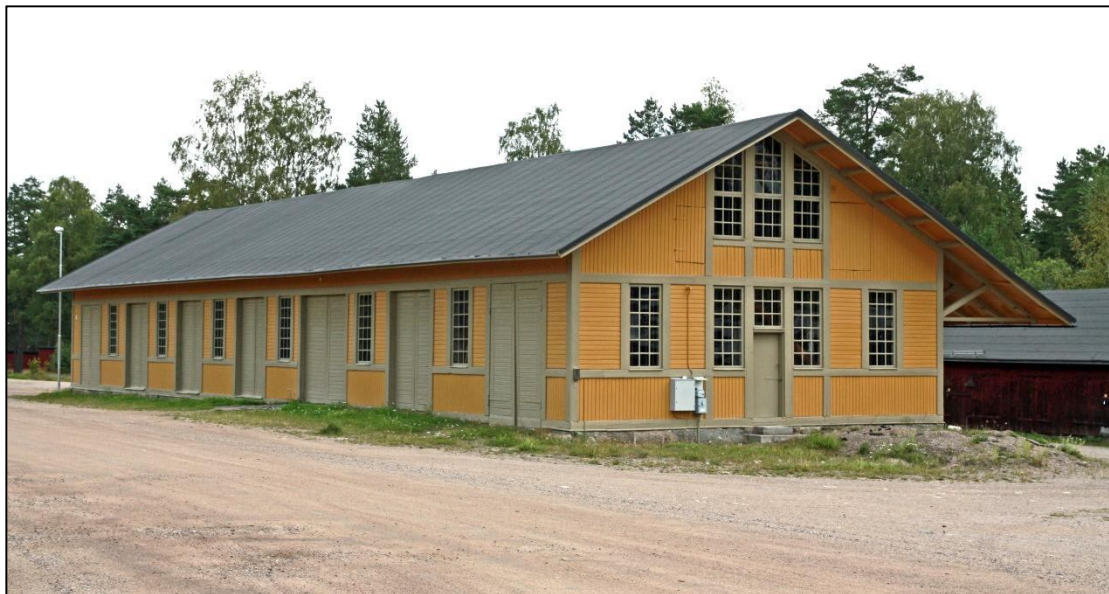
2012-08-20. Byggnaden efter omläggning av yttertak
