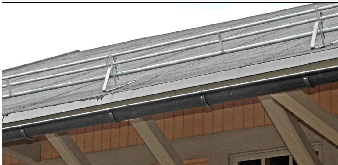
2012-08-20. Utförande av snörasskydd och takfotsbleck.
