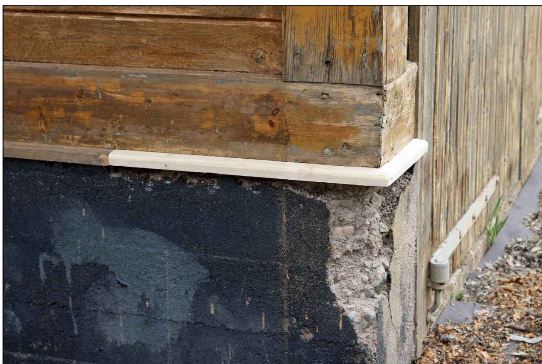
2012-05-03. Ilagning av vattlist.
