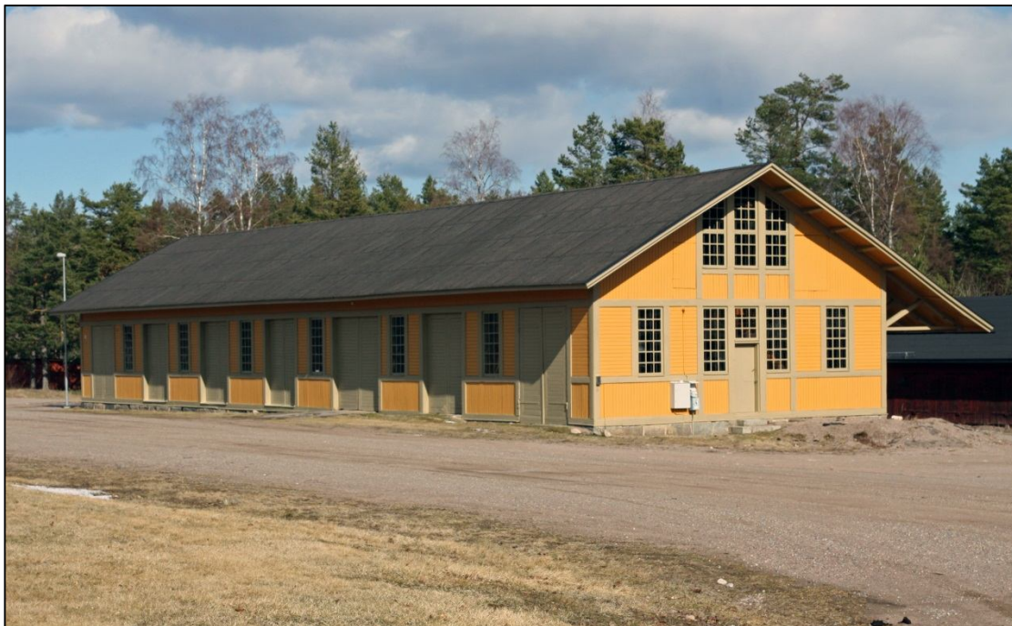
2012-04-04. Byggnaden innan rivning av Ondulintaket.
