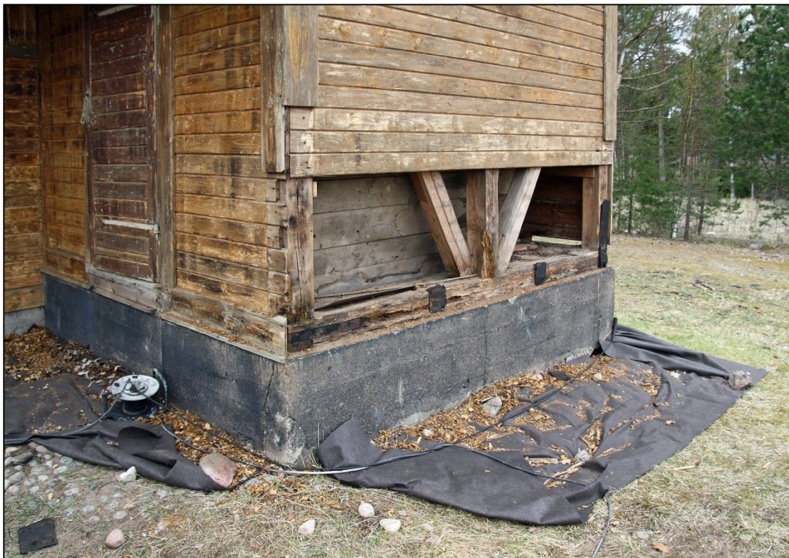
2012-05-03. Frilagt parti på västra stallängans norra gavel. Grunden består av formgjuten cement struken med kallasfalt eller liknande.
