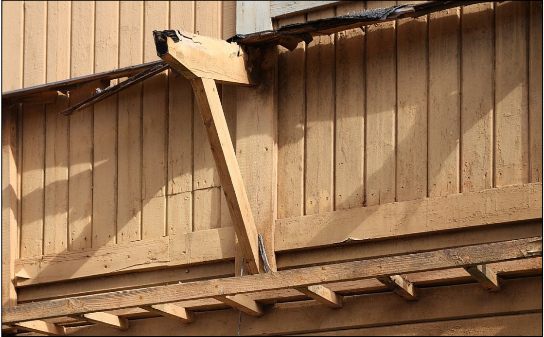
2012-04-04. Det västra stallskjulets västra fasad innan restaurering. Ställning för skidor med skadat skärmtak.
