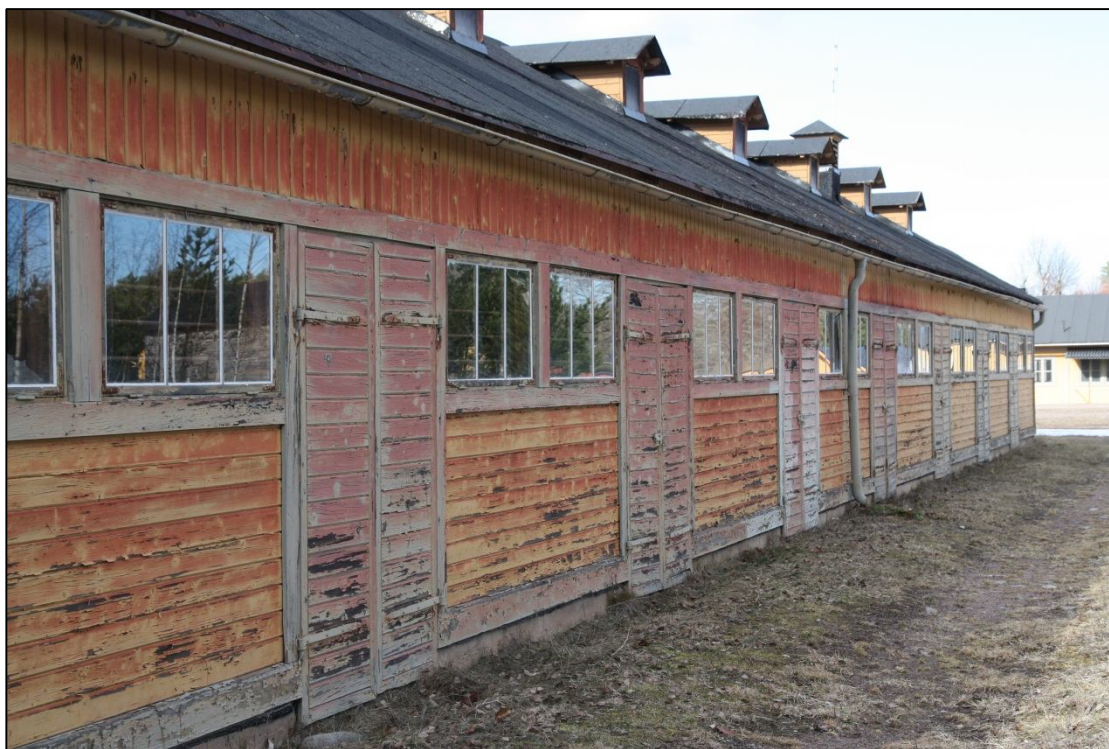
2012-04-04. Östra stallängan innan restaurering. Flera av byggnadernas bottenvåningar är rosa med grå listverk. Den rosa färgen har troligen uppstått genom användning av en alkydfärg med icke ljusäkta pigment. När man skrapar försiktigt på ytan så kommer den ursprungliga ockra nyansen fram under den rosa.
