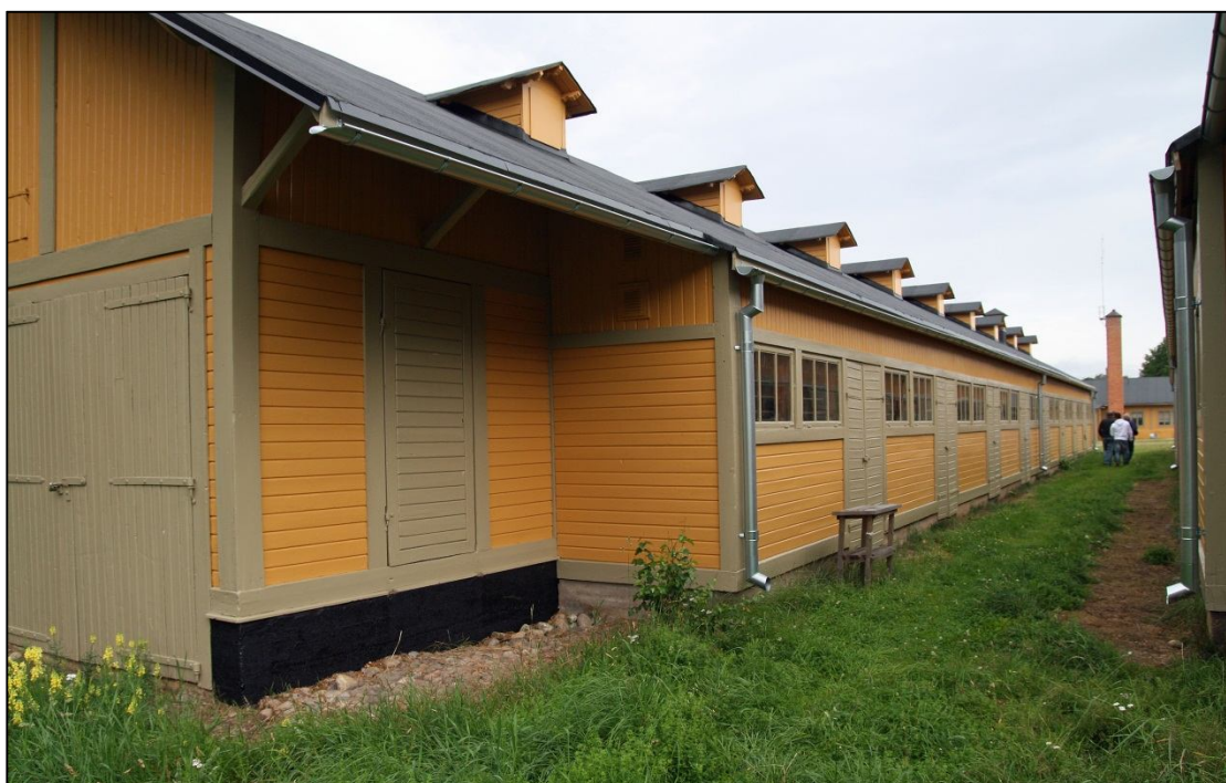
2012-08-21. Mellersta stallängan efter restaurering.
