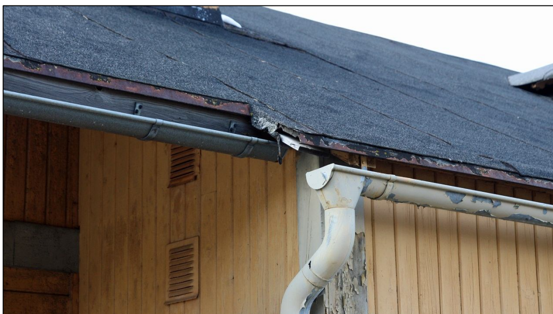
2012-04-04. Takfot på mellersta stallängan innan restaurering. Fotblecket är rostigt. Hängrännan till vänster i bild är upphängd på krokar som är fästade på en tryckimpregnerad takfotsbräda. Hängrännan till höger i bild är spikad i sparrändarna.
