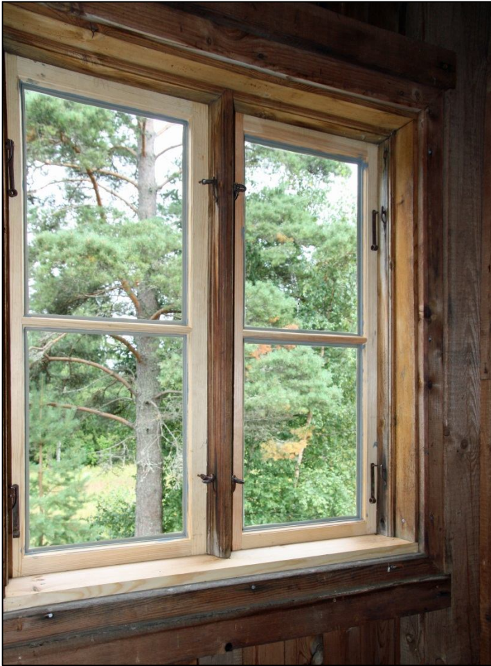
2012-08-21. Fönster i västra stallängan med nya bågar och nytt karmbottenstycke.
