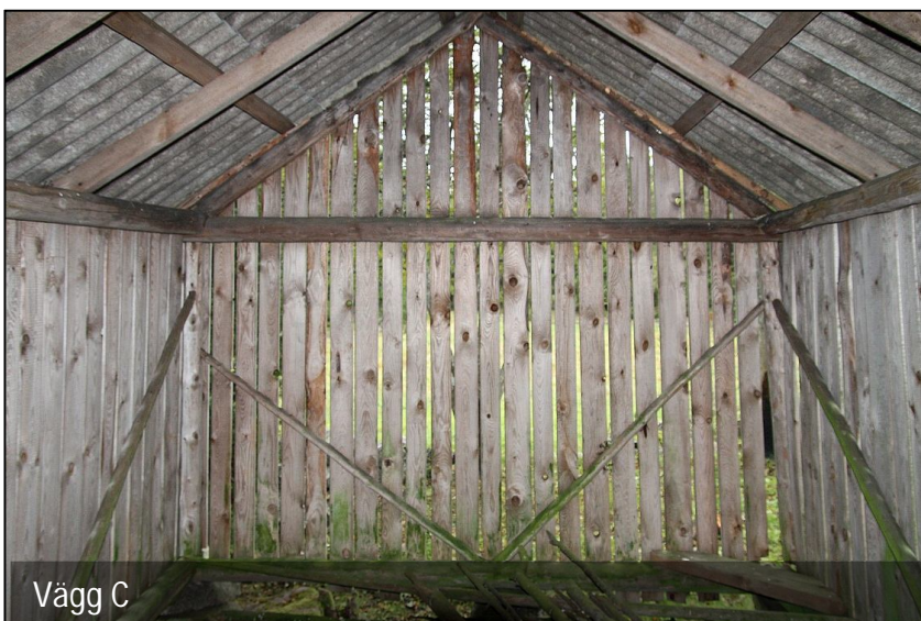
Taklag med sparrförstärkningar i nock
