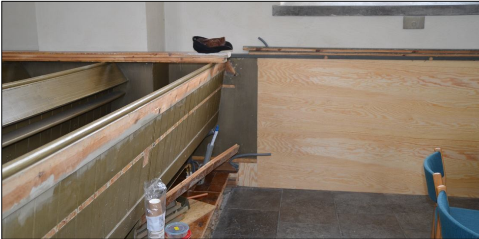
2013-02-27. Det nya kalkstensgolvet har rengjorts. Mot väggen har nya plywoodskivor satts upp istället för de gamla.
