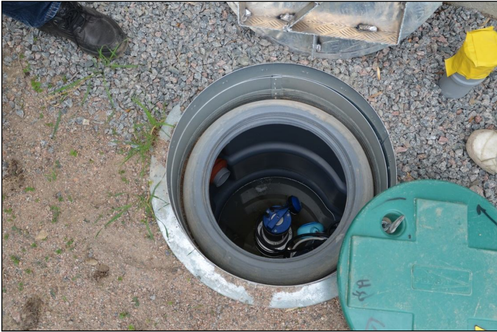
2013-05-21. Pumpgrop för avlopp och vattentillförsel avsett för södra korsarmens pentry.
