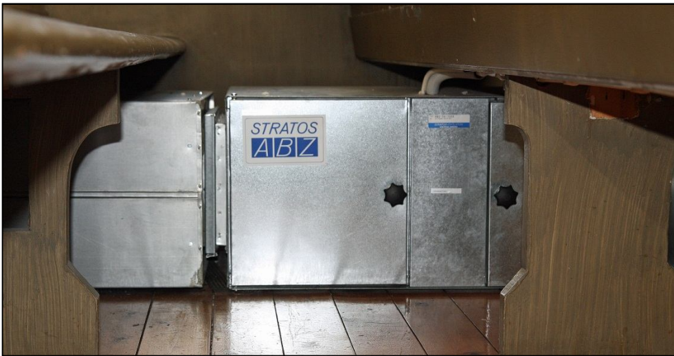
2012-09-07. Varmluftssystemet drevs av stora värmefläkttaggregat (till höger i bild) som var kopplade till ljuddämpare (till vänster i bild).
