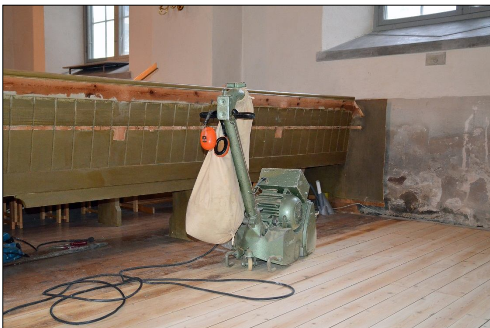
2013-01-30. Slipning av befintligt trägolv i norra korsarmens nordvästra del efter demontering av bänkar.
