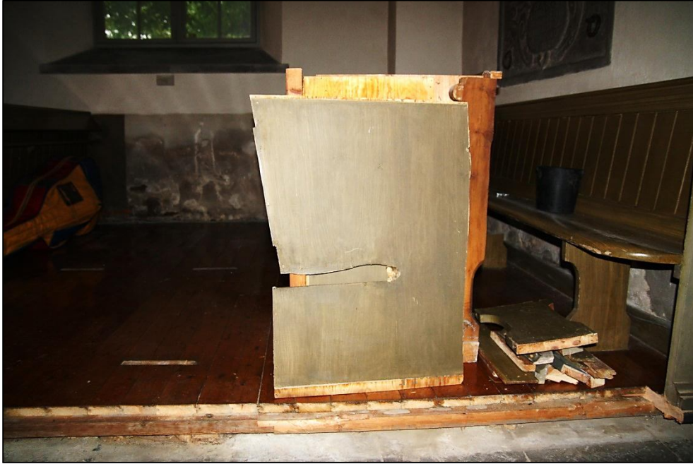
2012-09-26. Plywooden mot väggen var figursågad för att passa med bänksitsens profil. Plywooden fick sågas upp för att det skulle vara möjligt att demontera den.
