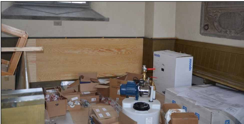
2013-02-27. Ny plywoodskiva mot korsarmens östra vägg.
