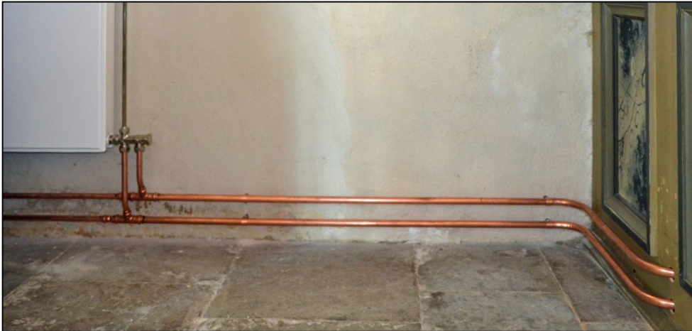
2013-04-10. Dragning av kopparrör från södra bänkkvarteret till korets radiator.
