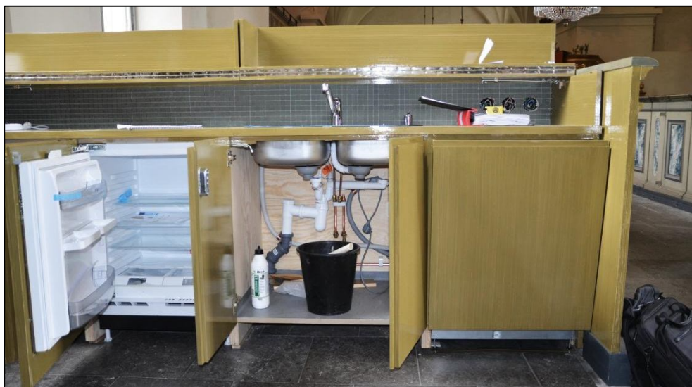
2013-05-21. Inredning i västra delen av korsar efter målning och med monterad diskbänk och kylskåp.
