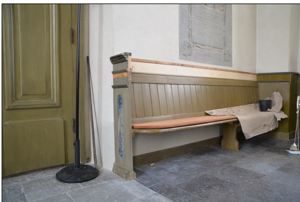
2013-03-20. Södra korsarmens sydvästra del med ombyggd bänk.
