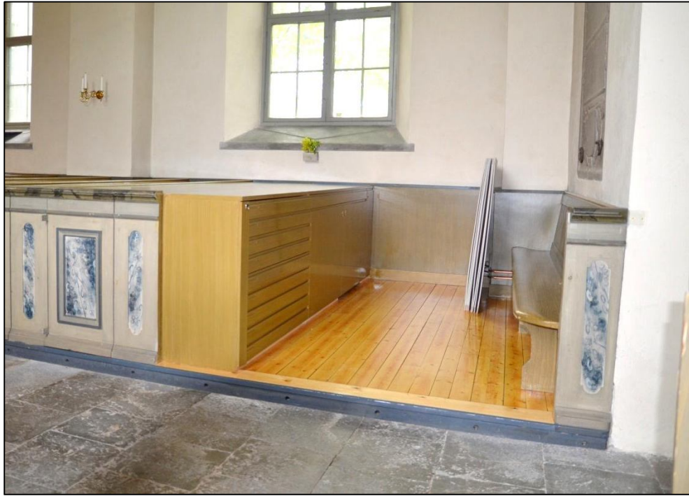
2013-05-21. Den norra korsarmens nordvästra del efter montering av textilskåp och färdig målningensbehandling.
