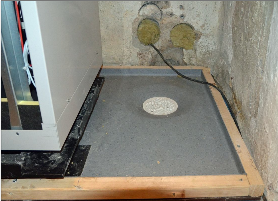
2013-02-27. Håltagningar i den norra väggen i teknikrummet.
