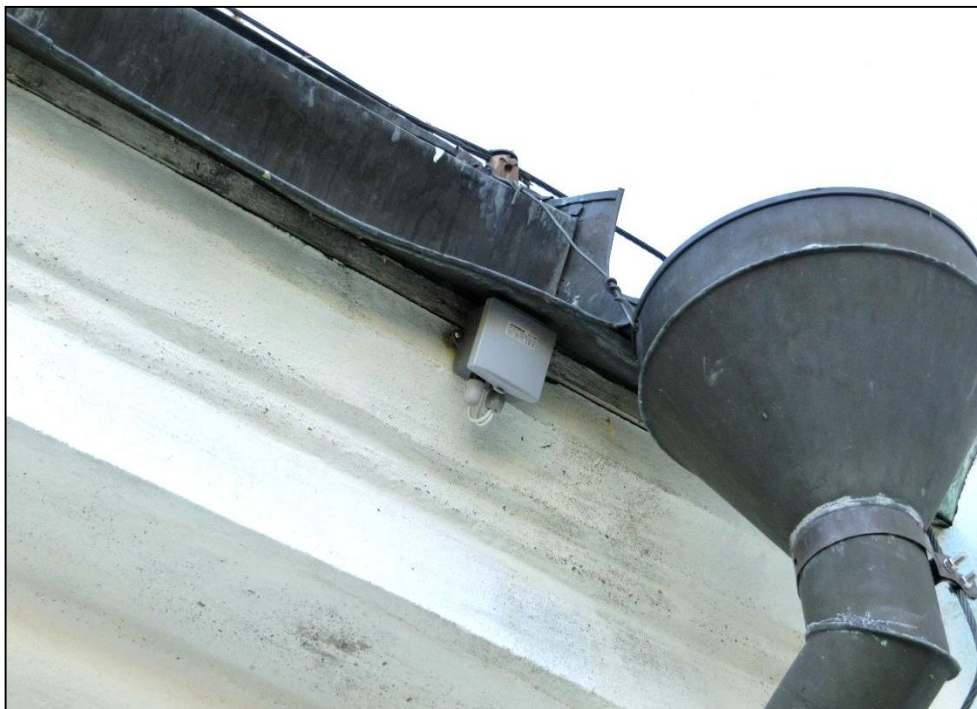
2013-10-25. Utomhusgivaren för temperatur.
