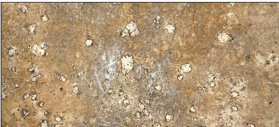
2012-09-26. Kalkbruksavjämningen med isolerande ytskikt av stenkolsstjära eller liknande. Ytan har spruckna blåsor.
