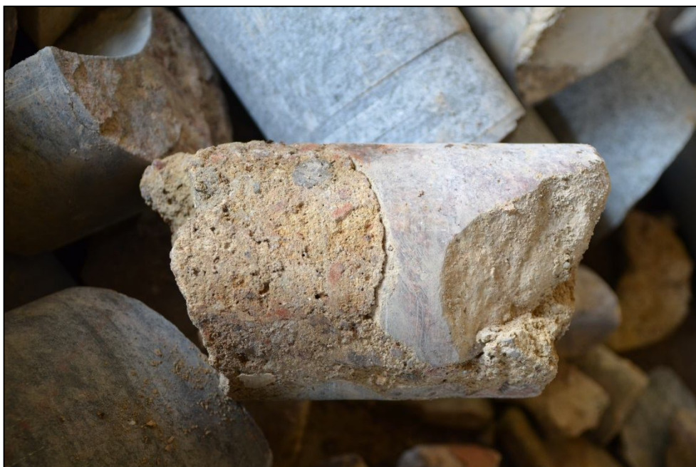
2013-02-27. Borrkärna från sakristians mur. Skalmurens fyllning består av ett hårt, beige bruk med tegelkross och grus.
