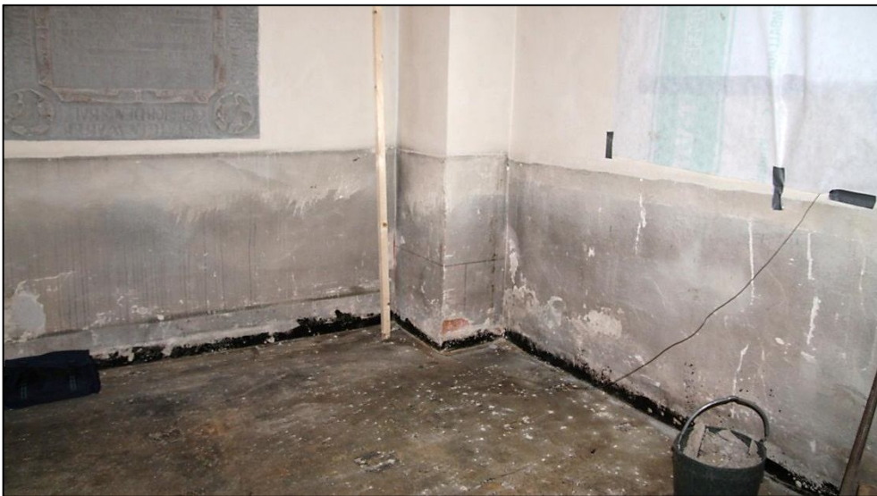
2012-09-26. Södra korsarmens sydvästra hörn efter borttagning av bänkar och träbjälklag.
