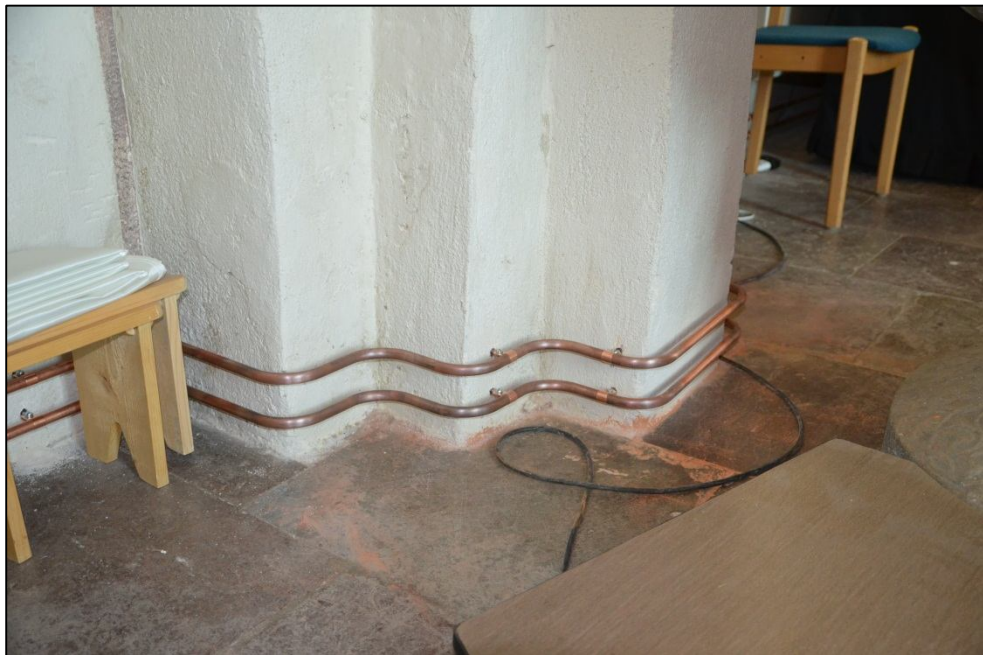
2013-04-10. Dragning av kopparrör i koret.
