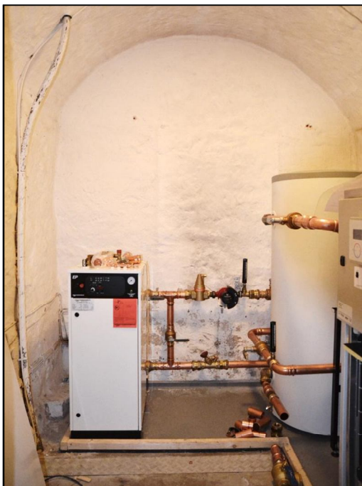
2013-03-20. Teknikrummets västra vägg med elpanna och ackumulator på det upphöjda, vattensäkra golvpartiet.
