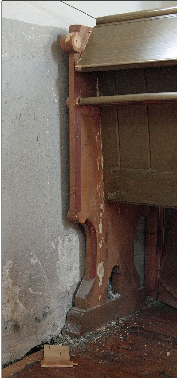
Bänk i södra korsarmen med borttagen plywoodskiva. Gaveln är från restaureringen 1898 -99.
