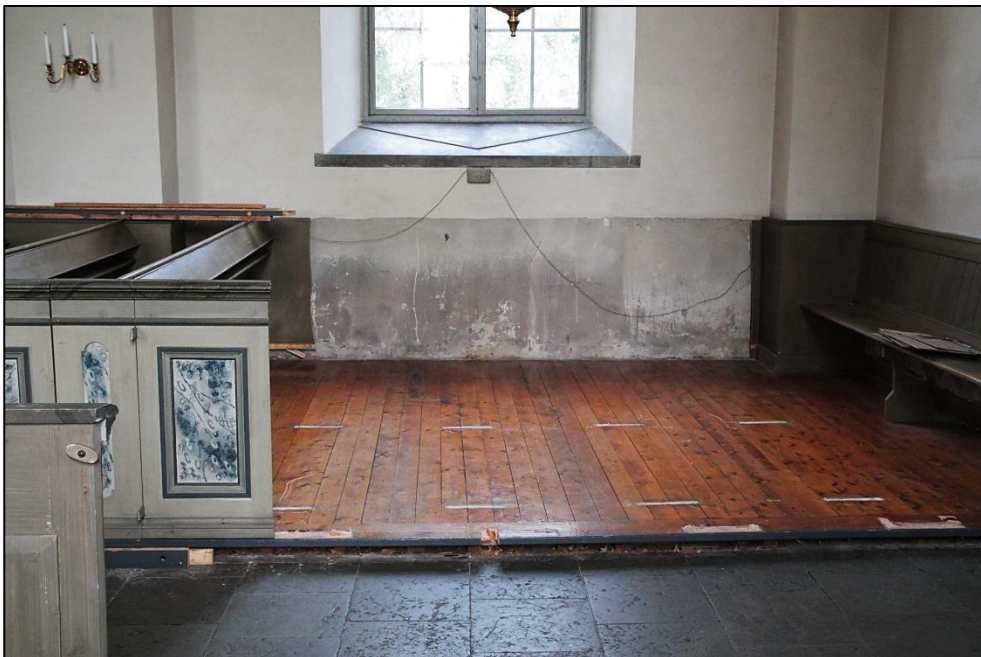
2012-09-11. Södra korsarmens östra del med borttagna bänkar och plywoodskiva mot östra väggen.
