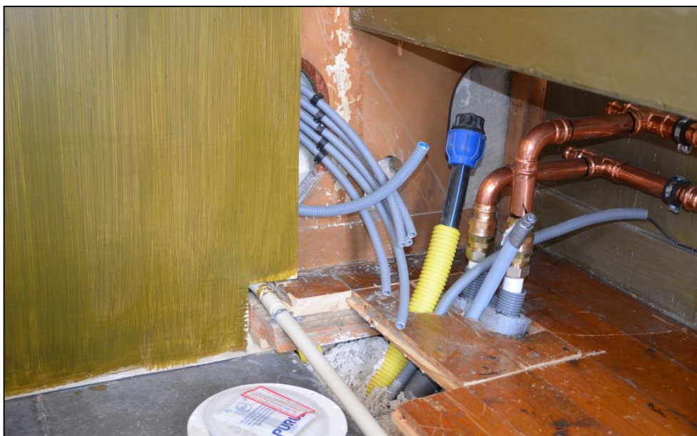
2013-03-20. Anslutning av rör för bänkvärmare m.m.
