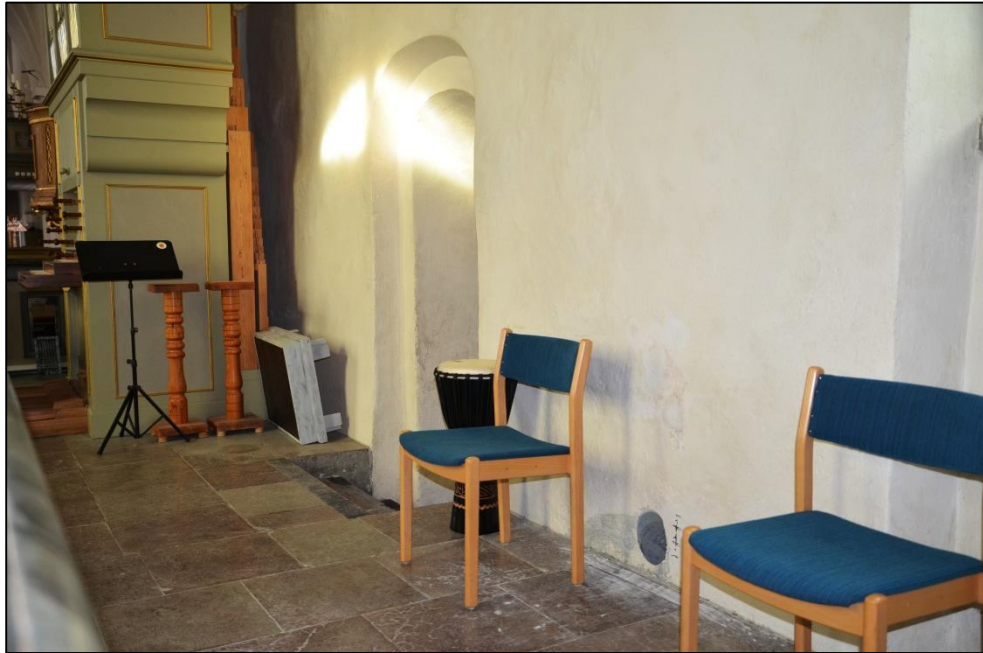
2013-02-27. Korets vägg mot sakristian med håltagning för värmerör från sakristian till koret.
