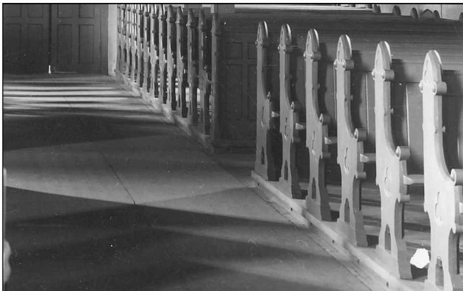
Bild från 1932 som visar bänkkvarterens utseende efter 1898 års restaurering. Observera det luftade bjälklaget i bänkkvarteren. Bilden är beskuren.
