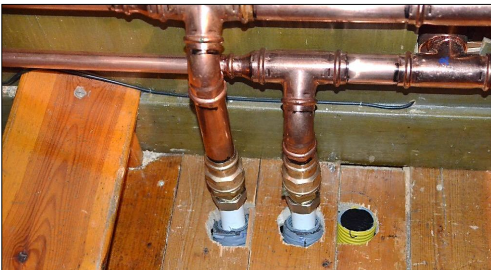
2013-05-21. Anslutning av kopparrör till slangar som löper under golvet.
