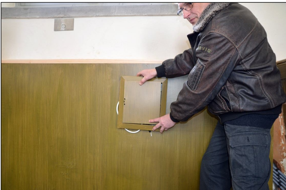
2013-03-20. Målningsbehandlad ny plywood. I kaféutrymmets västar vägg fälldes ett elskåp in mellan plywoodskivan och den putsade tegelväggen. Bo Eklund, Alunda församling, demonstrerar utseendet med lock för installationen.
