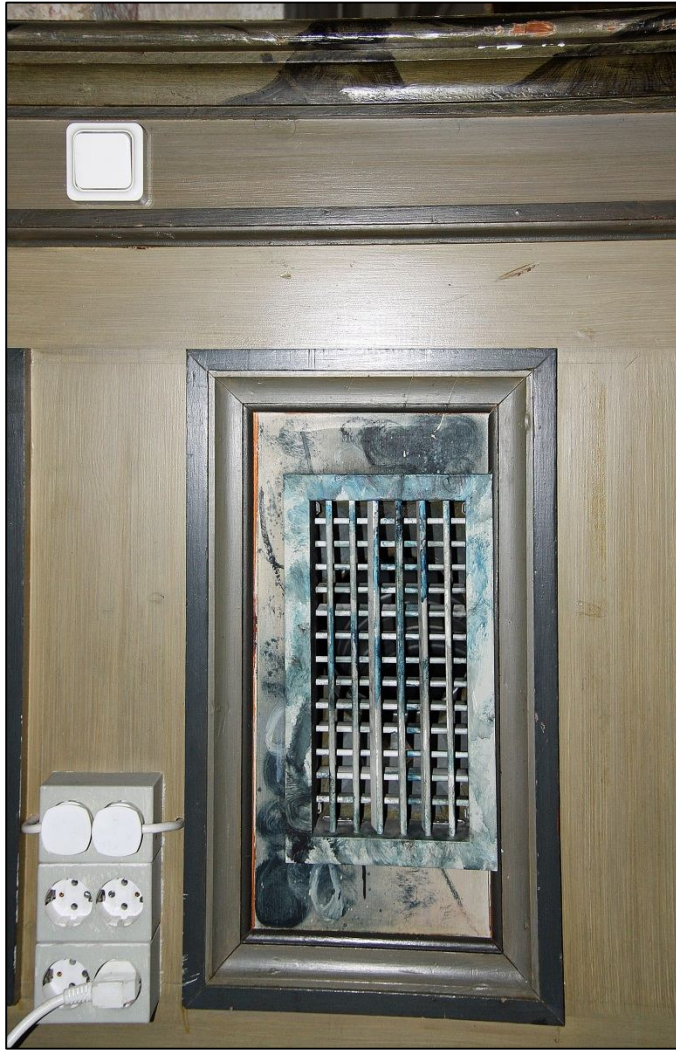
2010-12-03. Galler för utsläpp av varmluft mot koret.
