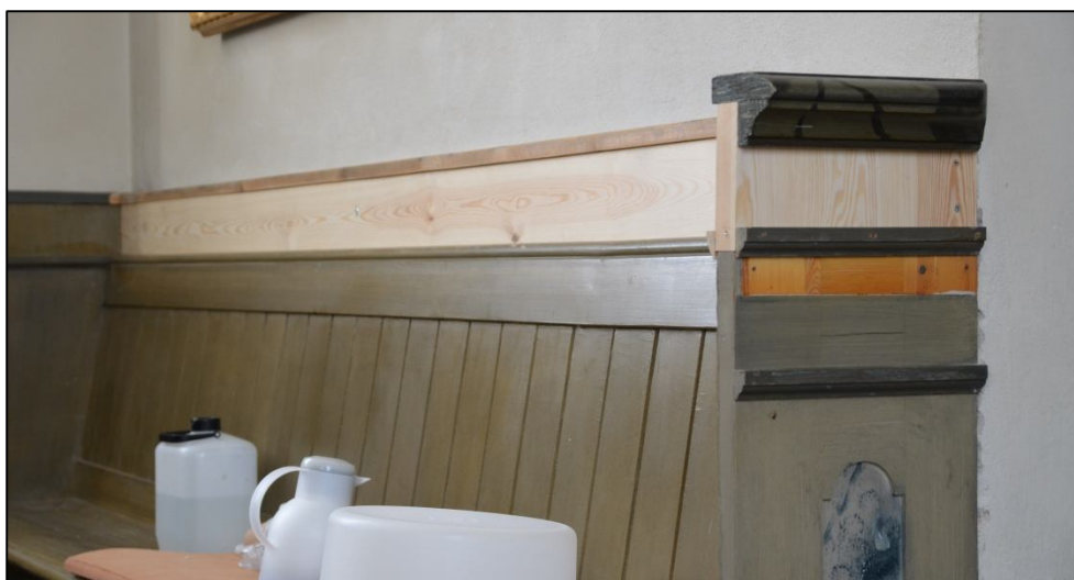
2013-03-20. Höjning av bänkarna genom infogning av en bräda ovanför ryggens avslut.
