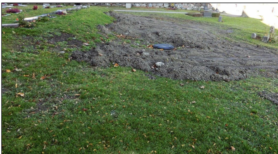
2013-10-25. Borrhål för bergvärme har borrats intill en slänt i den norra delen av kyrkogården.
