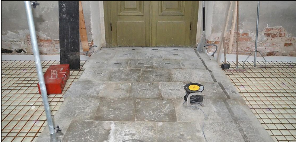
2012-12-12. Mittgången med sina gamla kalkstensplattor och på ömse sidor om denna ett förbeträtt underlag för betongjutning som i sin tur ska utgöra underlag för nya kalkstensplattor.
