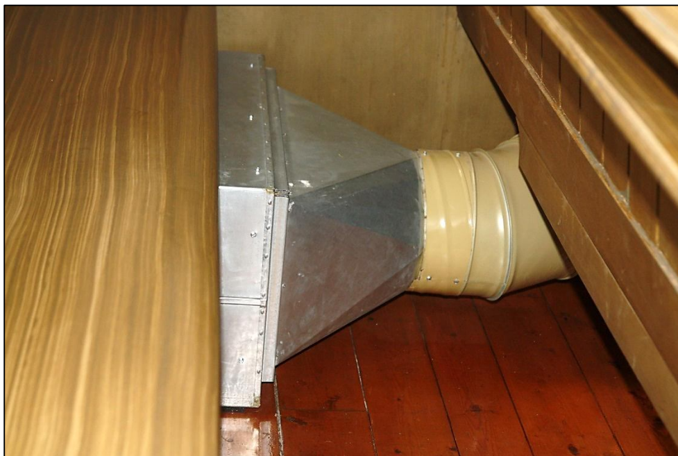
2012-09-07. Anslutning mellan ljuddämpare (till vänster i bild) och rörsystemet för distribution av varmluft (till höger i bild).
