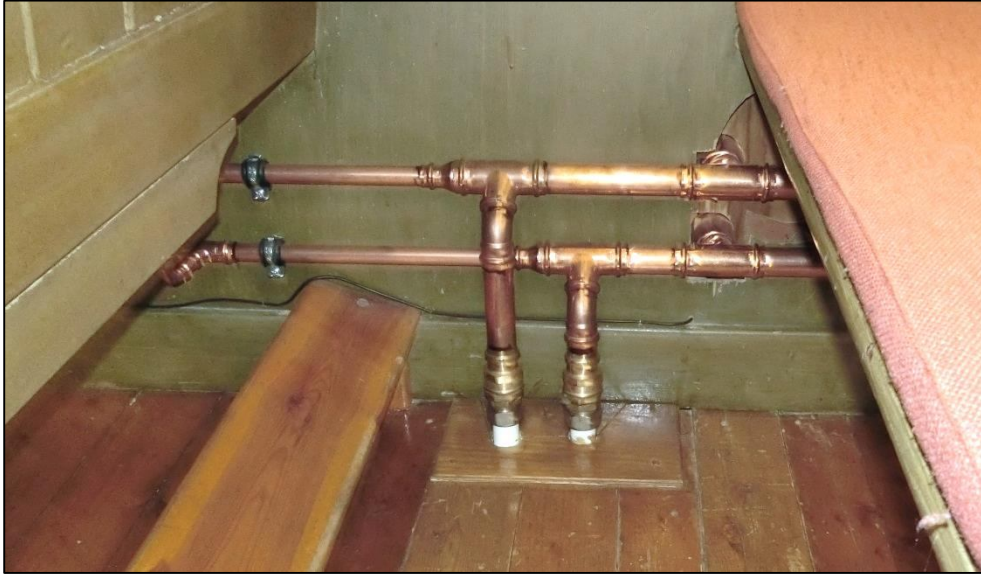
2013-10-25. Röranslutningen till draging under golv har medfört viss åverkan på brädgolvet. Lagning har skett med avfasad träskiva som målats till samma utseende som omgivande golv.
