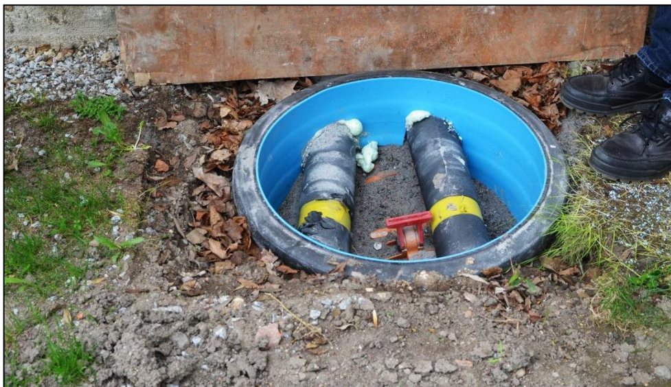
2013-05-21. Ventilbrunn med rören in till sakristian. Locket är utfört i betong.
