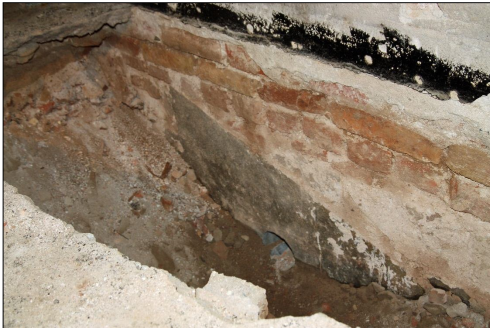
2012-10-16. Utgrävning för håltagning för vatten och avlopp i södra korsarmens sydvästra hörn. Det lilla schaktet visar 1700-talets grundläggning av korsarmen, med en grästensgrund och ovanpå denna en bärande mur av handslaget tegel.
