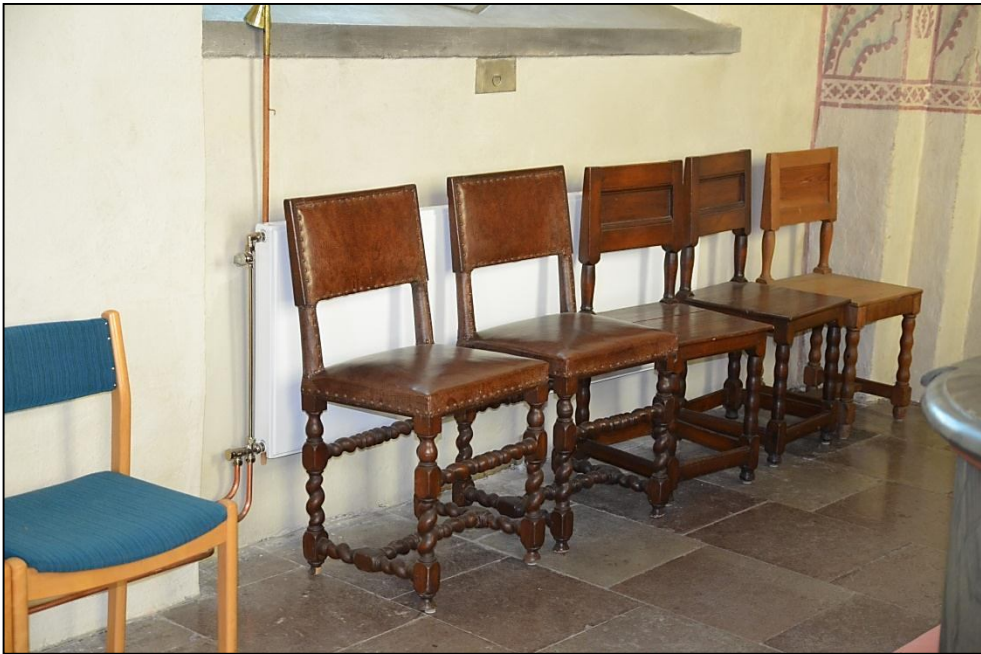
2013-04-29. Radiator i korets norra del.
