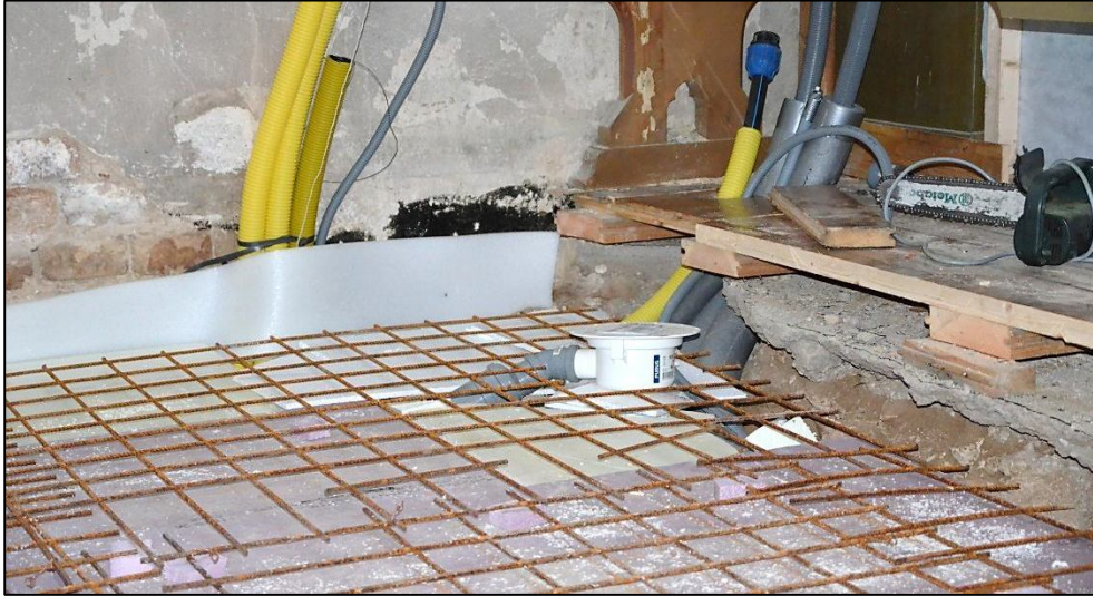
2012-12-12. Det blivande pentryutrymmet med rördragnig för avlopp, vatten, el och värme. Ett armeringsnät har lagts på en cellplastskiva för gjutning av betongunderlag till nya kalkstensplattor.
