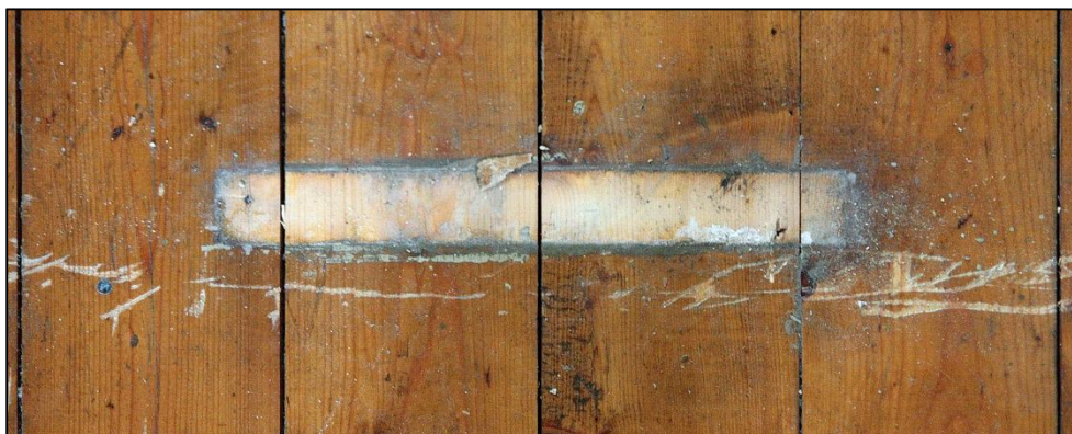
Den obehandlade ytan i bänkkvarterens golv, som bara finns där bänkarna stått, visar att brädgolvet här kan ha tillkommit i samband med ombyggnaden av bänkkvarteren 1937. Då ändrades nämligen avståndet mellan bänkarna.
