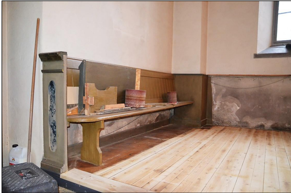
2013-01-30. Slipning av befintligt trägolv i norra korsarmens nordöstra del efter demontering av bänkar.
