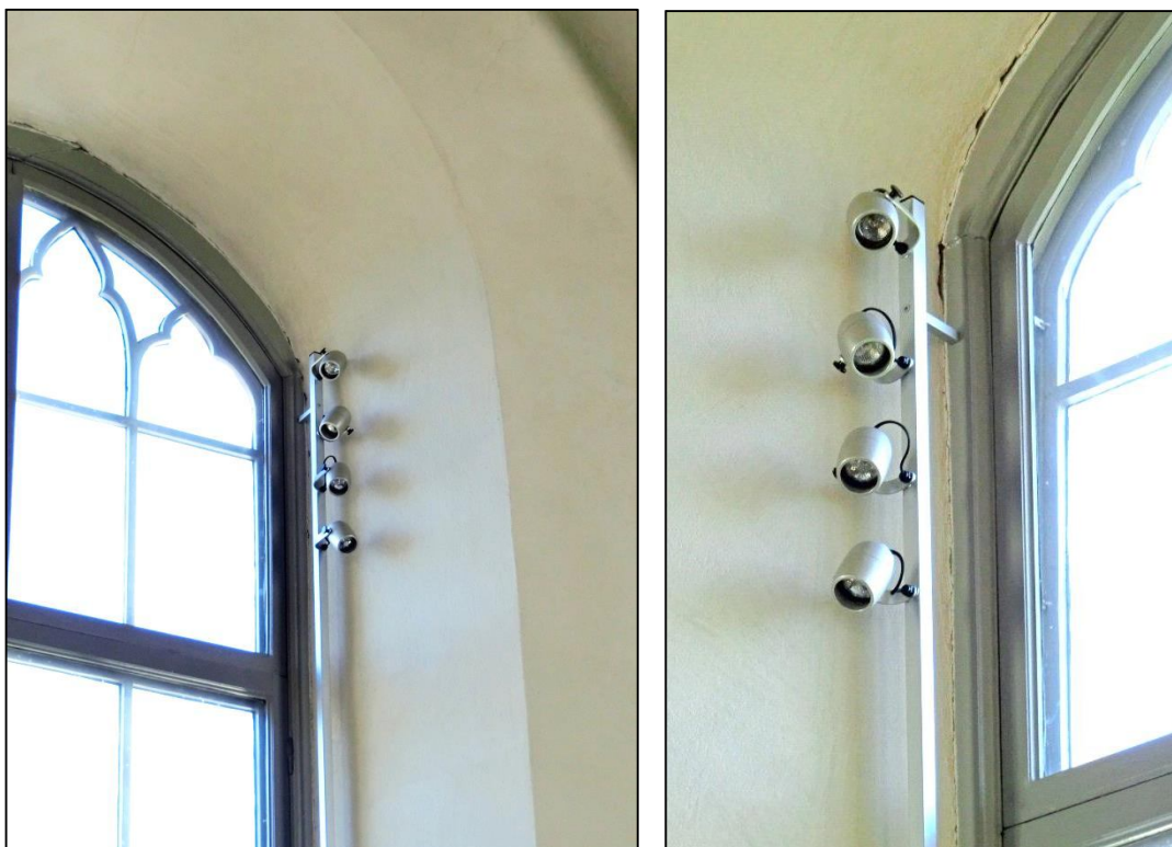
2013-10-25. Spotarmaturer modell Gadget monterade på skena inne i fönsternischen till södra korsarmens fönster.
