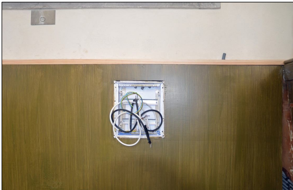
2013-03-20. Plats för ny elcentral till pentrydelen bakom plywoodpanelen mot korsarmens västra vägg.
