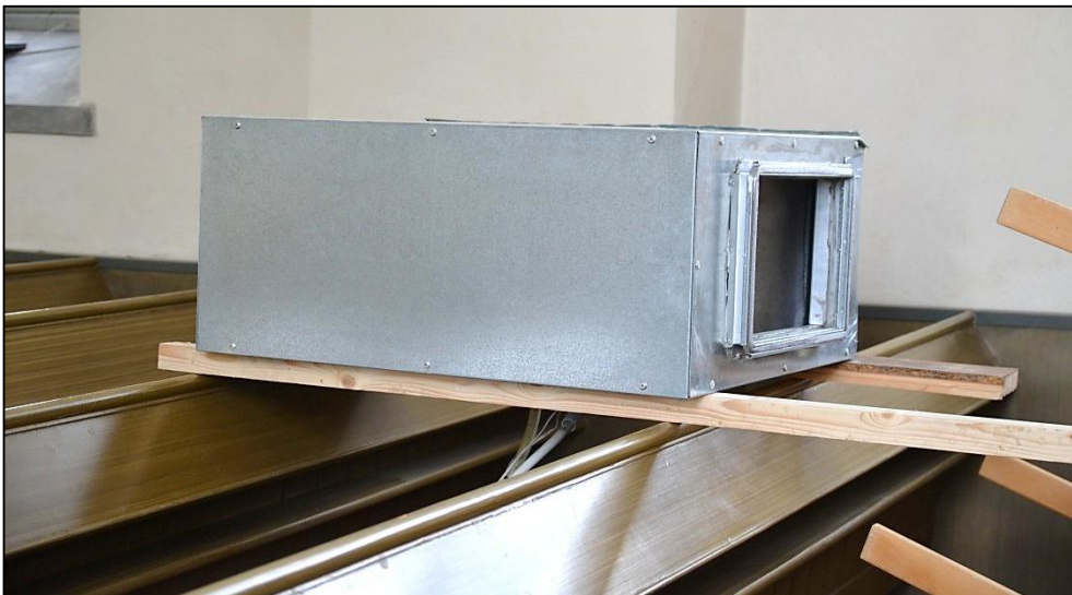
2013-02-27. Demonterad ljuddämpare. Den ansenliga storleken framgår i relation till bänkarna.
