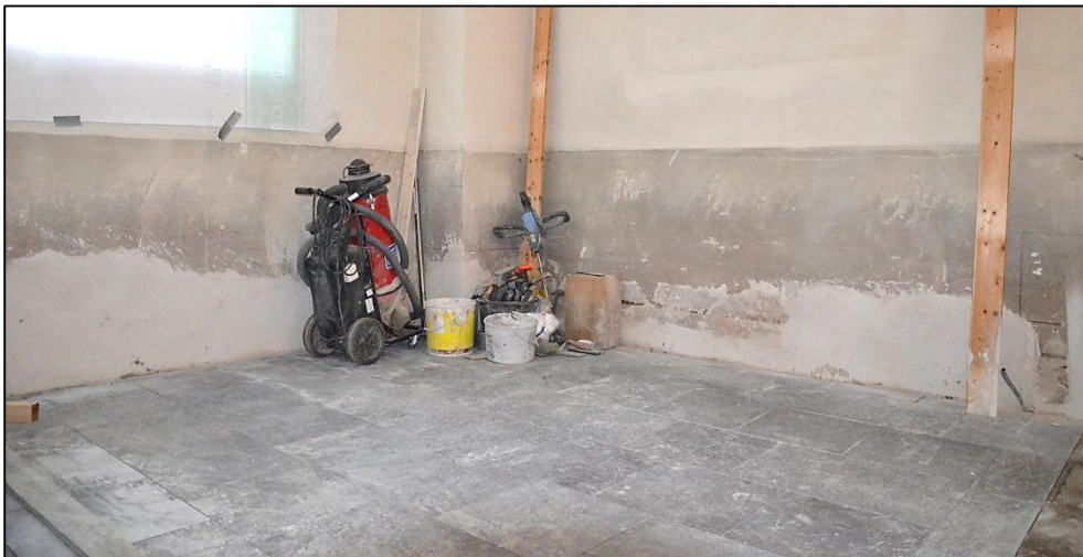
2013-01-30. Det östra utrymmet med färdiglagt kalkstengolv. Murytorna har rengjorts och putslagats.
