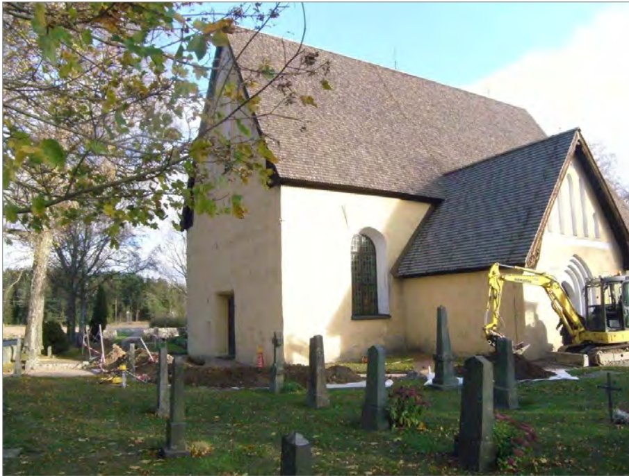
Figur 23. Arbetsbild. Schaktning vid kyrkans SV del. Foto mot N.
