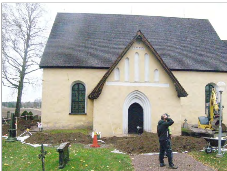
Figur 8. Arbetet för dagvatten vid Ärentuna kyrka. Här ses schakten framför vapenhuset. Foto mot N.
