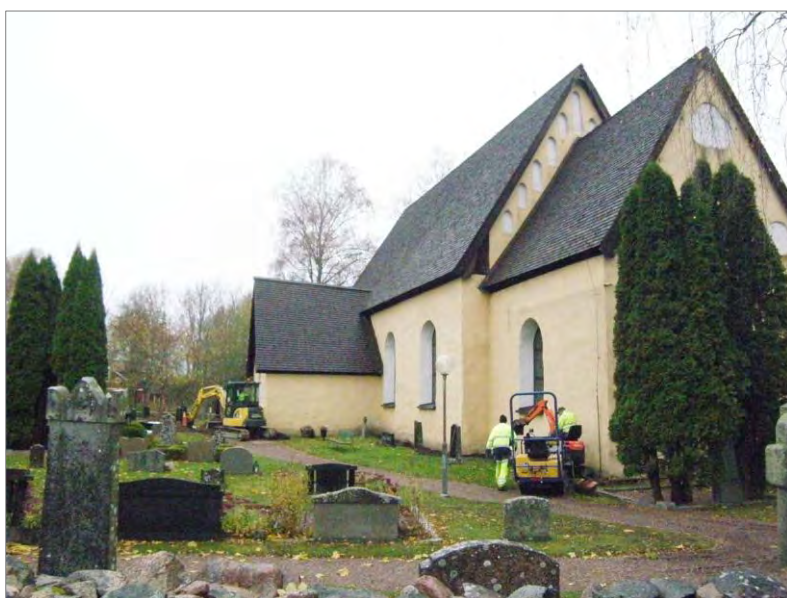
Figur 7. Arbetet för dagvatten vid Ärentuna kyrka. Foto mot V.
