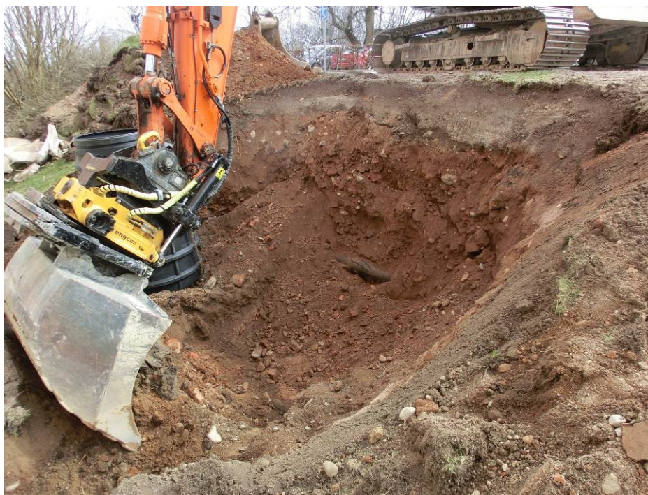
Figur 7. Pågående schaktning för fettavskiljare (två brunnar). I schaktets bakkant syns den fjärrvärmeledning som grävts ner vid tidigare tillfälle. Foto öster 2015-04-08, Bent Syse Upplandsmuseet.
