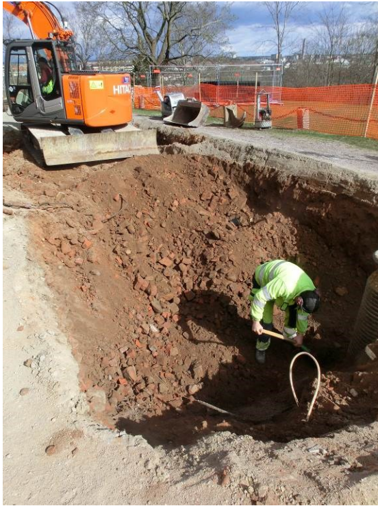
Figur 8. I samband med schaktningen för infiltrationsanläggningen (schakt 4) framkom omfattande fyllning av tegelkross uppblandat med sand och grus. Foto mot nordost 2015-04-16, Bent Syse Upplandsmuseet.
