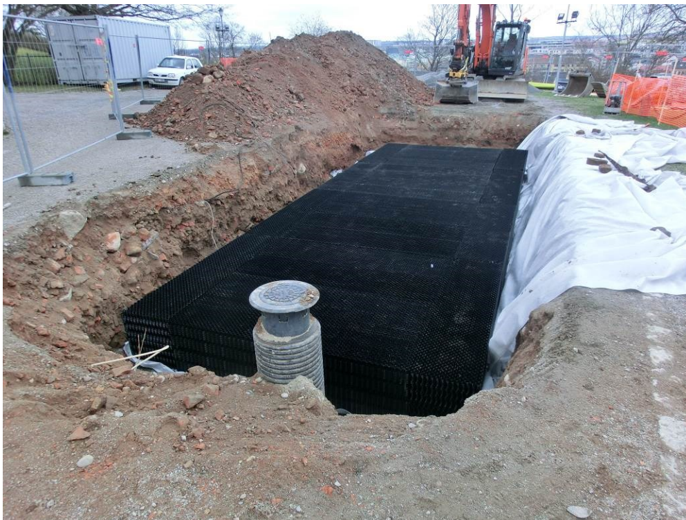
Figur 9. Infiltrationsanläggningen placerad i schakt 4. Foto mot nordost 2015-04-17, Bent Syse Upplandsmuseet.
