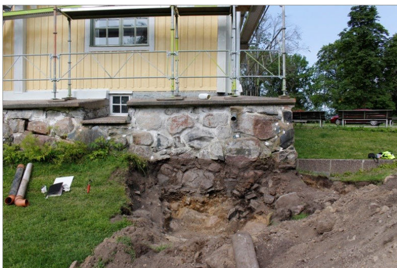
Figur 12. Provgrop 1 färdiggrävd. Södra gavelns grundmur låg direkt ovan naturlig mark och var klen uppbyggd under mark. Foto 2015-07-13 mot norr.
