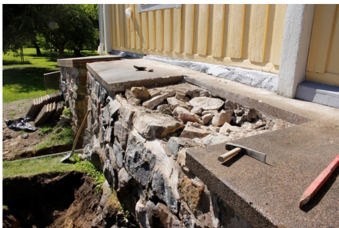
Figur 17. Uttag ur murens betongplatta. Direkt under betongen fanns murbruk som sannolikt använts för att fästa betongplattan. Foto 2015-08-17 mot sydsydväst.
