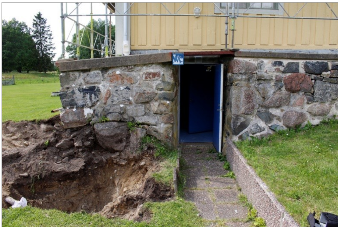
Figur 13. Provgrop 1 grävdes även ca 2 m längs den östra långsidan. Sättningen i grundmuren syns tydligt och under murens sydöstra hörn fanns i princip ingen grundläggning. Foto 2015-07-13 mot väster.
