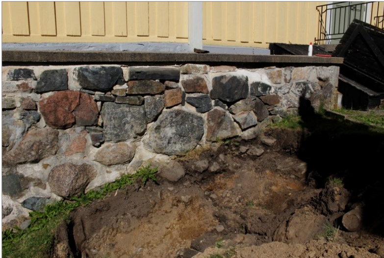
Figur 15. Provgrop 3 visade på en liknande uppbyggnad och lagerföljd som i provgrop 1. Foto 2015-08-17 mot nordväst.
