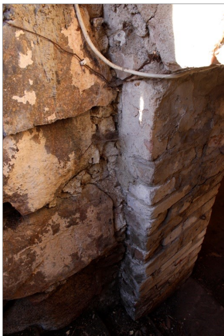
Figur 11. Foto taget i nedgången till det mittersta av de medeltida källarvalven. Här syns tydligt hur den yttre muren (t.v.) är byggd upp mot den medeltida källarmuren (t.h.). Foto 2015-08-17.
