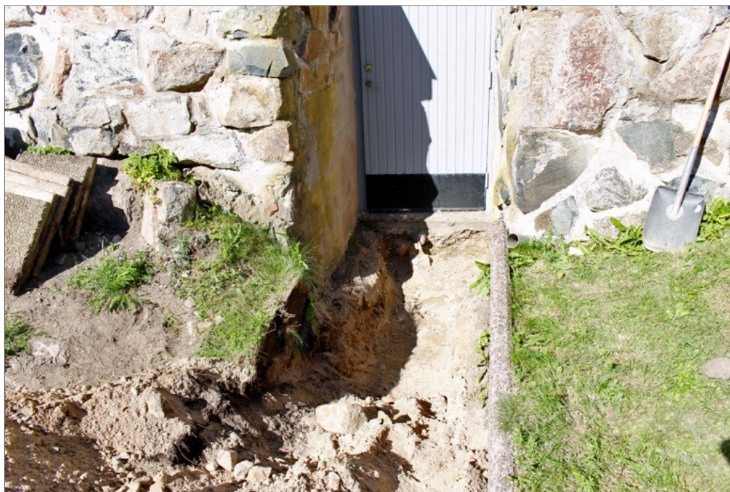
Figur 14. Provgrop 2 grävdes i ingången till WC-utrymmet. Foto 2015-08-17 mot väster.
