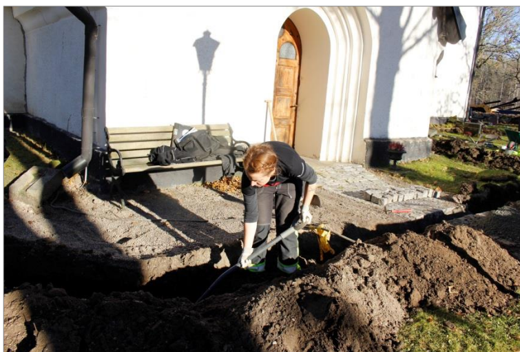
Figur 12. Vid vapenhusets södra del gjordes försök att hitta de murrester som framkom vid 1950 års grundförstärkningar. En provgrop grävdes för hand vid vapenhusets sydvästra hörn. Gropen grävdes va 0,7 m djup men inga murrester påträffades här. Foto mot NÖ. Anna Ölund, Upplandsmuseet.
