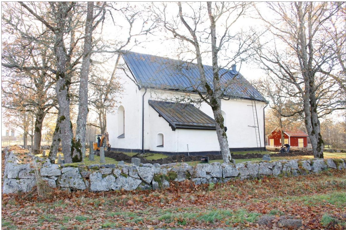
Figur 8. Pågående markarbeten vid Ålands kyrka i oktober 2015. Foto mot SV.
