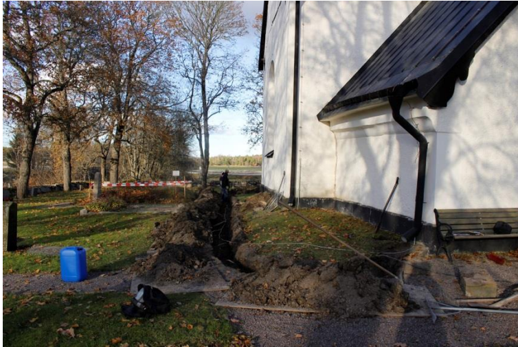
Figur 11. Längs hela sträckan vid västgaveln fanns rikligt med raseringsmaterial i form av tegel- och kalkbrukskross och större bitar. Här påträffades även mot schaktets botten tre stenar, ca 0,2-0,3 m stora i toppen. Foto mot N.
