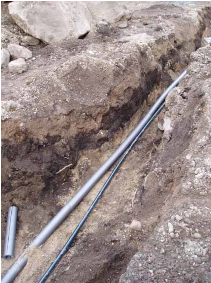
Figur 3. Detalj av ledningsschaktet. Ovanpå den ljusa sjösanden syns det mörka kulturlagret med en tjocklek av ca 0,3 meter.
