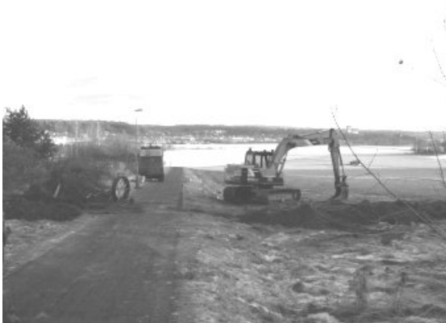
Figur 3. Översiktsbild från plåtåns övre del ut mot dalgången där kabelschaktningen tog sin början i anslutning till en cykelbana. Just i det här området påträffades anläggningar och kulturlager under matjorden. Foto från väster.
